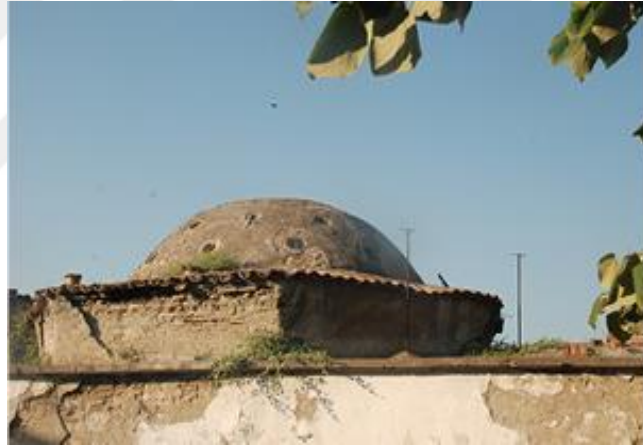
Fotoğraf 220: Pekmezpazarı Hamamı, kubbe örtü ve öküzgözü pencereler
