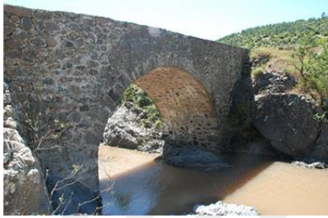
Fotoğraf 262: Kırkgeçit Köprüsü, genel görünüş
