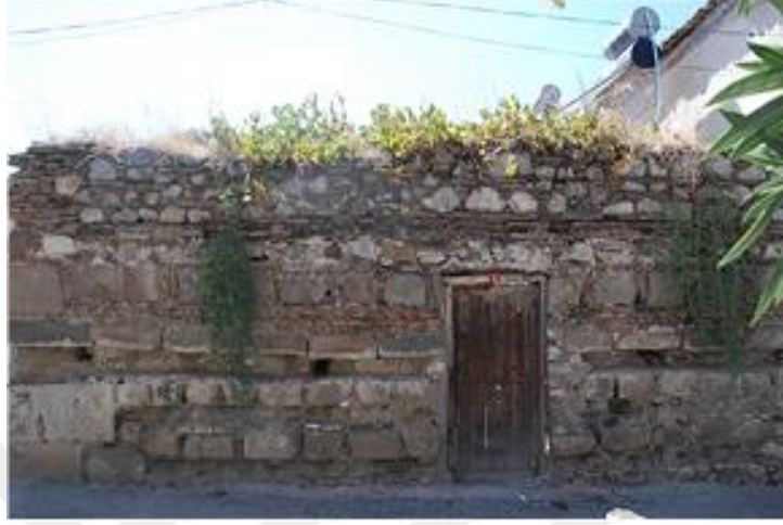
Fotoğraf 228: Poyracık Yıldırım Hamamı, dış cephe
