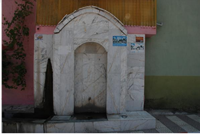
Fotoğraf 247: Poyracık Çeşme -I (Bekmezcioğlu Çeşmesi), genel görünüş
