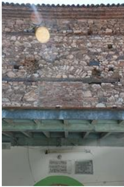
Fotoğraf 10: Tahtalı (İbrahim Ağazade) Camii, kuzey cephede kaldırılan son cemaat yerine ait bağlantı izler.
