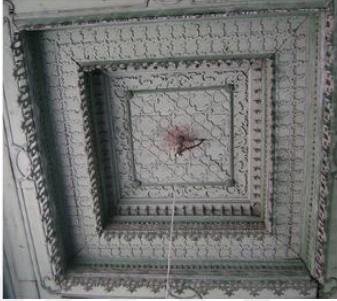
Fotoğraf 92: Çarşı (Karaosmanoğlu) Camisi, son cemaat yeri tavanında ahşap süslemeli çökerme, Restorasyon (2013-14 )'dan önceki durumu (Ş. Altunoğlu 2007)
