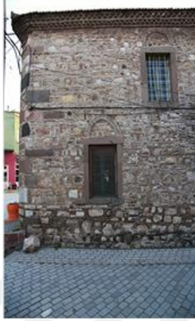
Fotoğraf 72: Çarşı (Karaosmanoğlu) Camisi, taş-tuğla duvar örgüsü (Ş. Altunoğlu 2007)
