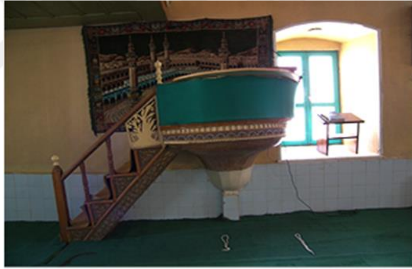
Fotoğraf 103: Çarşı (Karaosmanoğlu) Camisi, vaaz kürsüsü Restorasyon (2013-14 )'dan önceki durumu (Ş. Altunoğlu 2007)
