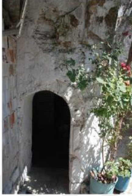
Fotoğraf 236: Poyracık Yıldırım Hamamı, halvet hücresi kapısı
