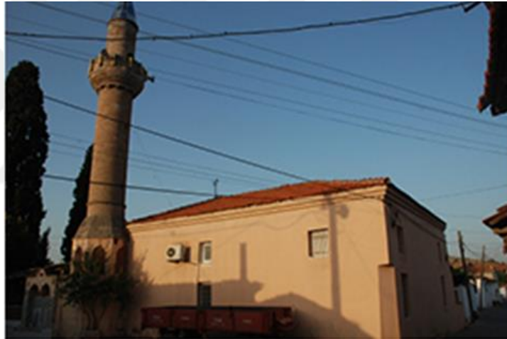
Fotoğraf 132: Poyracık Yeni Cami (Ayşe Hatun Mescidi), genel görünüş
