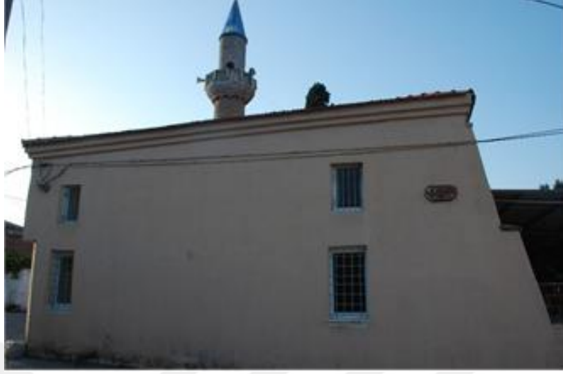
Fotoğraf 133: Poyracık Yeni Cami (Ayşe Hatun Mescidi), genel görünüş
