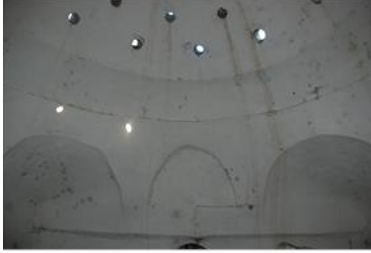
Fotoğraf 225: Pekmezpazarı Hamamı, sıcaklık
