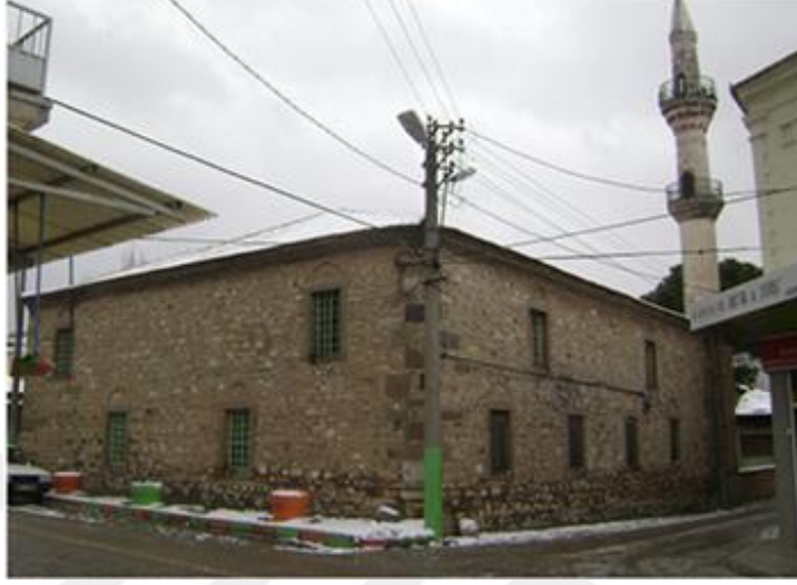
Fotoğraf 66: arşı (Karaosmanoğlu) Camisi, Restorasyon (2013-14) dan önce genel görünüşü (Ş. Altunoğlu 2007)
