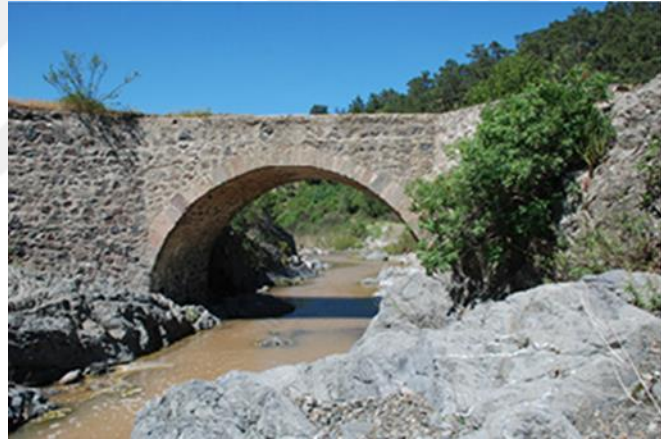
Fotoğraf 263: Kırkgeçit Köprüsü, genel görünüş
