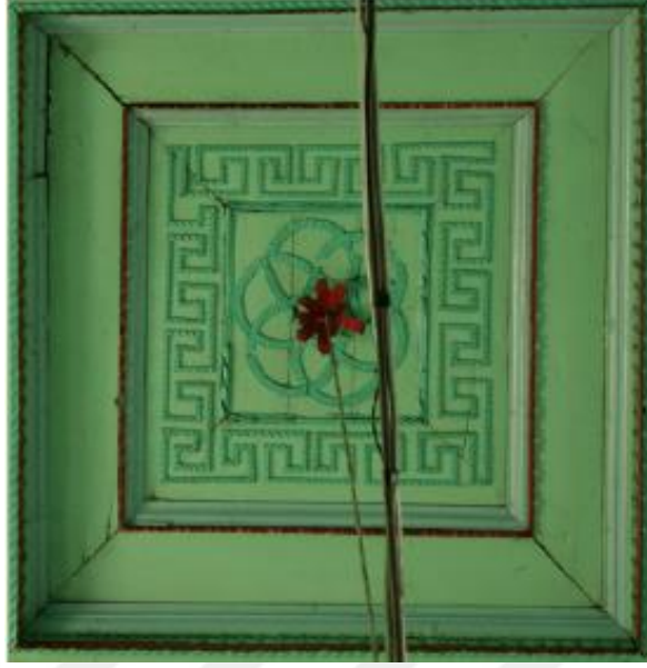
Fotoğraf 52: Pekmezpazarı Camisi, son cemaat yeri, tavanı çökertme (Kaynak: İzmir 2.KVKBK, d. 35.10/116)
