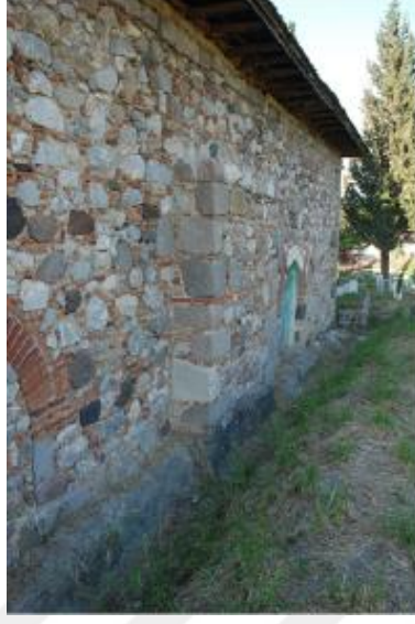
Fotoğraf 152: Sucahlı Köyü Camisi, taş-tuğla inşa malzemesi, mihrap çıkıntısı
