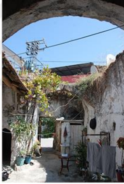
Fotoğraf 233: Poyracık Yıldırım Hamamı, sıcaklık örtüsüz vaziyeti
