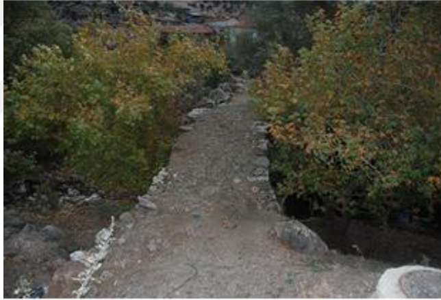
Fotoğraf 265: Elmadere Köprüsü, döşeme kısmından görünüş
