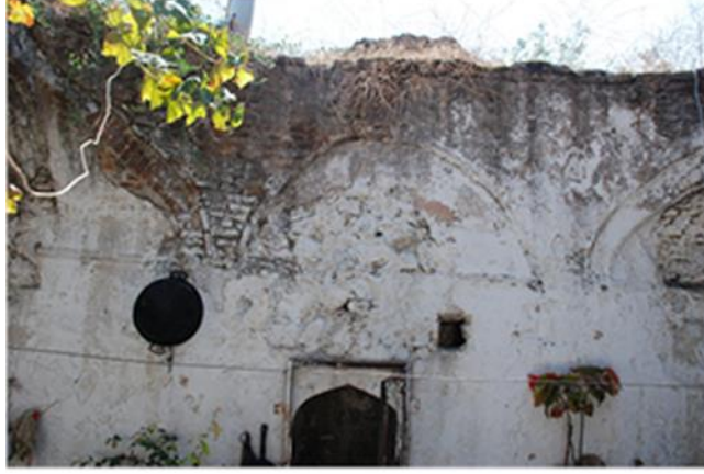
Fotoğraf 232: Poyracık Yıldırım Hamamı, sıcaklıkta örtüye geçişten izler
