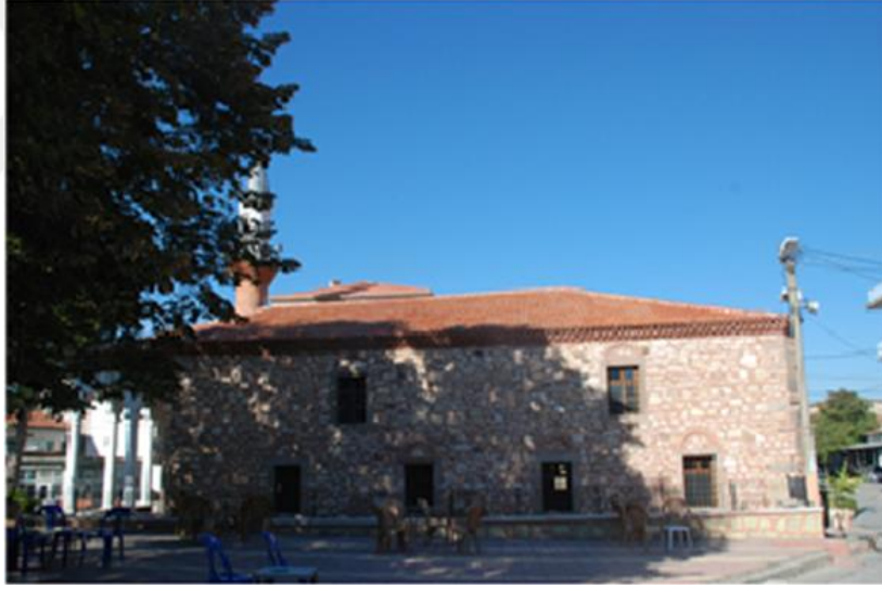
Fotoğraf 71: Çarşı (Karaosmanoğlu) Camisi, yan (güneybatı) cephesi genel görünüş
