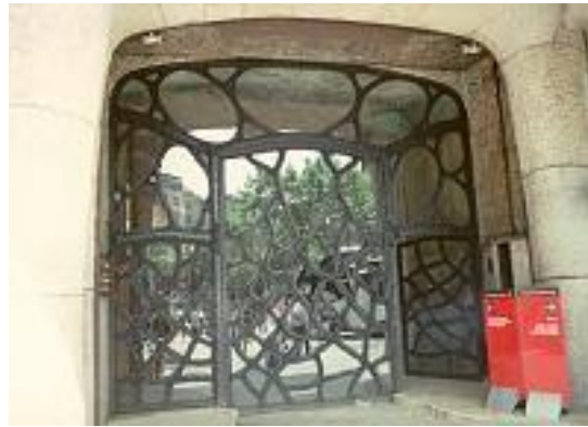
Şekil 4. 29 : Casa Mila, Demir ve aynanın teknik birleşimi, Barselona, A. Gaudi (Sembach,1984)
