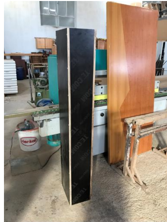
Şekil 3.9. Kolon kalıbı imalatı
