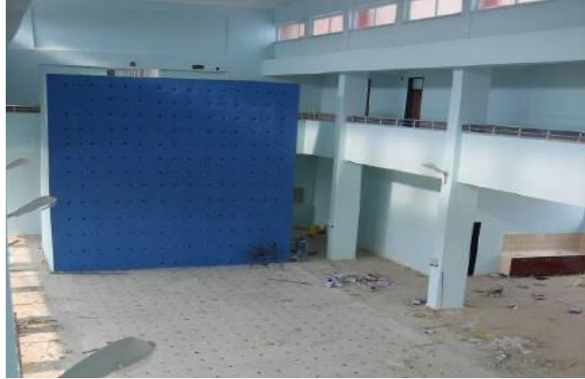
Şekil 3.18. KTÜN, Deprem Laboratuvarı reaksiyon duvarı ve döşeme (Balık, 2012)
