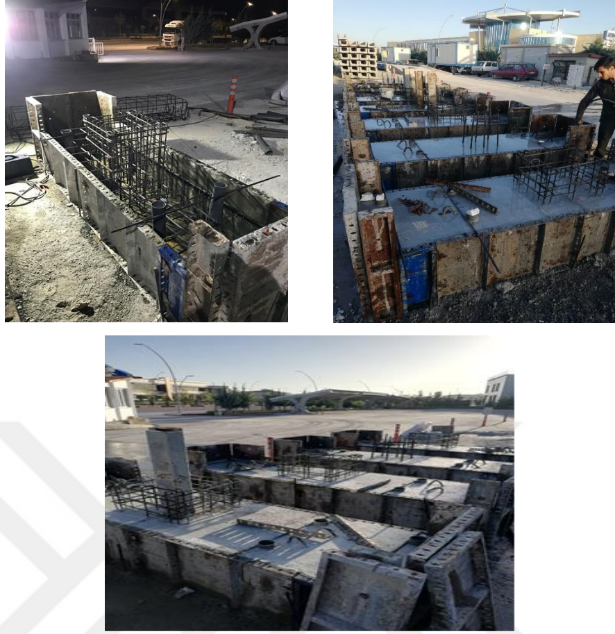
Şekil 3.8. Soketli temel üretim aşamaları
