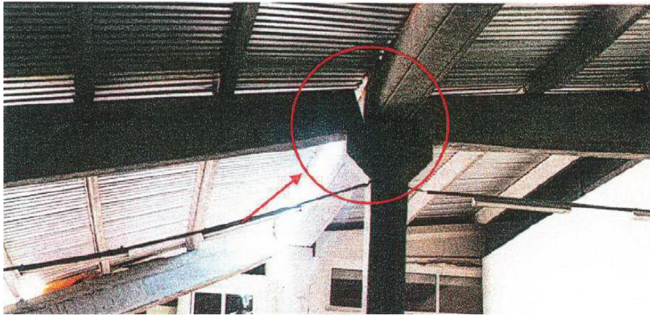
Şekil 1.11. Kirişlerin oturduğu konsoldan yana devrilmesi (Akçaözoglu, 2003)
