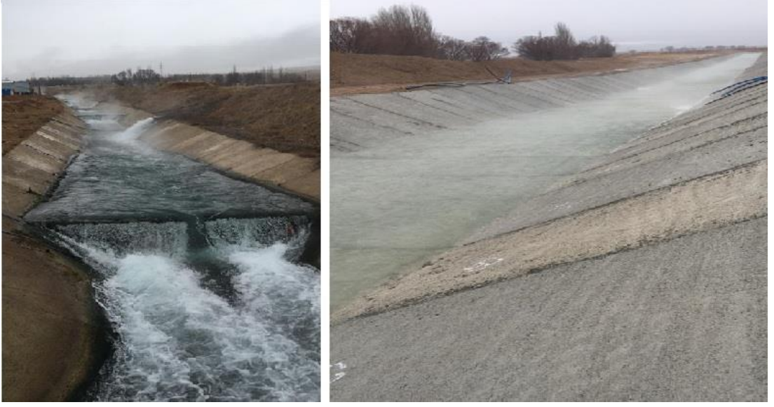
Şekil 5.1. AEL’de drene edilen suların aktarıldığı işletme kanalı.
