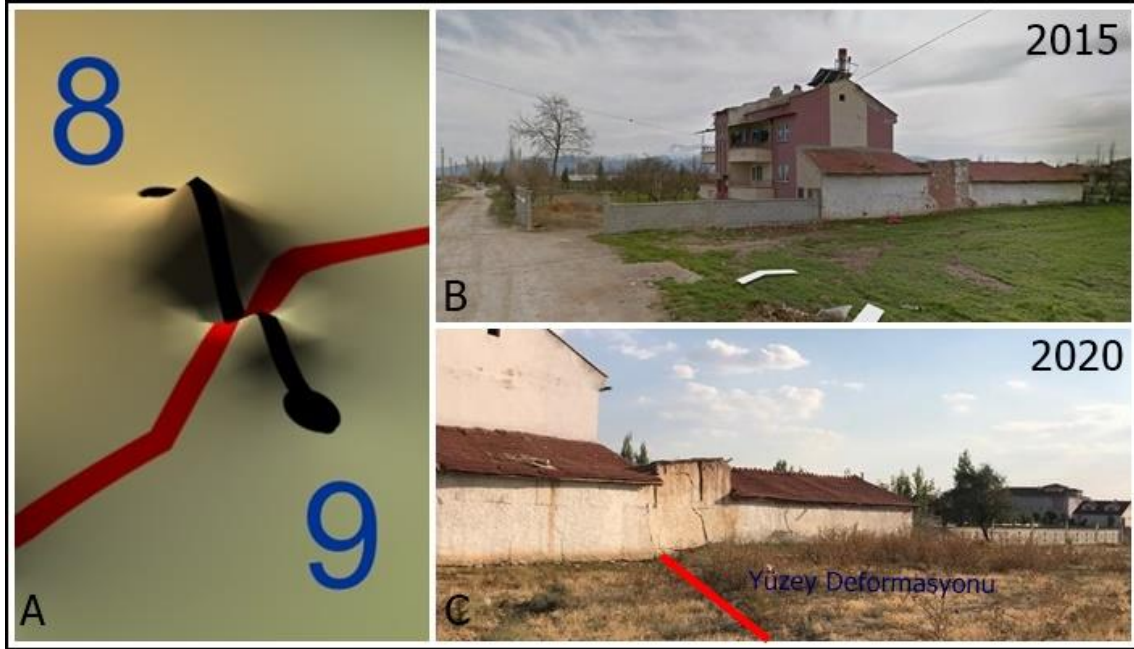
Şekil 4.21 A ile gösterilen gösterilen fotoğraf 2016-2020 deformasyon miktarının 3 boyutlu gösterimi, B ile gösterilen fotoğraf 9'nolu güzergâhtaki bir yapının 2015 yılına ait fotoğrafı, C ile gösterilen fotoğraf 9'nolu güzergâhtaki bir yapının 2020 yılına ait görüntüsü (C ile gösterilen fotoğrafta kırmızı çizgi yüzey deformasyonunu temsil etmektedir.).
