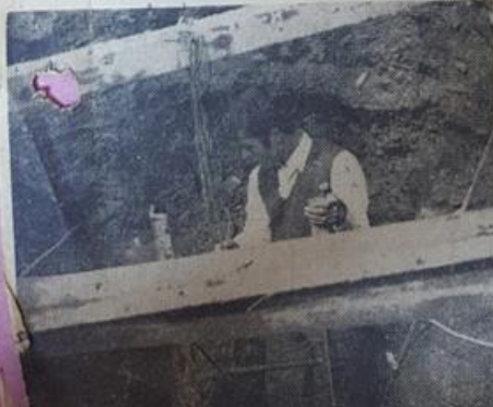
Yerebatan Sarayı'nın sarnıcındaki temel çalışmaları görülüyor.
