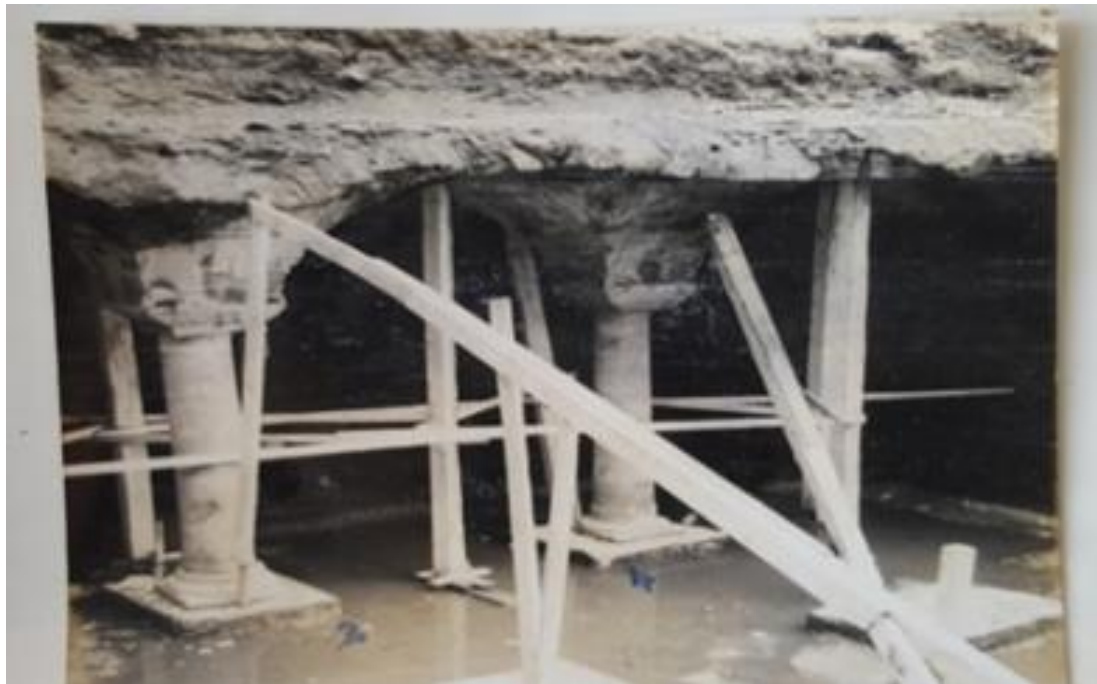
Şekil 4. 29. Sütunların ahşap destek takviyesi ile koruma altına alınması
