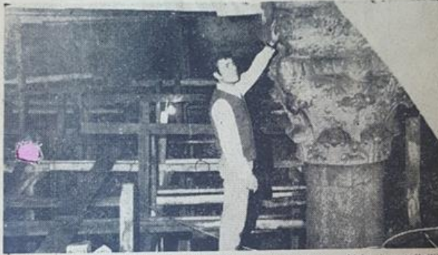
Yerebatan Sarayı'nın delinerek sarnıcı içine atılan temellerden birini inşaat işçilerinden birisi gösteriyor.
