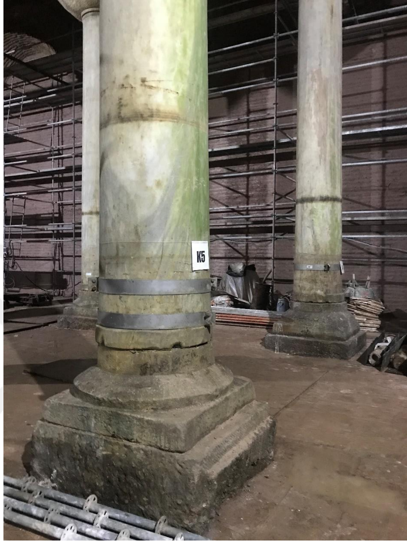
Şekil 4. 82. Uygulama öncesi sarnıç içerisinde kurulan iskeleler
