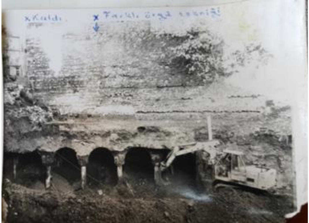
Şekil 4. 31. Yıkılan duvar hafriyatının alımı
