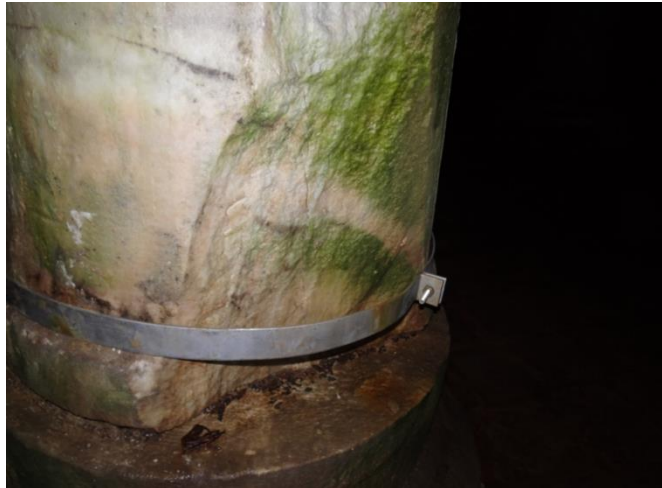
řekil 4. 78. Malzeme kaybı olan stn detayı
