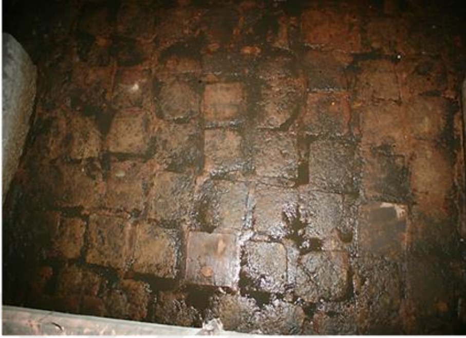
Şekil 2. 27. Zemin tuğla döşeme detayı
