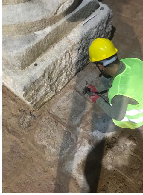
Şekil 4. 90. Tuğla zemin döşeme derz temizliği öncesi
