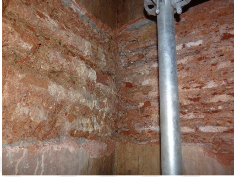
Şekil 4. 88. Raspa uygulama duvar örneği ( Hera Rest. Arşivi )
