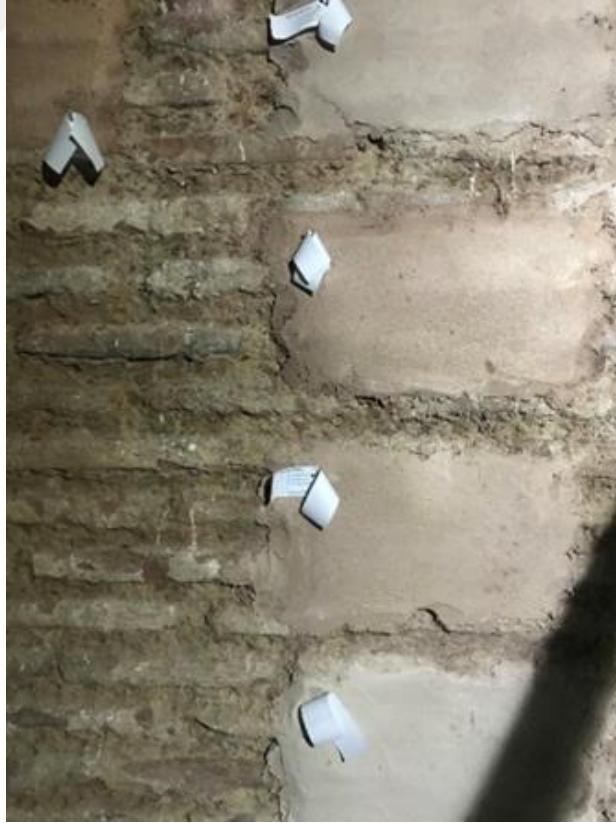
Şekil 4. 97. Yapılan derz ve sıva numuneleri
