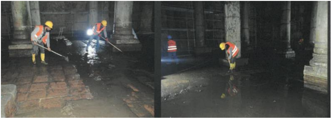
Şekil 4. 72. Suyun tahliyesi çalışmaları ( Hera Rest. Arşivi )
