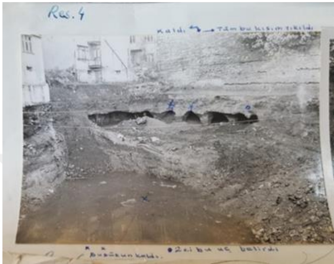
Şekil 4. 28. Hafriyat yapılan alan ve yıkılan duvar
