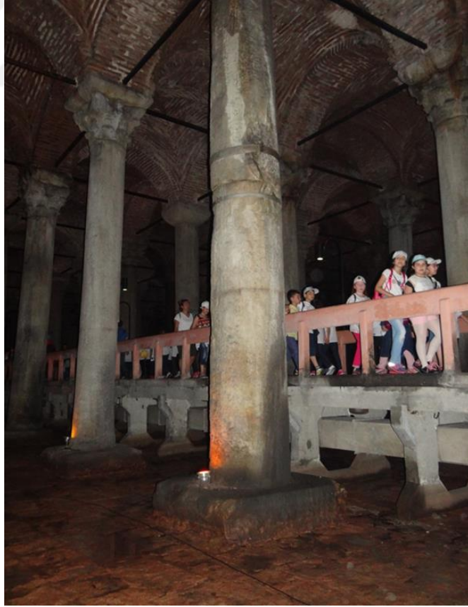
Şekil 4. 80. Şakül kayması olan sütun örneği
