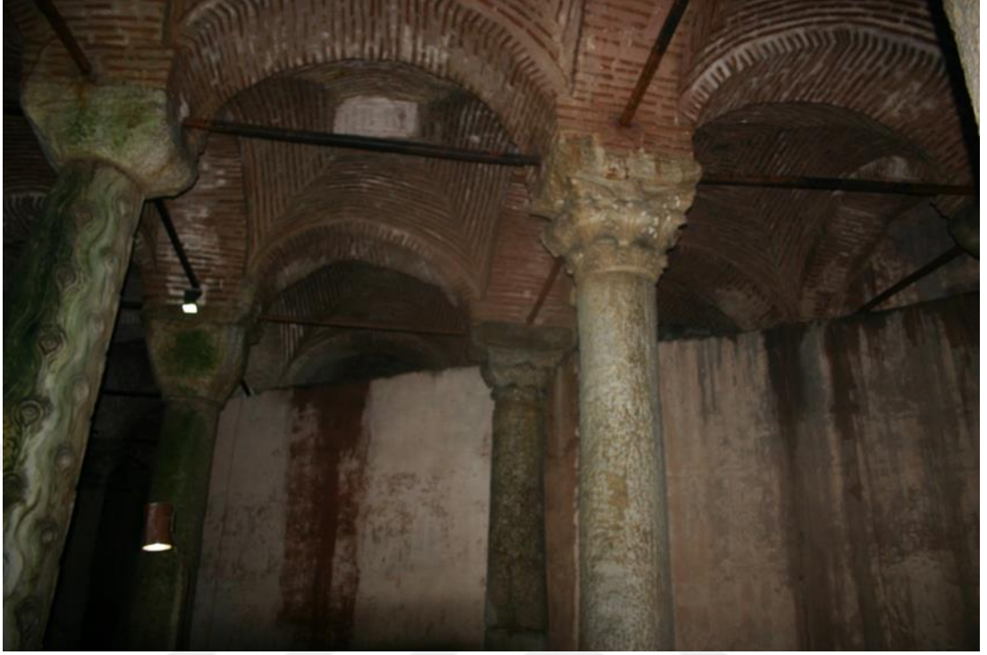
Şekil 4. 85. 2. Abdülhamit döneminde kapatılan duvar (Hera Rest.Arşiv).
