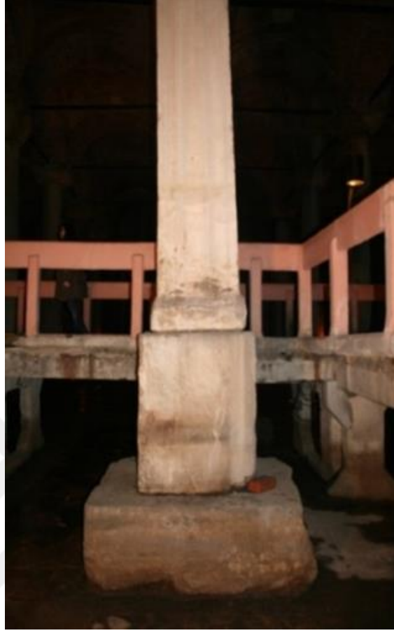
Şekil 2. 38. Alçak kalan sütunun ekleme yapılarak yükseltilmesi örneği
