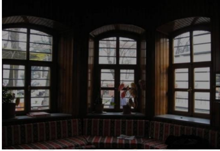
Fotoğraf 53: Trabzon Ortahisar Muvakkithanesi'nin İç Cepheden Pencereilerin Görünümü. 491
