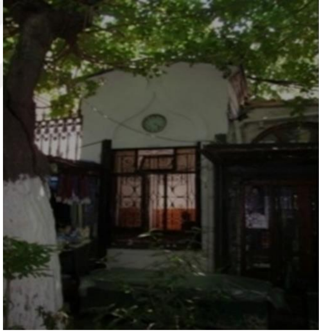
Fotoğraf 29: İzmir Hisar Camii Muvakkithanesinin Ön Cepheden Görünümü. 359
