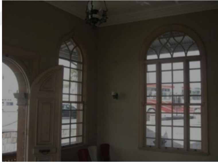
Fotoğraf 35: Muvakkithanenin İç Cephesi. 389
