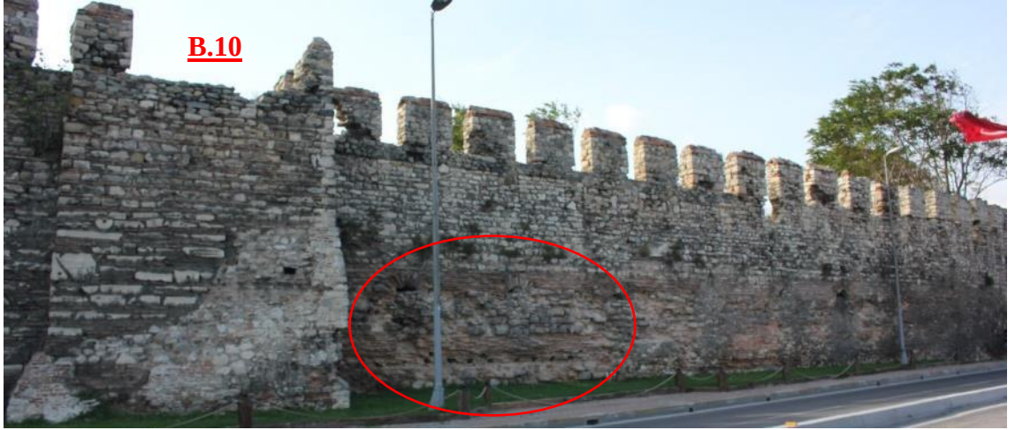
Şekil 3.366 B.10 ile B.11 arasındaki sur duvarında, Bizans dönemi yapı kalıntısının izleri ve üzerindeki Osmanlı dönemi duvar örgüsüne ilişkin genel görünüm (Soyal, 2016).
