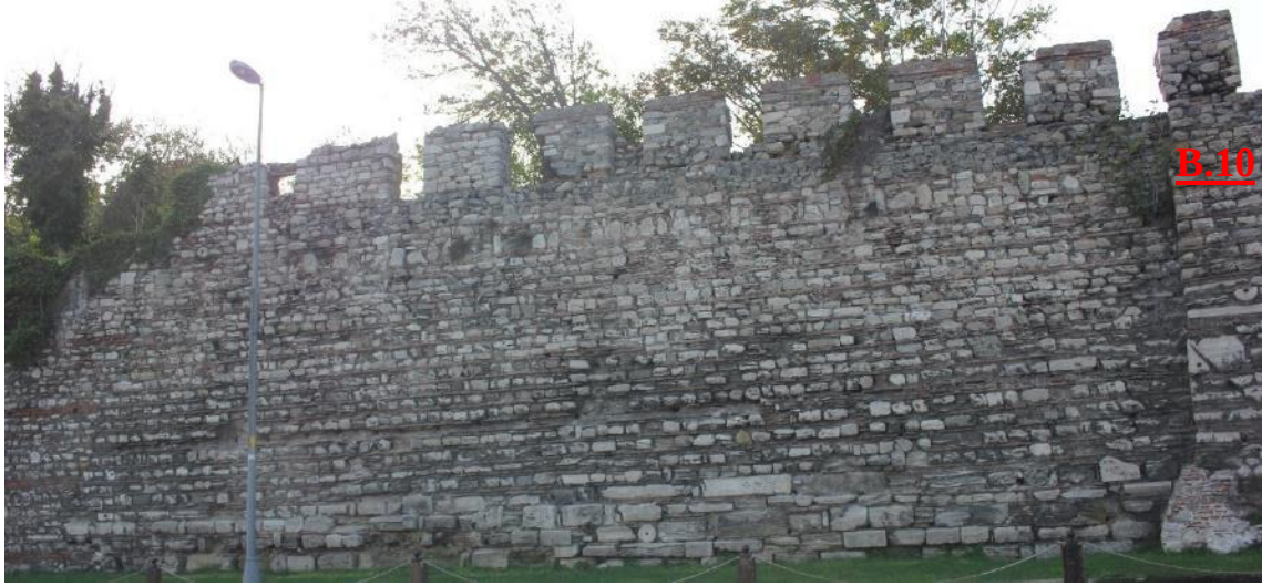
Şekil 3.382 B.9 ile B.10 arasındaki duvar görünümü (Soyal, 2016)
