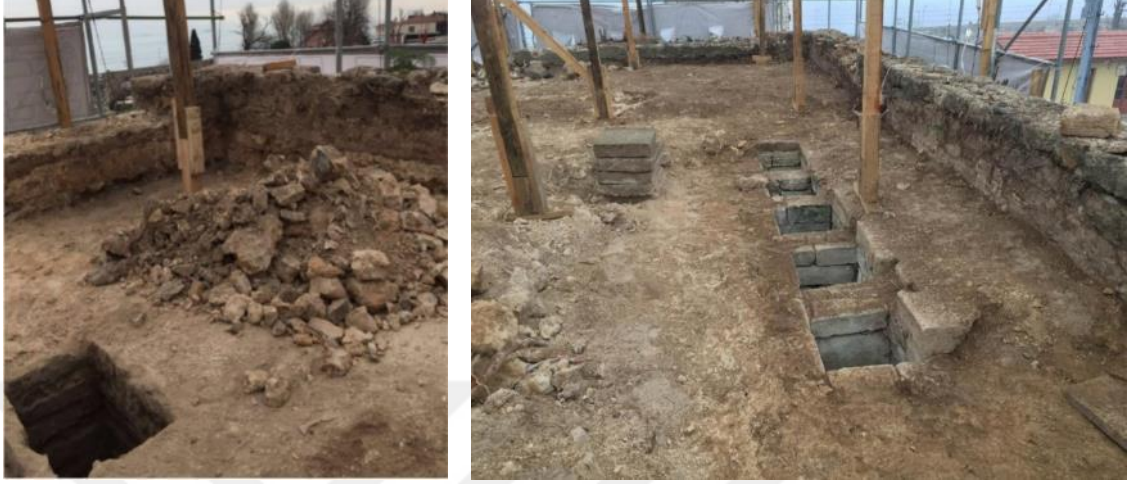
Şekil 3.50. Otluk Kapısının restorasyon çalışmaları sırasında ortaya çıkarılan ocak bacası ve yağ mazgallarına ilişkin genel görünüm (İRAM, 2015).
