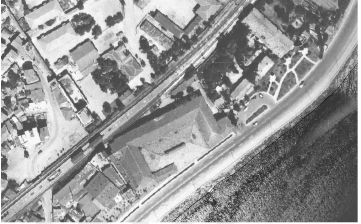
Şekil 3.509 1966 hava fotoğrafında bölgenin detay görünümü (İBB, URL-43). 268
