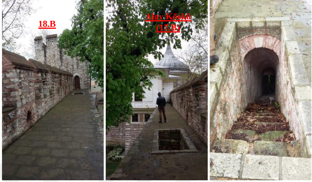
Şekil 3.195. Sur duvarı üzerinde seyirdim yolu, mazgal siperleri, top mazgalları ve merdivenlere ilişkin detay görüntüler (Soyal, 2015). 139
