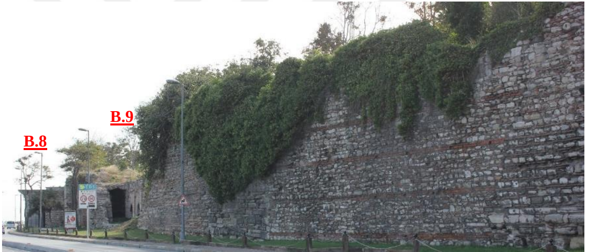
Şekil 3.383 B.9 ile B.10 arasındaki duvar görünümü (Soyal, 2016)
