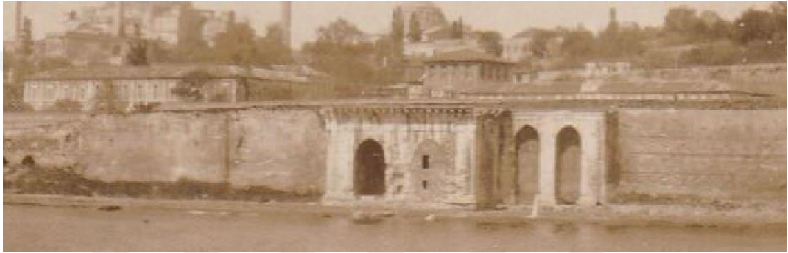
Şekil 3.403 İncili Köşk yapısının 19 yy sonlarındaki görünümü (URL-41)
