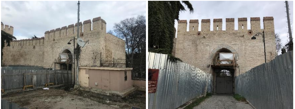
Şekil 3.52. Otluk Kapısının Genel Görünümü, Dış Cephe (Soyal, 2019).
