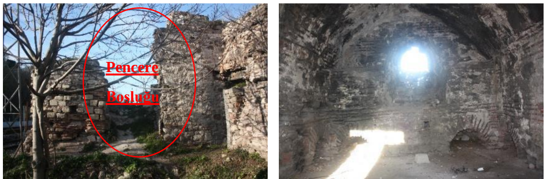
Şekil 3.338 B.13 burcu bitişiğindeki sur duvarı kalıntısı ve burç içi görünümü (İRAM)
