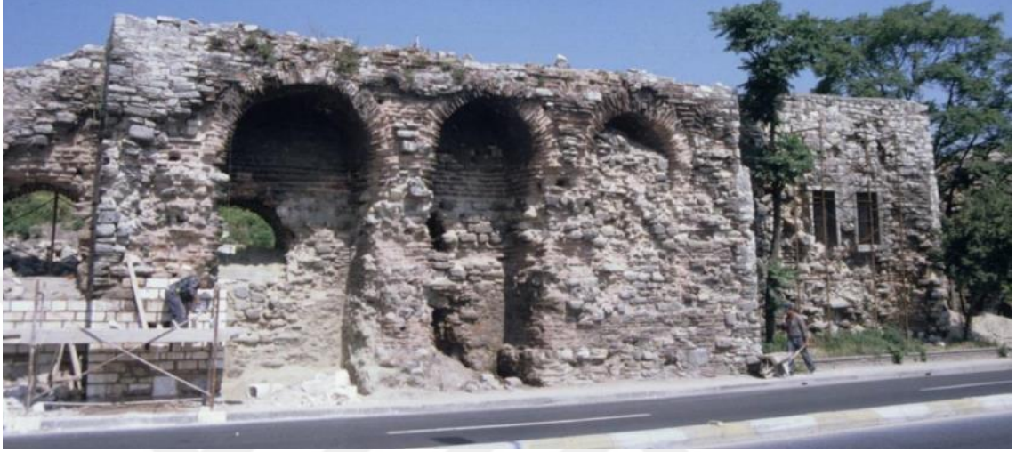
Şekil 3.450 Harap Köşk yapısının restorasyon öncesindeki görünümü (İRAM)
