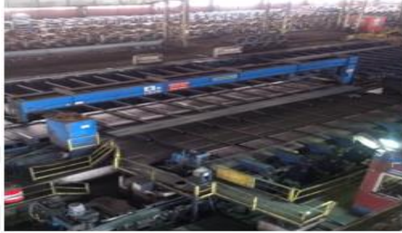
Şekil 2.7. Kontinü haddehane tesisi paketleme ünitesi
