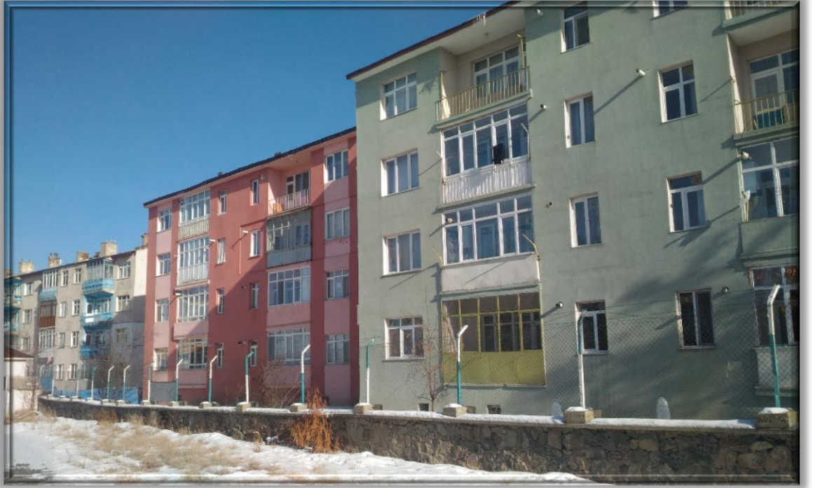
Fotoğraf 2.7. Ilıca Mahallesi'ndeki Betonarme Konutlar
