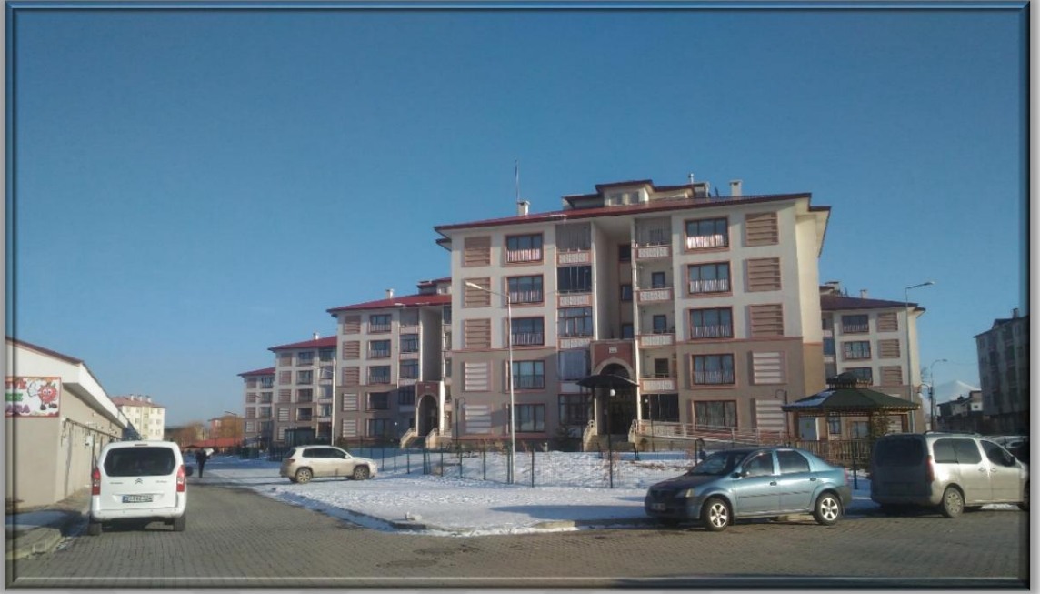
Fotoğraf 2.11. Yeni TOKİ Binalarından Görünüm
