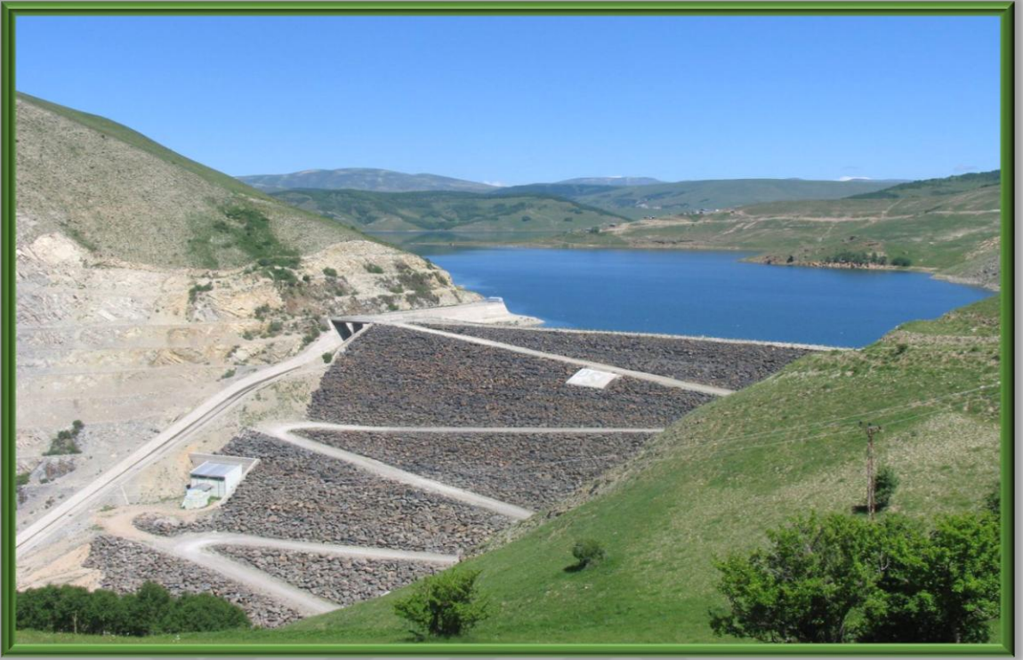
Fotoğraf 1.5. Kuzgun Barajından Bir Görünüm 19
