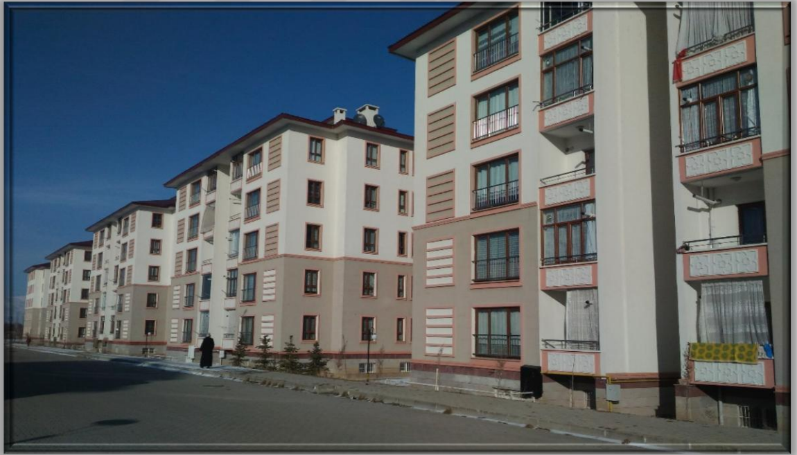
Fotoğraf 2.12. Yeni TOKİ Binalarından Görünüm
