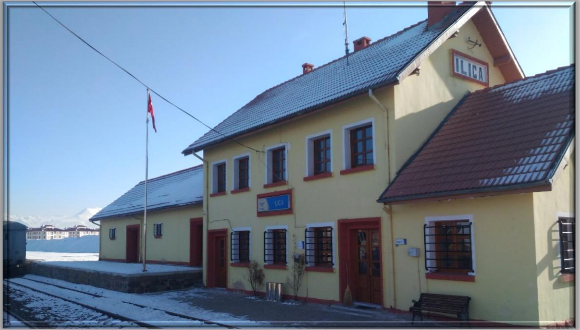
Fotoğraf 3.7. Ilıca Demiryolu İstasyonundan Bir Görünüm
