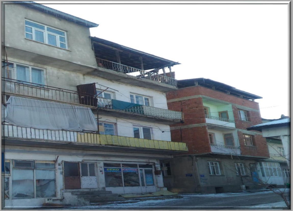
Fotoğraf 2.8. Ilıca Mahallesi'ndeki Eski Konutlardan Bir Görünüm
