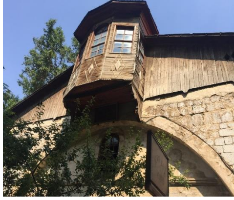
Şekil 52. Kemaliye Evlerinin Başoda Çıkıntısı
