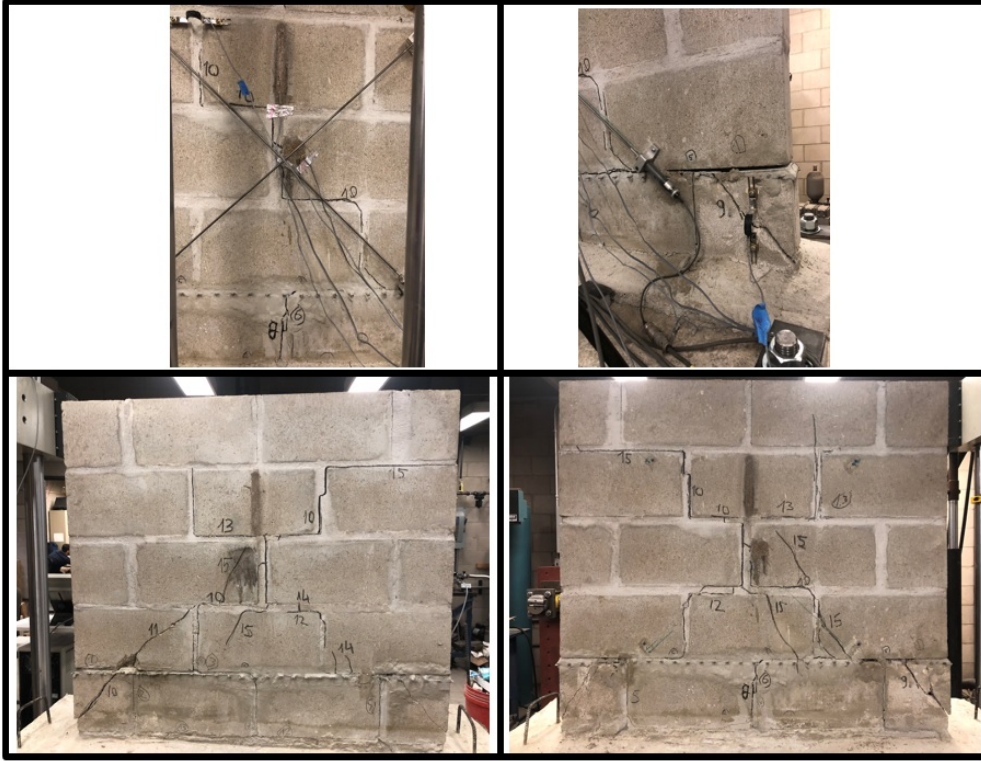
Şekil 3.46 : Duvar BD06’nın hasar tipi.
