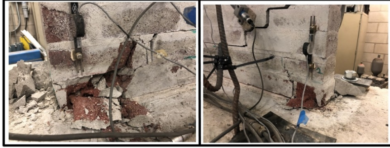
Şekil 3.36 : Duvar TD12 numunesinin alt köşe birimlerinde basınç ezilmesi.
