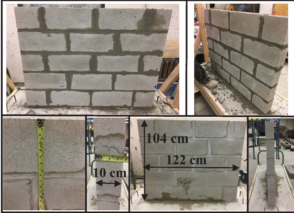
Şekil 3.28 : Beton blok bölme duvar yapımı.
