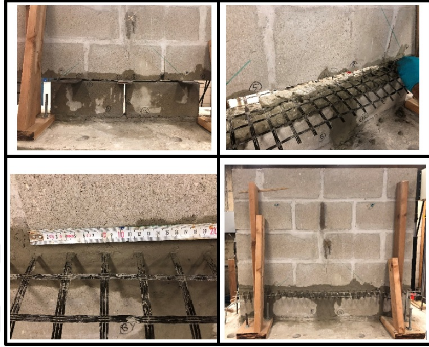
Şekil 3.43 : Kayma hasarı oluşmuş BD02 duvar numunesinin yatay derzinin onarımı.
