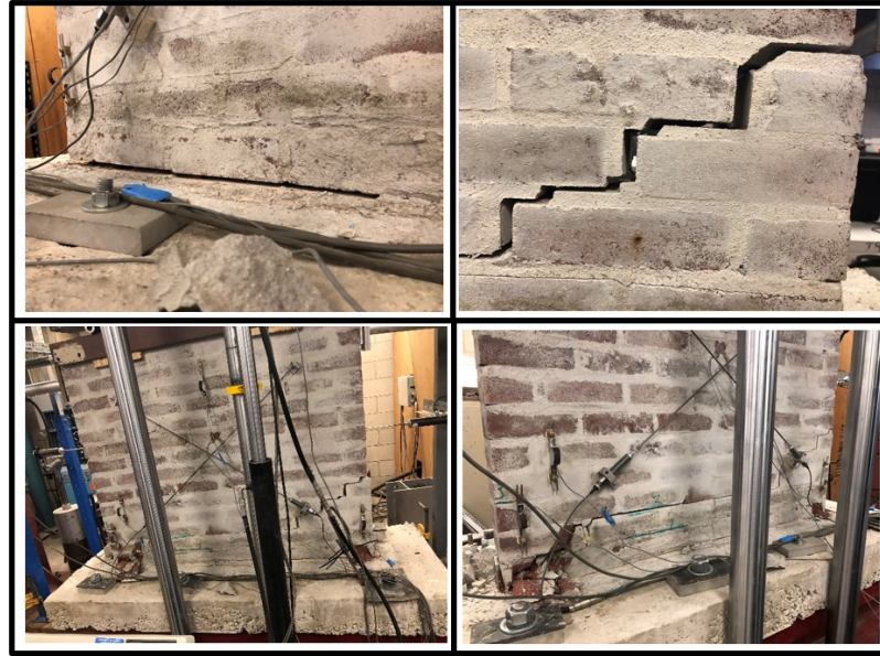
Şekil 3.35 : Duvar TD12’nin hasar tipi.
