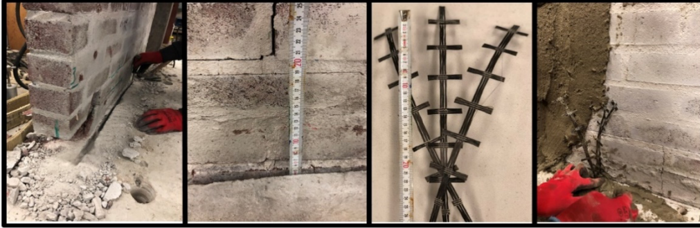
Şekil 3.62 : Duvarın bazalt tekstil kullanılarak temele ankraj işlemleri.
