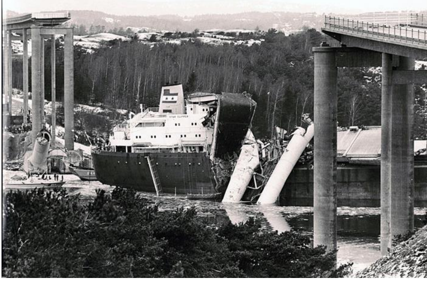
Şekil 2.3: Star Clipper-Tjörn Bridge çatışması.
