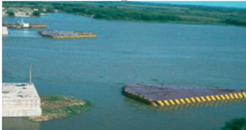
Şekil 2.34: Zarate Braze-Largo Köprüsü, yüzer koruma.
