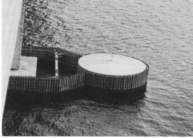
Şekil 2.31: Brezilya'daki Rio-Niterio Köprüsü'nde kullanılan dolfın koruması (Fotoğraf: Niels Jlrger Gimsing).
