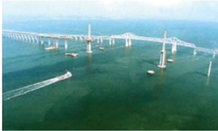
Şekil 2.32: Yeni yapılan Sunshine Skyway köprüsünde dolfın koruması.
