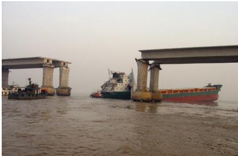
Şekil 2.6: Jintang Bridge Kazası.
