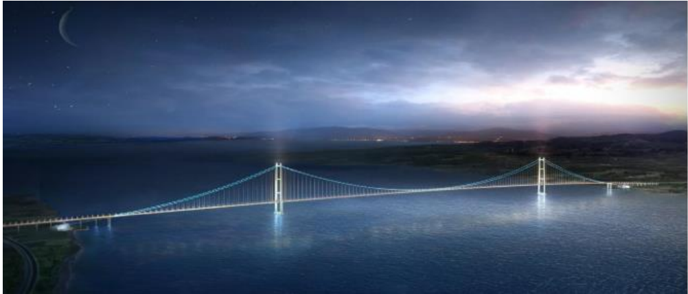
Şekil 2.16: 1915 Çanakkale Köprüsü planlanan gece aydınlatma sistemi.
