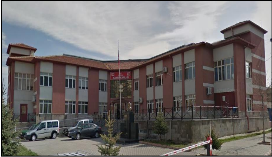
Foto 4.6. Hacilar İlçe Kaymakamlık Binası (Halil KANBUR, 2020)
