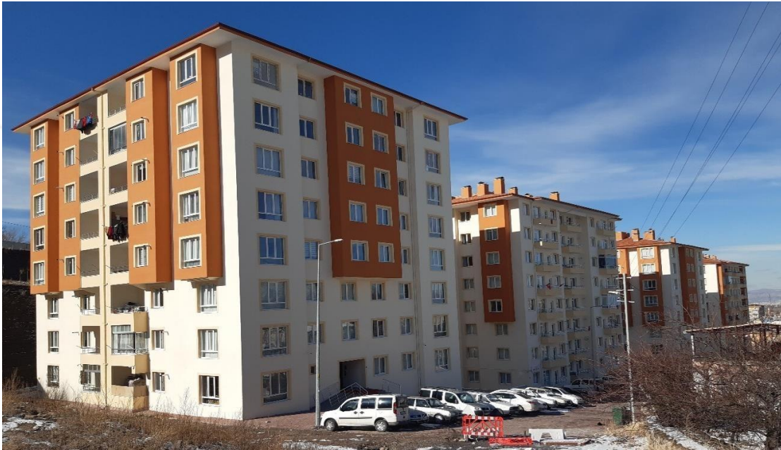
Foto 4.20. Hacılar İlçesi 1. Etap 200 Konutun Tamamlanmış Hali (Halil KANBUR,2020)
