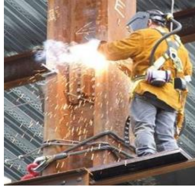
Resim 2.9 Küt kaynağın kolon ekine uygulanması.
