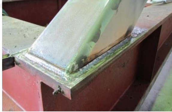
Resim 2.11 Açılı köşe kaynak uygulaması.
