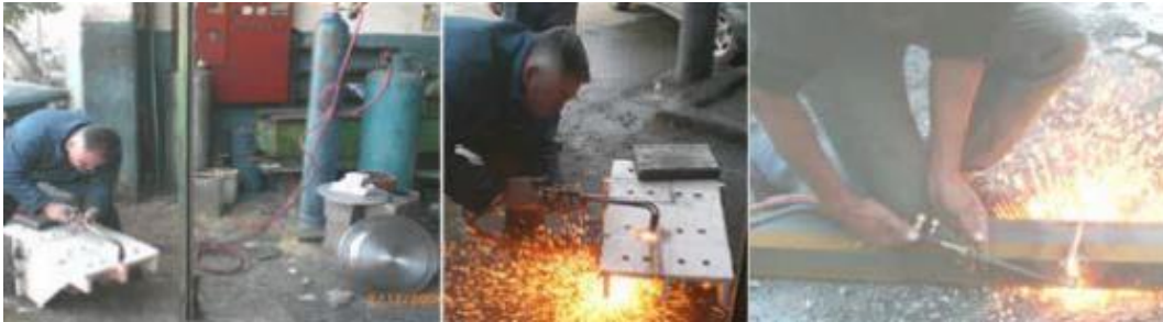
Resim 2.3 Oksii-asetilen kaynağı ile metal kesimi işlemi (Tama 2009).
