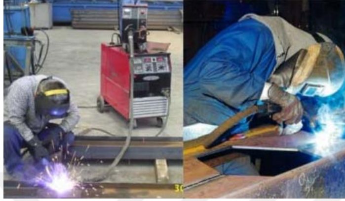
Resim 2.7 MIG kaynak uygulaması (Tama 2009).
