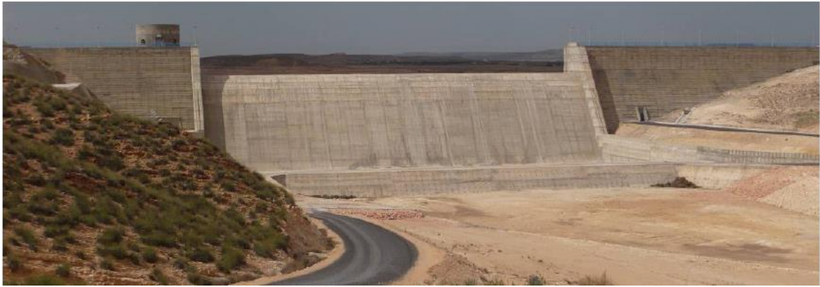
Şekil 2.3. Safsaf Barajına ait mansaptan görünüm (Guillemot ve Lino, 2012)
