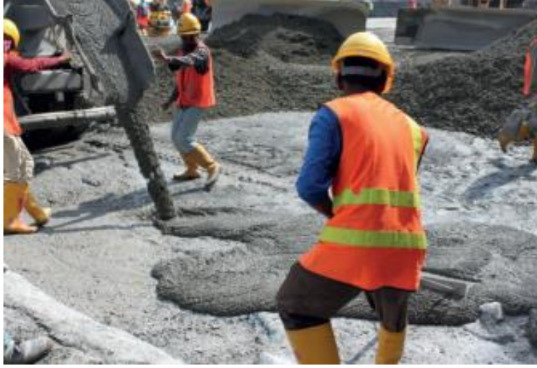
Şekil 3.9. Yatak harcının serilmesi ve yayılması (Sika, 2019)
