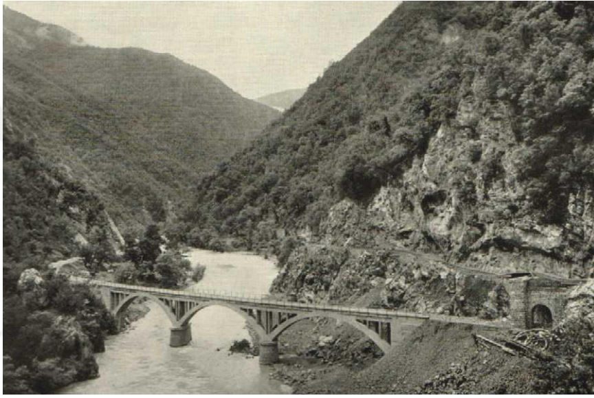
Şekil 4.1 Karabük'ün kuzeyindeki Araç çayı üzerinde 1934 yılında inşası devam eden bir köprü (URL-5 2020).
