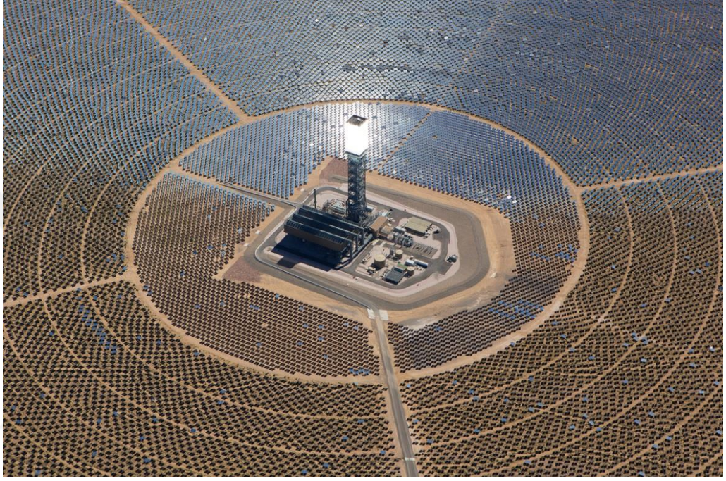
Şekil 1.7. Merkezi alıcı güneş kulesi
