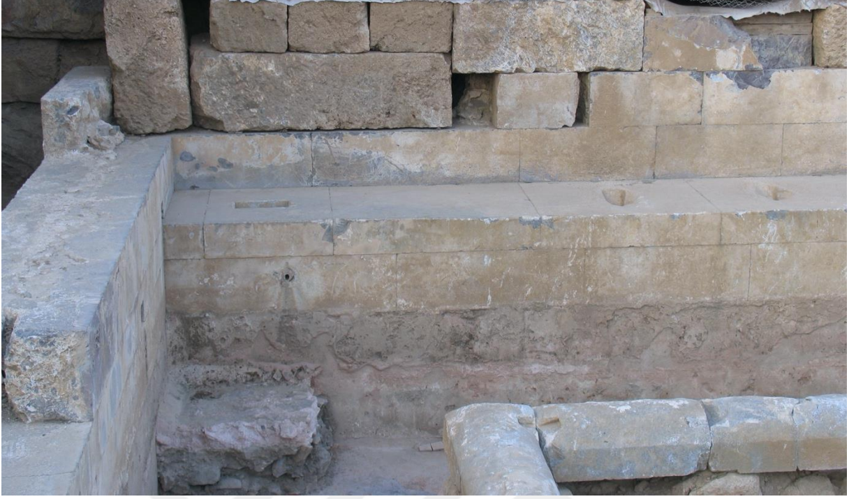
Arka duvar işçilik detayı
