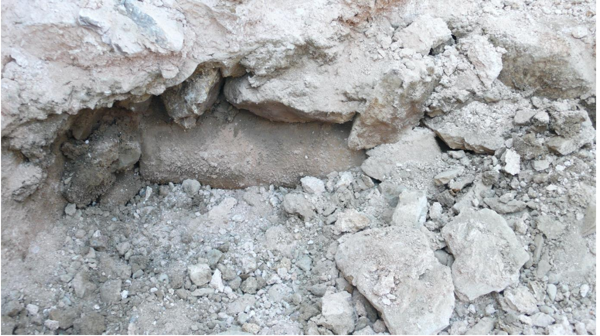
Havuz içinde kırık parapet blokları
