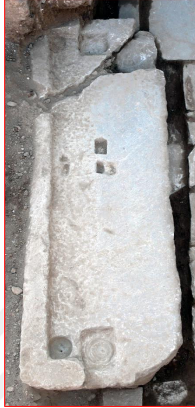
Mermer dikme, kapı dikmesi olarak kullanılmış
