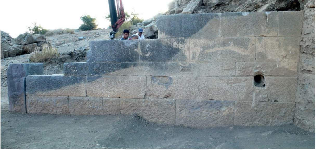
Batı duvar dış yüzü
