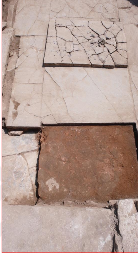
Tabana kaplanmış mermer plakanın alınması sonrasında montaj harcı durumu
