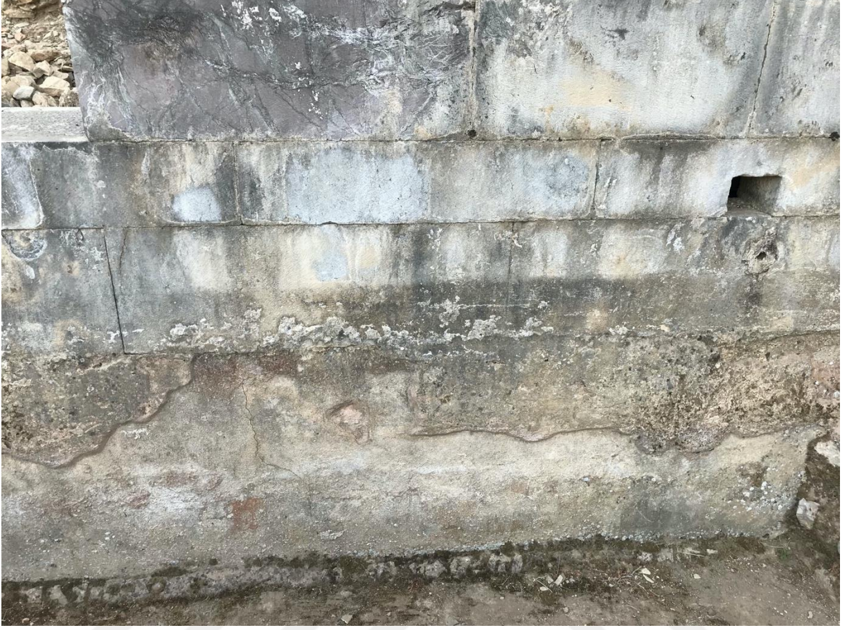
Doğu duvar iç yüzü işçiliği
