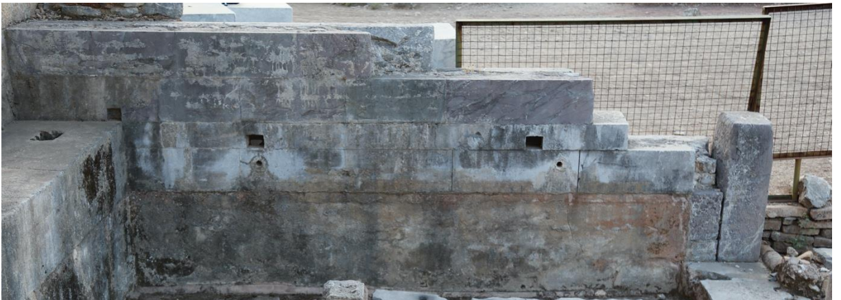
Batı duvarı iç yüzü
