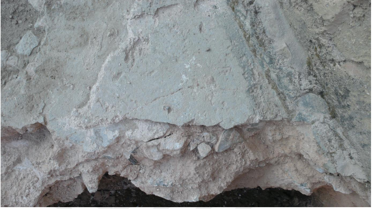
Havuz tabanında harç dolgu
