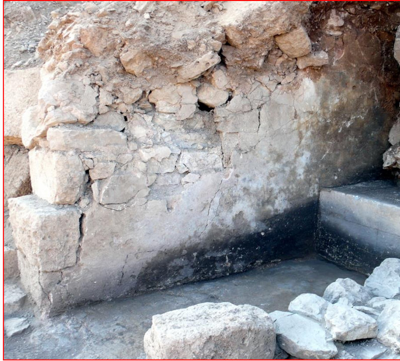
İşlik doğu duvarının içten görseli- iç yüzü
