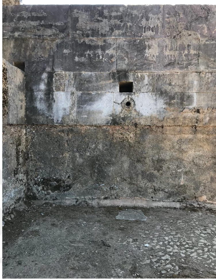
Batı duvarı iç yüzündeki sıva altı kaba yonu yüzey
