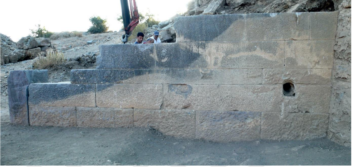
Batı duvarı örgü detayı
