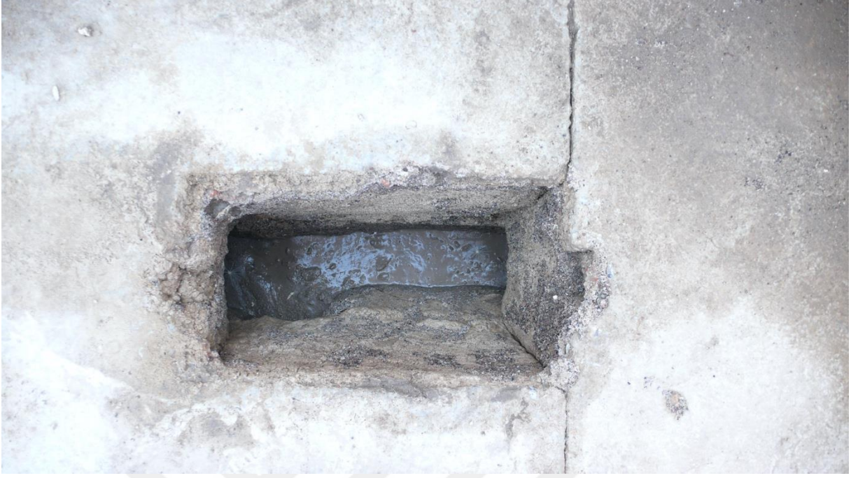
Bank bölümü altından geçen kanal
