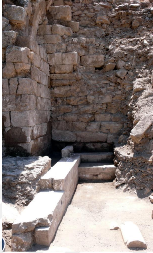
Doğu analemma duvarının ana kayadan kemer başlangıcına olan durumu
