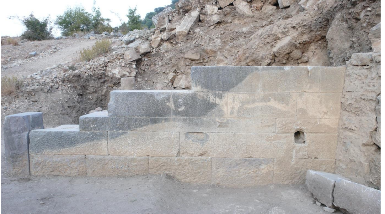
Batı duvarı bloklar üzerinde çerçeveler
