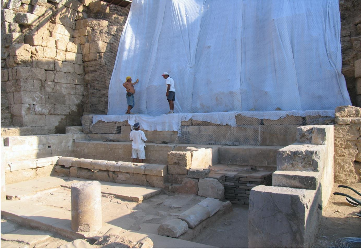
Kazı çalışması ve Teras duvarı- dolgu alan için koruma önlemleri
