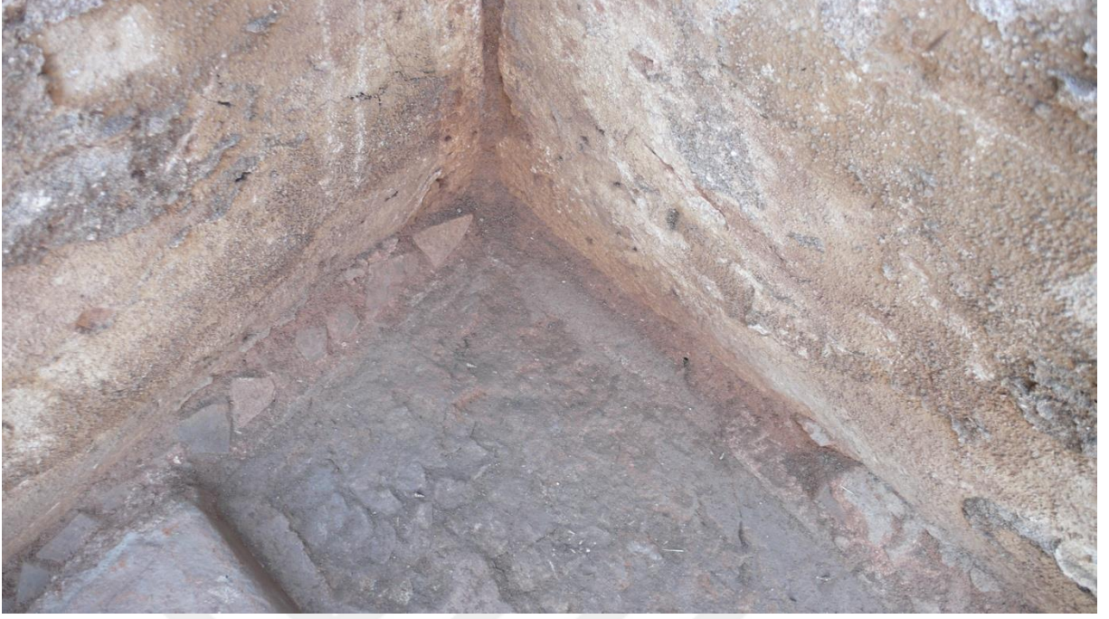
Kenar bölümlerdeki süpürgelik uygulaması
