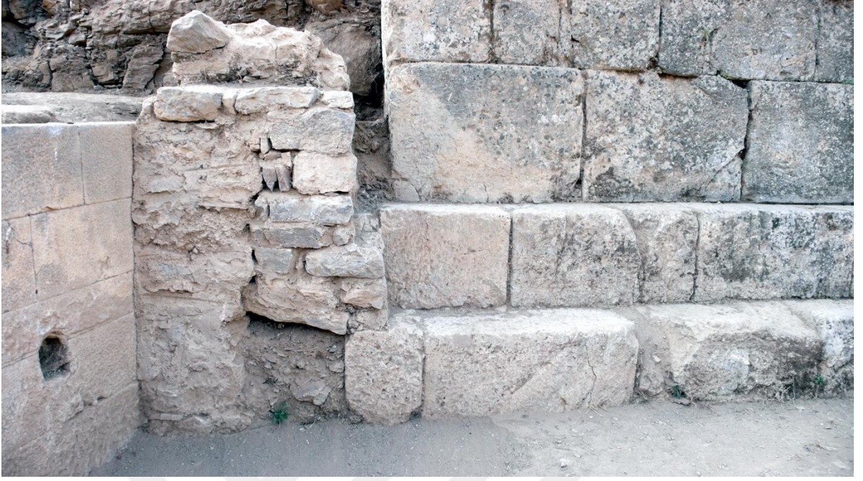
Künk kanalın tiyatro tonozlu giriş bölümü
