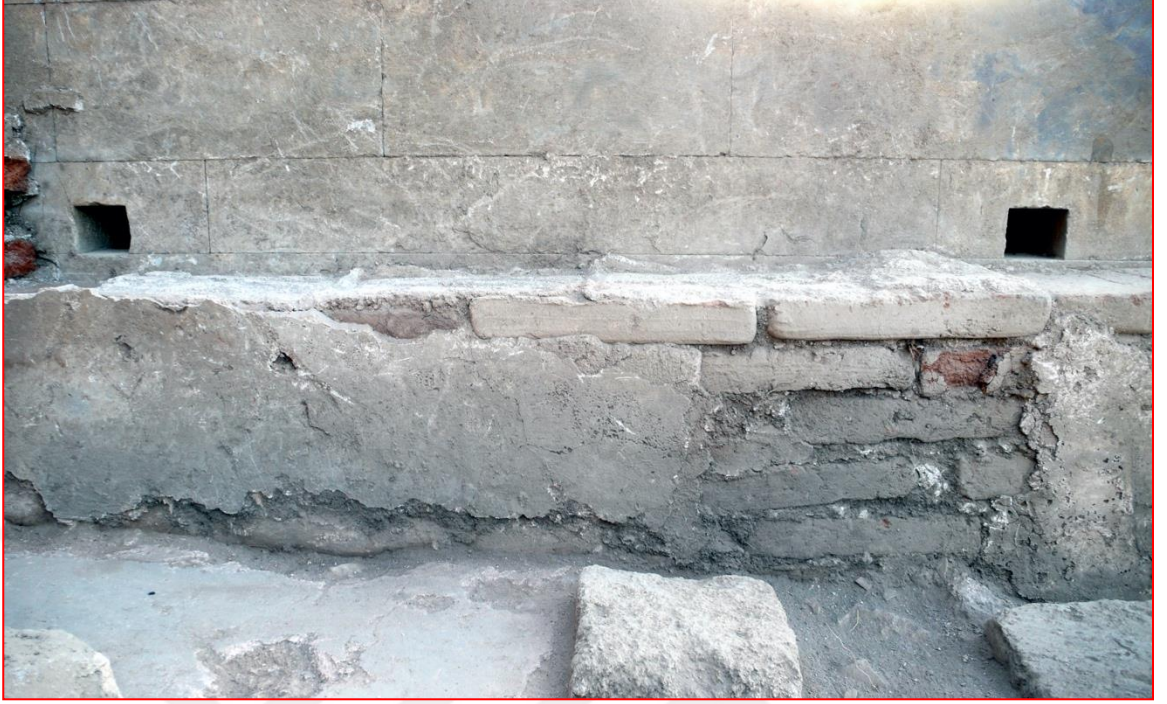
Batı duvarda tuğla uygulaması
