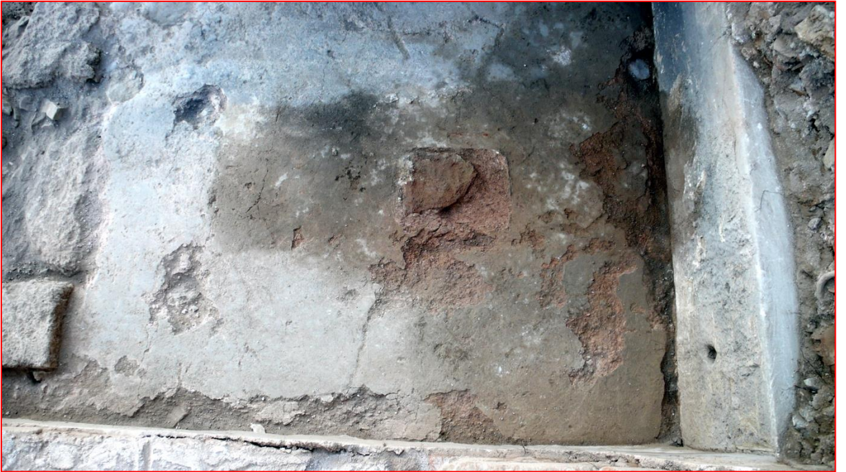
D duvarı altında çıkan tuğla dikmenin izi
