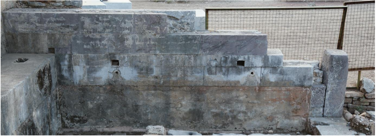
Çeşme batı duvarı iççiliği
