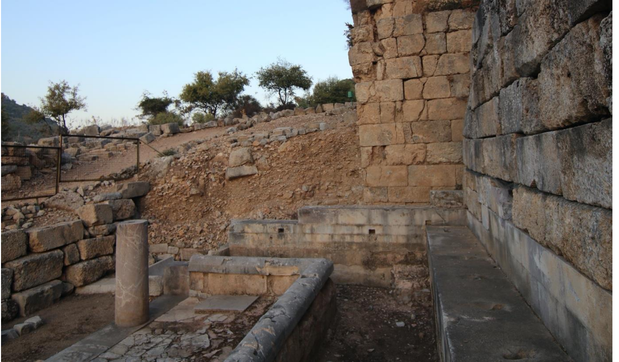
Doğu duvar iç yüzü
