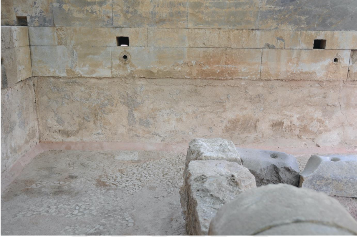
Batı duvar cephesi
