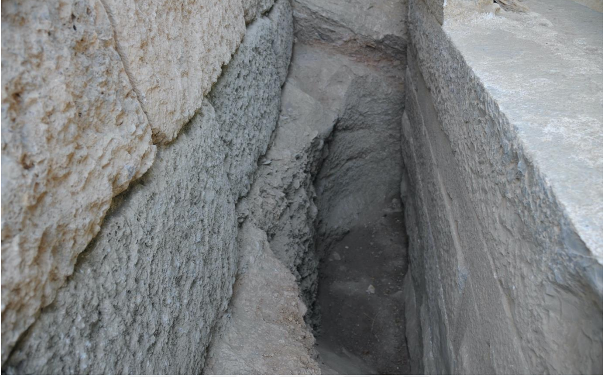
Ana kayanın tıraşlandığı ve çeşme doğu duvarının konumu, analemma duvarının ana kaya üzerinde konumlandırılması
