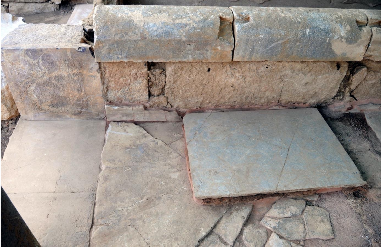
Avlu ve kenar mermer kaplamanın ilişkisi
