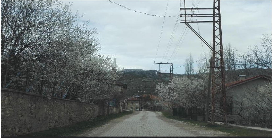
G2. Köy içi taş döşeme yol
