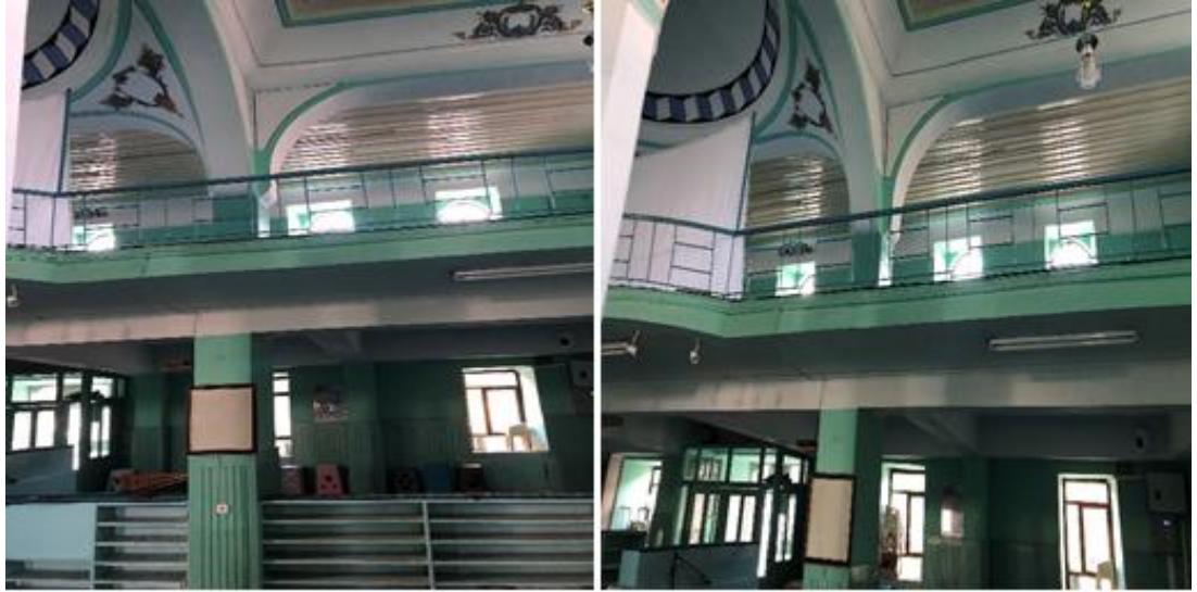
Resim 4.12 Betonarme kolon içerisinde kalan ahşap sütunlar.
