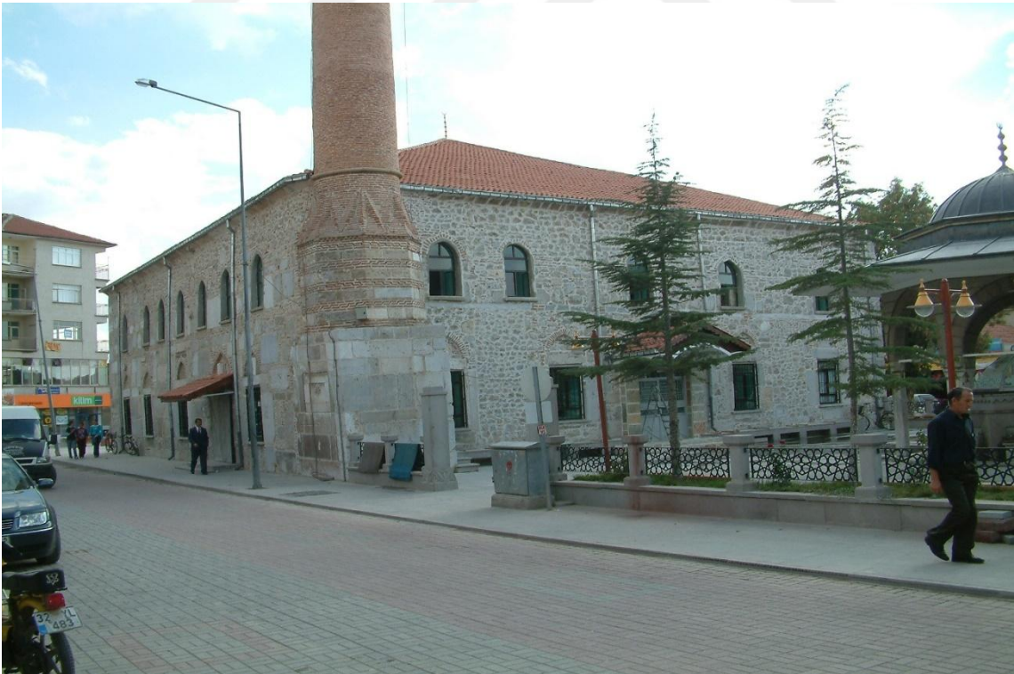
Resim 4.7 Devlethan Caminin kuzey cephesi görünüşü (Anonim (b) 2020).
