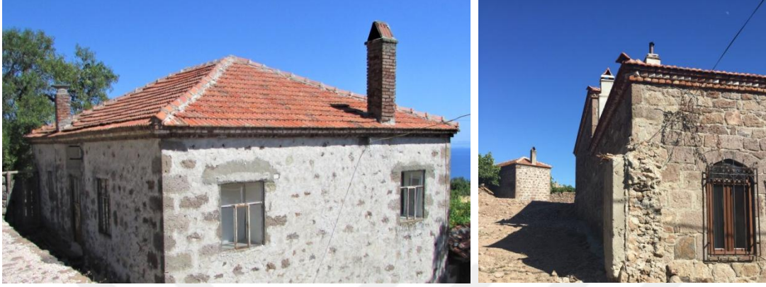
Şekil 4.80: Kıрма Çatılarda Saçak Biçimlenişleri ve Kirpi Tipi Saçaklar (Çeliker, 2019)
