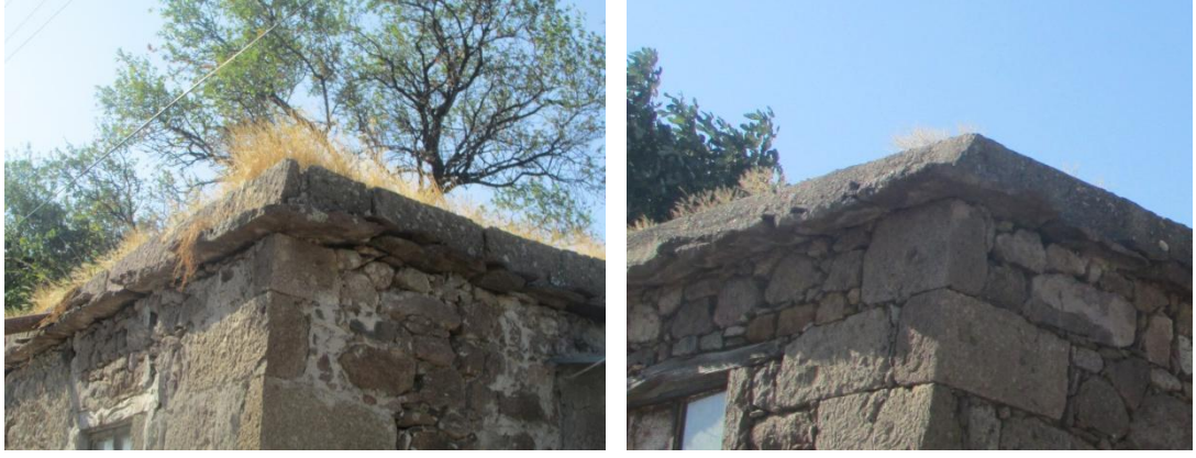
Şekil 4.78: Düz Damlı Yapılarda Saçak Biçimlenişleri (Çeliker, 2019)
