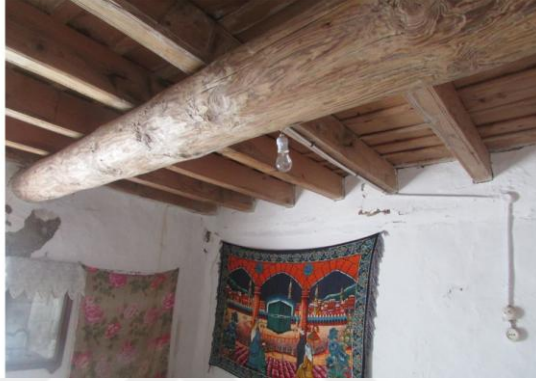
Şekil 4.77: Çatı Konstrüksiyonunu Oluşturan Döşeme Kirişleri (Çeliker, 2019)
