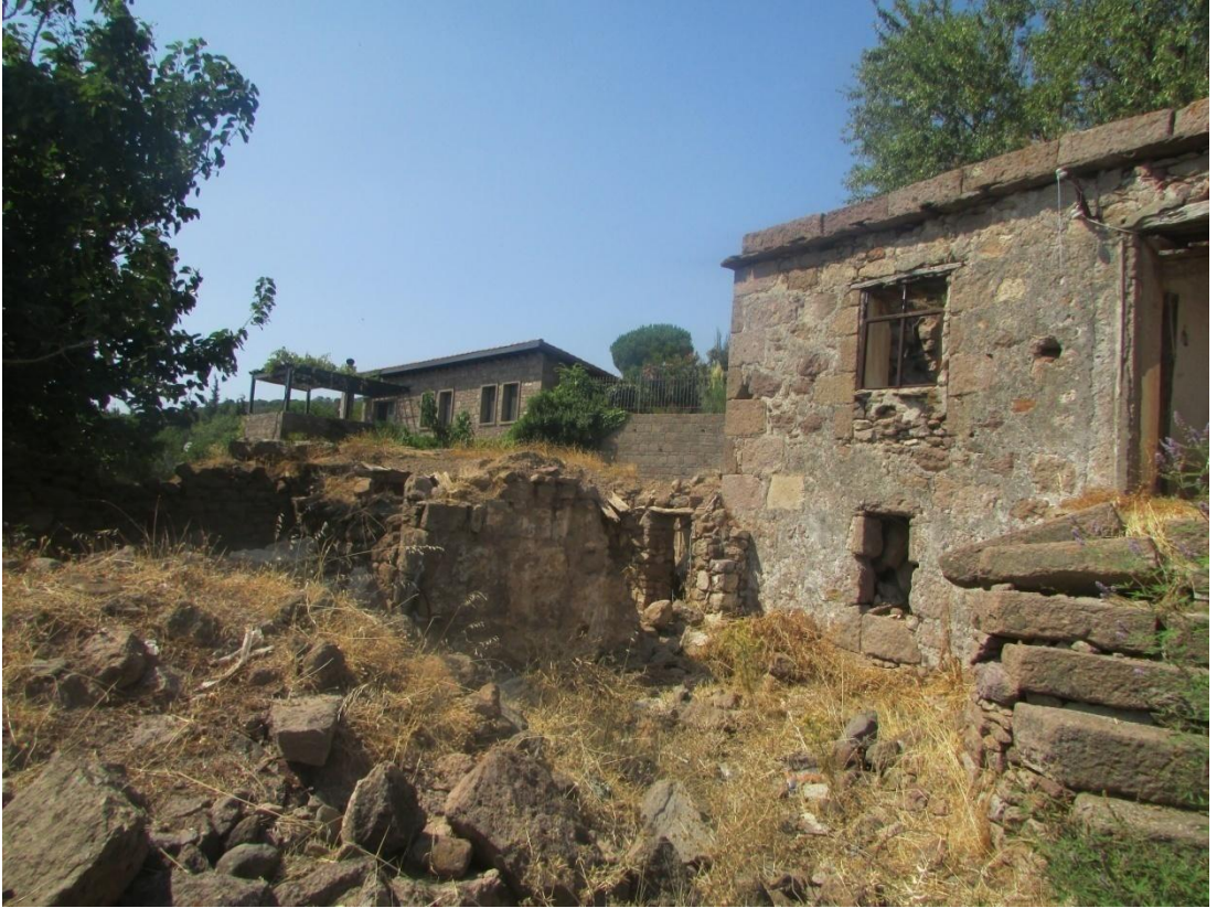
Şekil 5.13: Harap Durumdaki Geleneksel Bir Yapı ile Çağdaş Bir Yapı (Çeliker, 2019)
