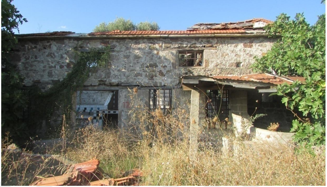
Şekil 4.23 : Tarihi Zeytinyağı Fabrikası Ön Cephe (Çeliker, 2019)
