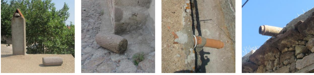
Şekil 4.67: Loğ Taşı (solda) ve Çörtenler (sağda) (Çeliker, 2019)
