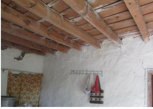
Şekil 4.76: İki Kat Arasında Bulunan Döşeme Kirişleri (Madel) (Çeliker, 2019)
