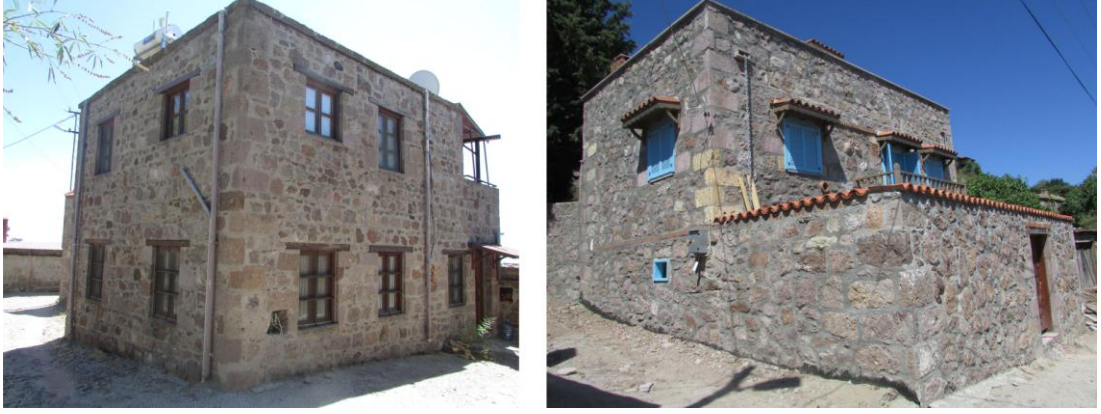
Şekil 4.16 : Onarım Gören Konut Yapıları (Çeliker, 2019)
