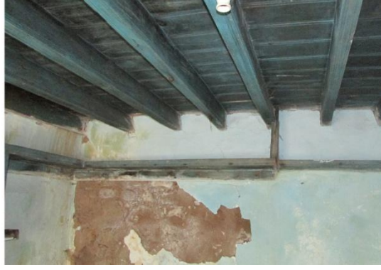
Şekil 4.76: İki Kat Arasında Bulunan Döşeme Kirişleri (Madel) (Çeliker, 2019)
