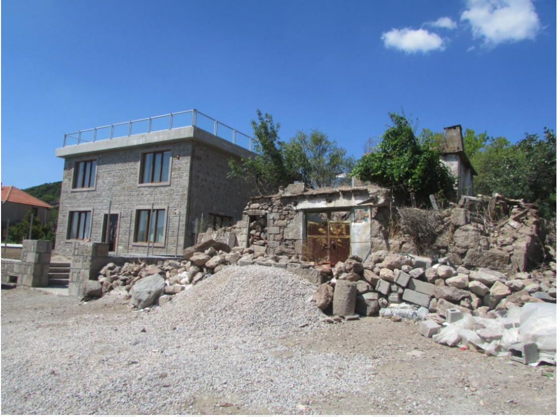
Şekil 5.11: Harap Durumdaki Geleneksel Bir Yapı ile Yanındaki Çağdaş Yapı (Çeliker, 2019)
