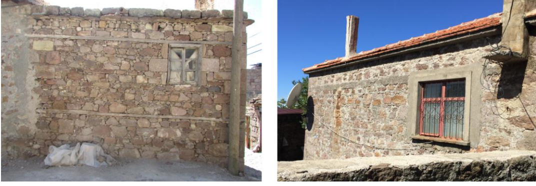
Şekil 4.71: Ahşap ve Beton Hatıllı Yapılardan Örnekler (Çeliker, 2019)
