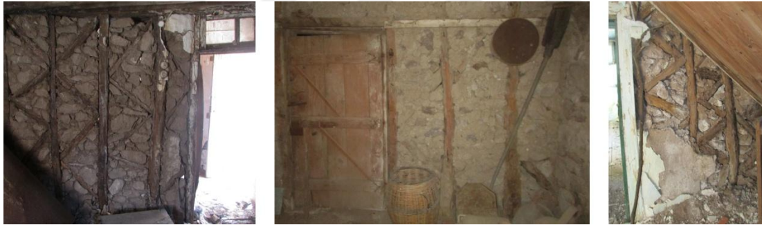
Şekil 4.72: Bölücü İç Duvarların Yapım Tekniği (Çeliker, 2019)
