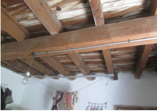
Şekil 4.77: Çatı Konstrüksiyonunu Oluşturan Döşeme Kirişleri (Çeliker, 2019)
