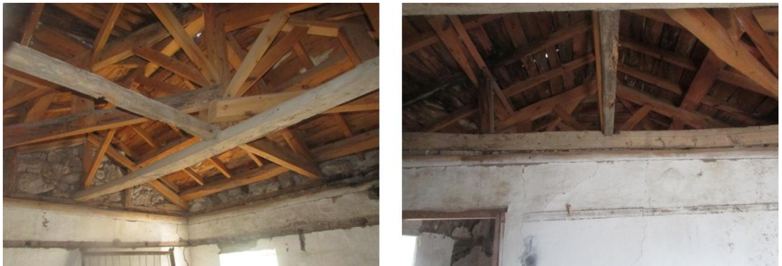
Şekil 4.79: Ahşap Kırma Çatı Konstrüksiyonu (Çeliker, 2019)
