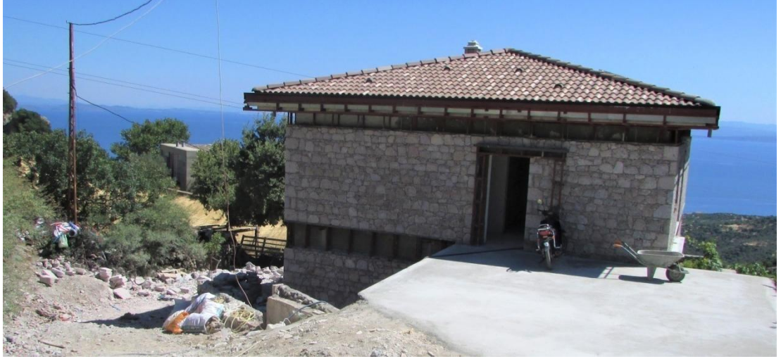
Şekil 4.89: Taş Kaplama Yapılan İnşa Halindeki Bir Çağdaş Yapı (Çeliker, 2019)
