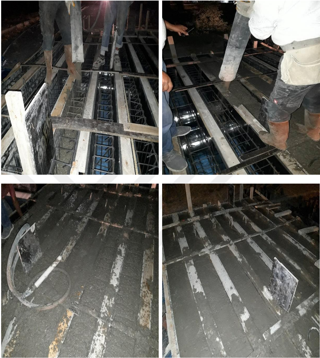
Şekil 2.16. Kiriş numunelerine beton dökümü
