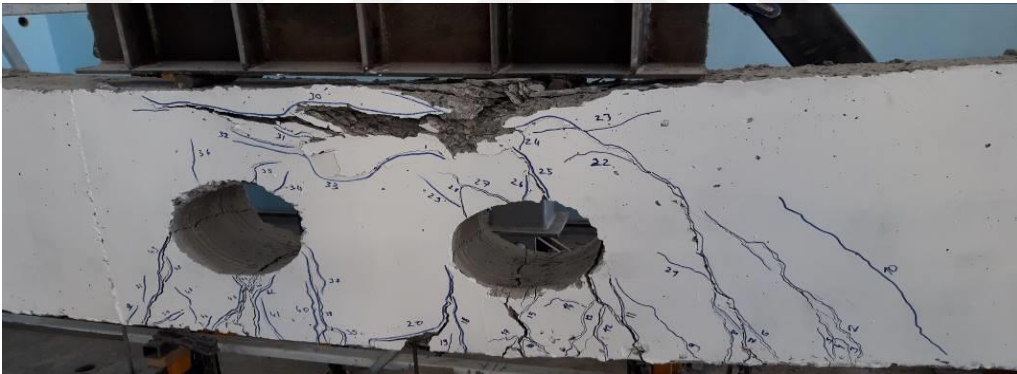
Şekil 3.61. K-4 numunesinin deney sonrası eğilme çatlak detayları
