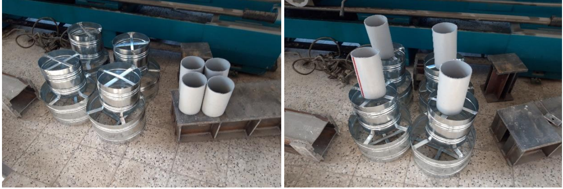
Şekil 2.12. Boşluklar için kullanılan sac ve boru malzemeler
