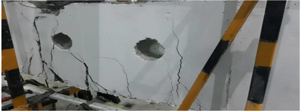
Şekil 3.30. K-1 numunesinin arka yüzeyinde oluşan çatlakların görünümü
