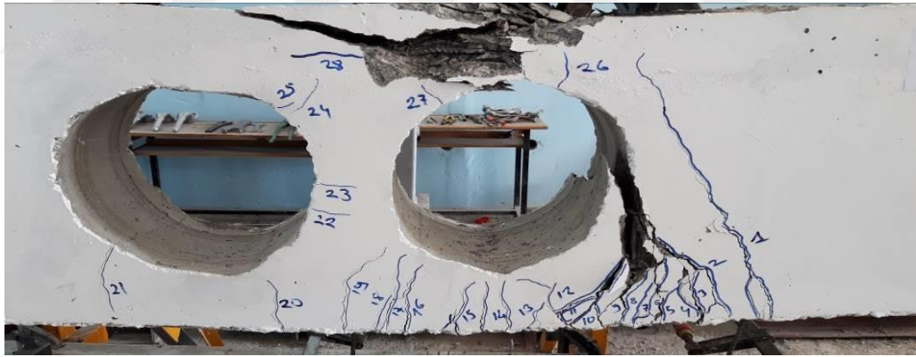
Şekil 3.72. K-5 numunesinin deney sonrası eğilme çatlak detayları
