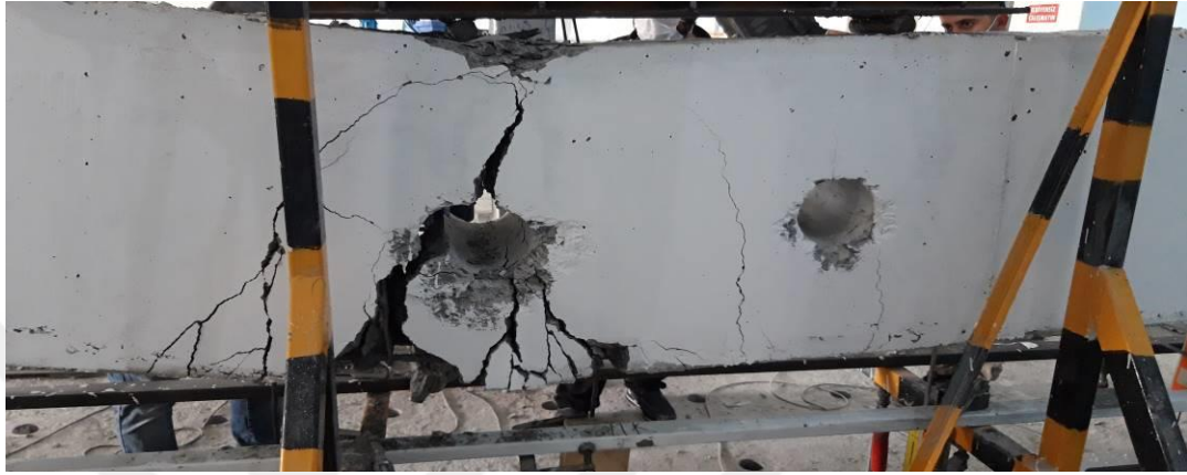
Şekil 3.41. K-2 numunesinin arka yüzeyinde oluşan çatlakların görünümü
