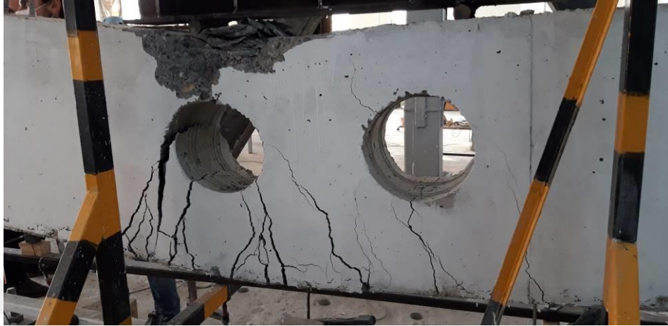
Şekil 3.52. K-3 numunesinin arka yüzeyinde oluşan çatlakların görünümü
