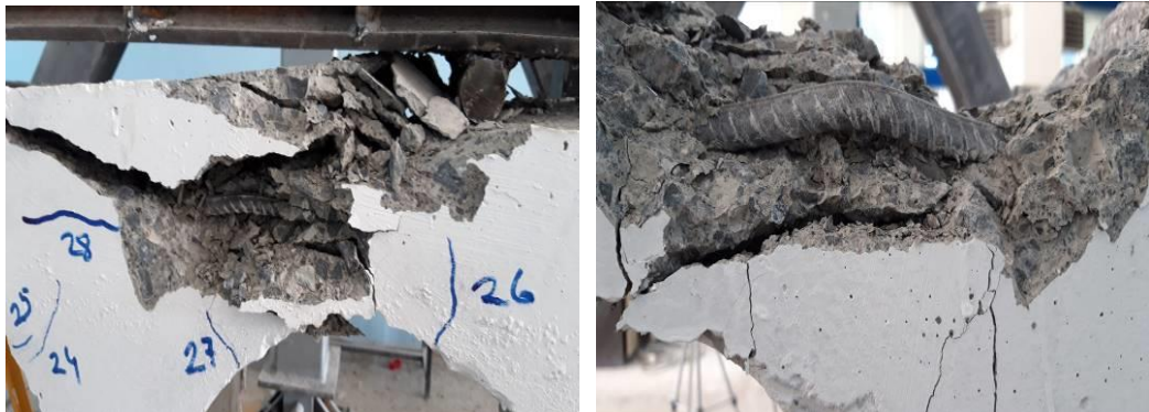
Şekil 3.73. K-5 numunesinin hasar dağılımı, donatı burkulması
