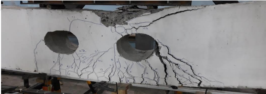
Şekil 3.50. K-3 Numunesinin deney sonrası eğilme çatlak detayları
