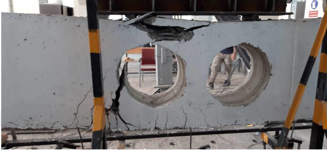
Şekil 3.74. K-5 numunesinin arka yüzeyinde oluşan çatlakların görünümü
