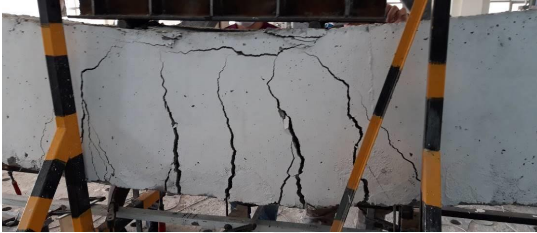
Şekil 3.19. R-2 numunesinin arka yüzeyinde oluşan çatlakların görünümü
