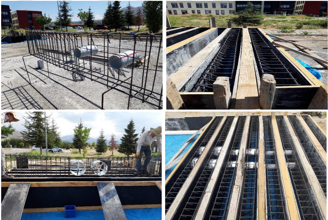
Şekil 2.13. Donatıların ve boşlukların hazırlanması ve yerleşimi
