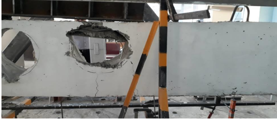
Şekil 3.85. K-6 numunesinin arka yüzeyinde oluşan çatlakların görünümü
