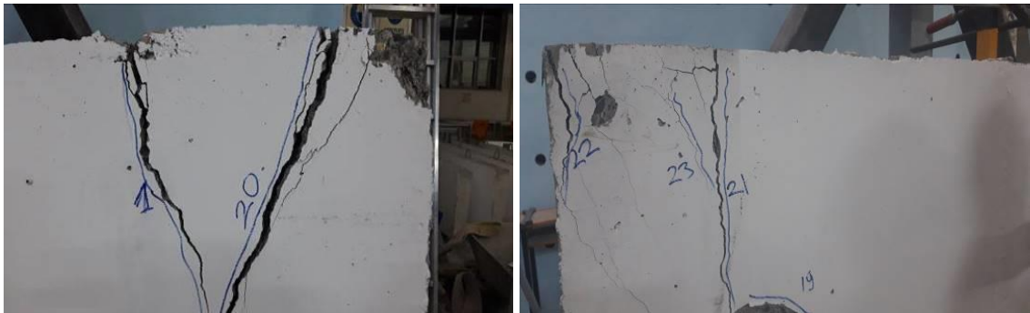
Şekil 3.31. Mesnet bölgesi kesme çatlakları
