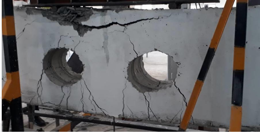
Şekil 3.63. K-4 numunesinin arka yüzeyinde oluşan çatlakların görünümü
