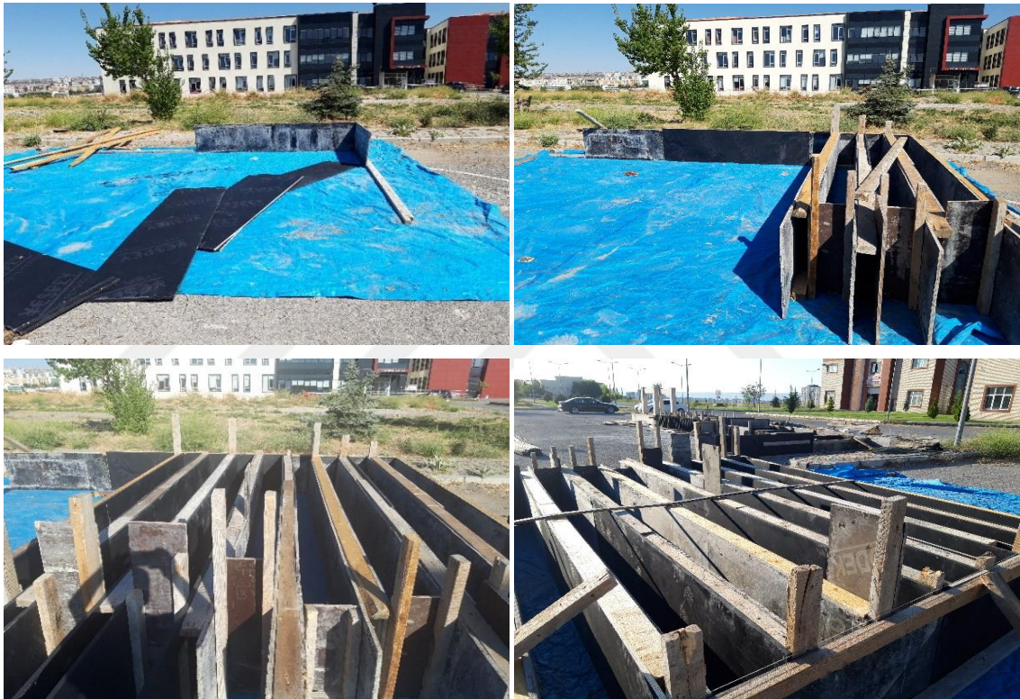
Şekil 2.11. Deney numunelerinin kalıp imalatı
