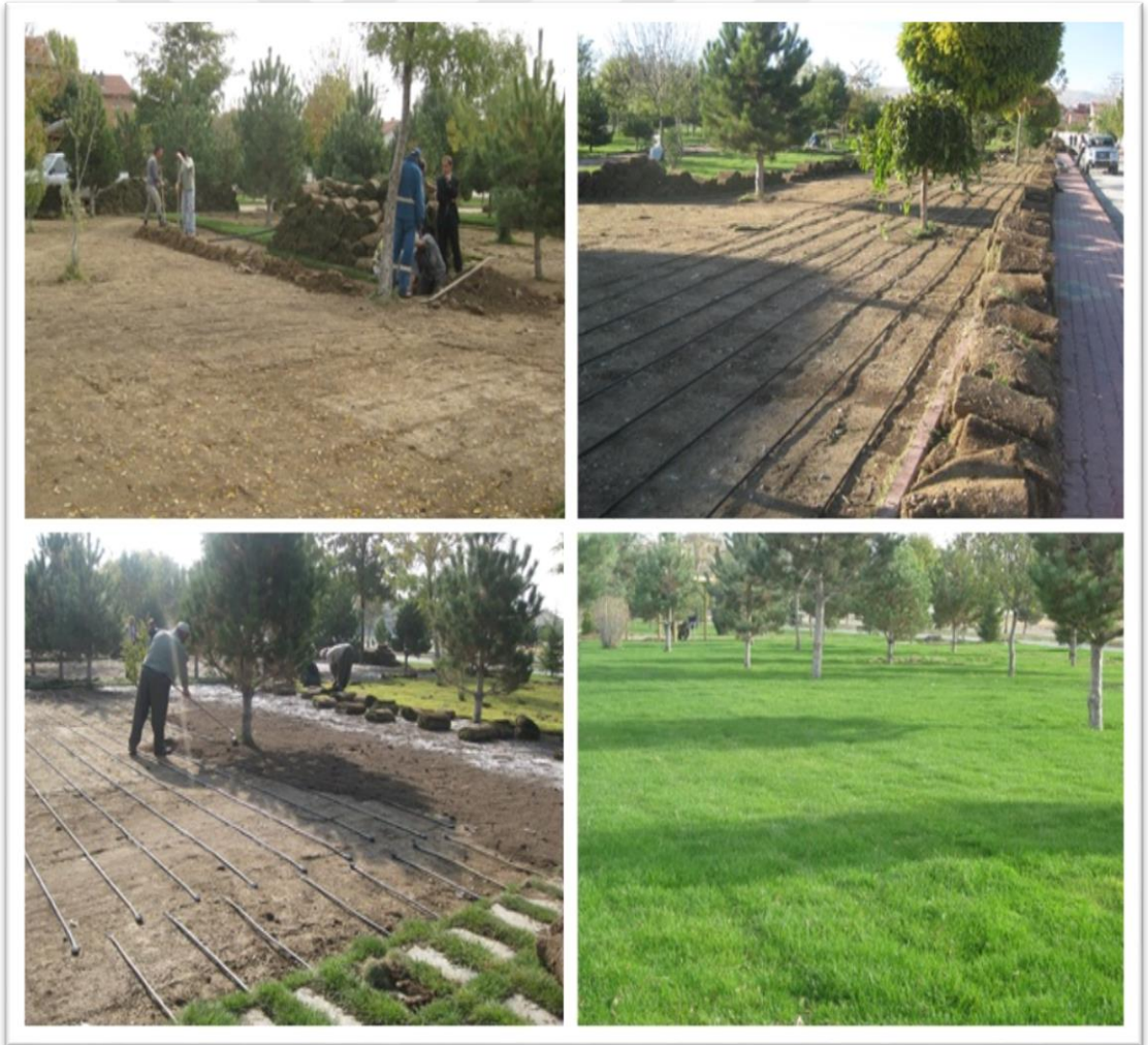
Şekil 4.50. Parktaki mevcut çim kaldırılıp toprak altı damla sulama sistemi uygulaması
