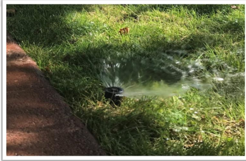
Şekil 4.41. Sprey tip (sabit atış yapan) yağmurlama başlığı
