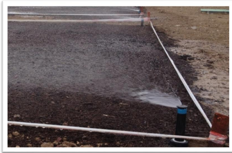
Şekil 3.4. Sabit (sprej tip) yağmurlama başlığı
