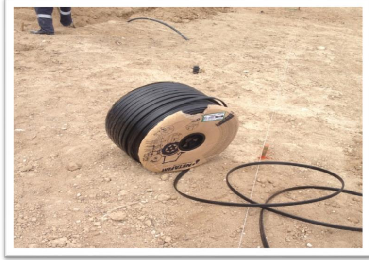
Şekil 3.3. Toprak altı damla sulama borusu
