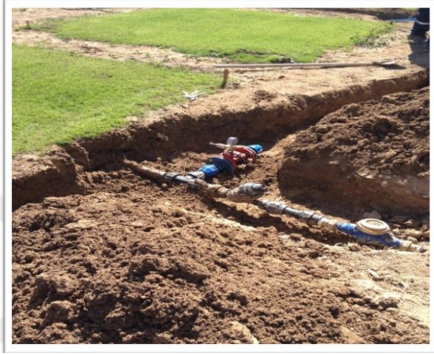
Şekil 3.7. Sulama sistemi girişinde kullanılan su sayacı, filtre ve basınç düzenleyici vana
