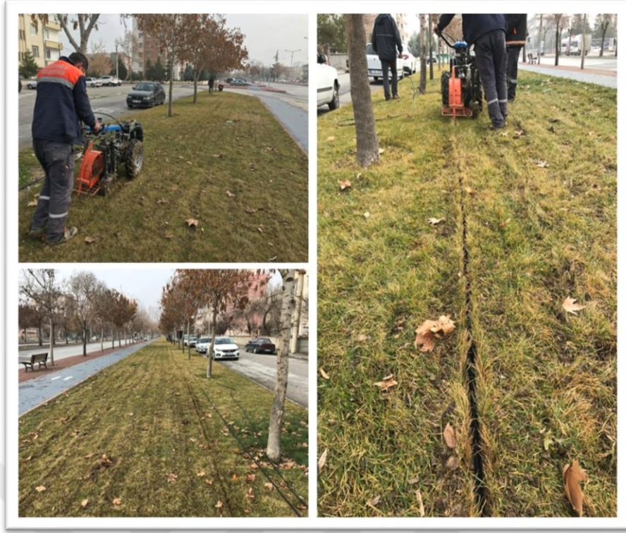
Şekil 4.52. Mevcut çim alana makine yardımıyla toprak altı damla sulama sistemi uygulaması
