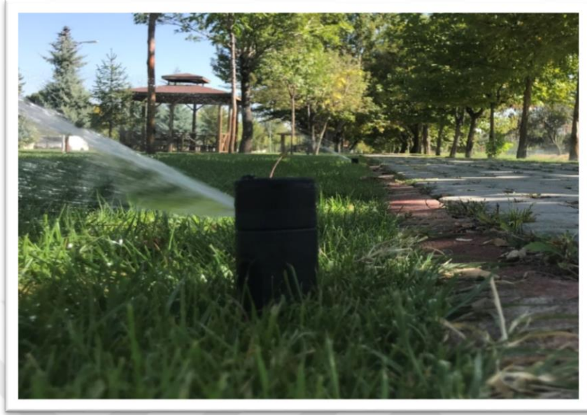
Şekil 4.40. Rotor tip (dönerek atış yapan) yağmurlama başlığı
