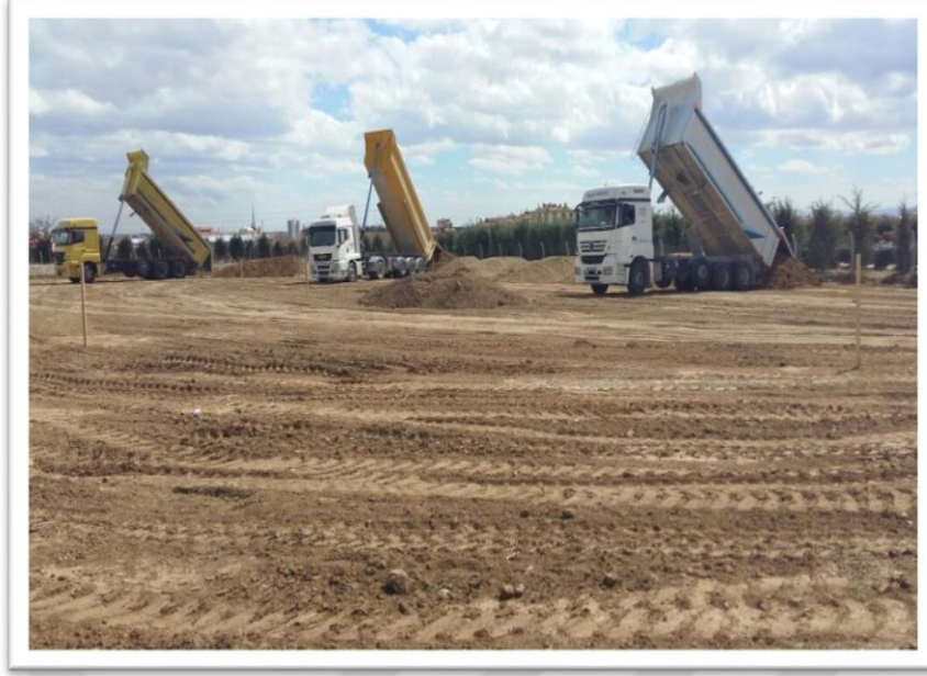
Şekil 3.10. Hafriyat toprağının deneme alanına dökülmesi
