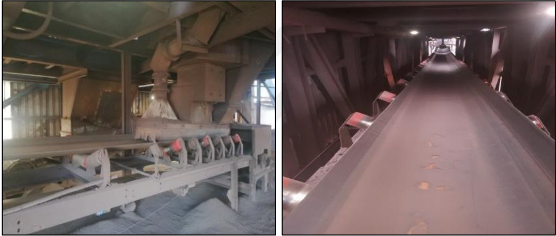
Şekil 2.20. Tesiste kullanılan A tipi aşınmaya dayanıklı bant.
