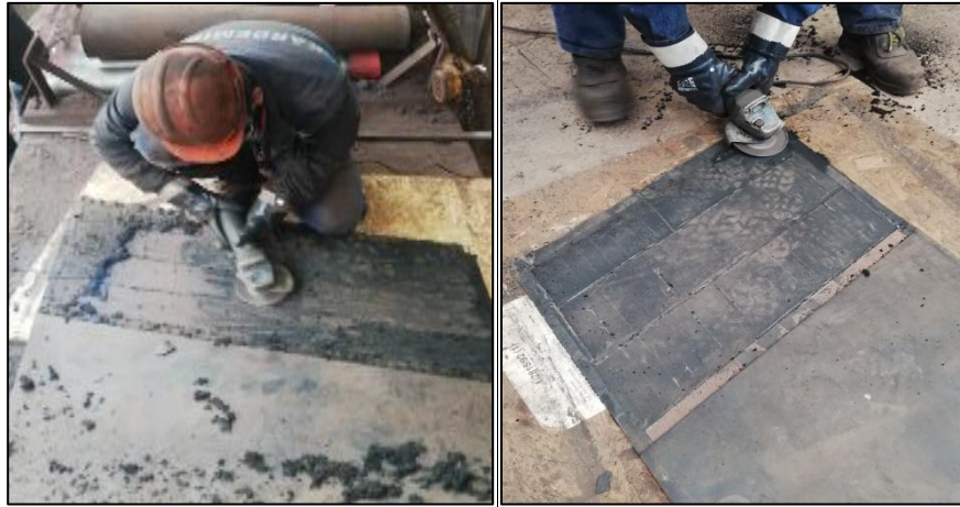
Şekil 3.21. Tekstil özlü bandın raspanması.
