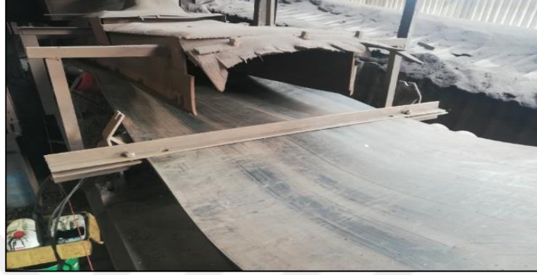
Şekil 3.10. Bantların köşebentlerle sabitlenmesi.
