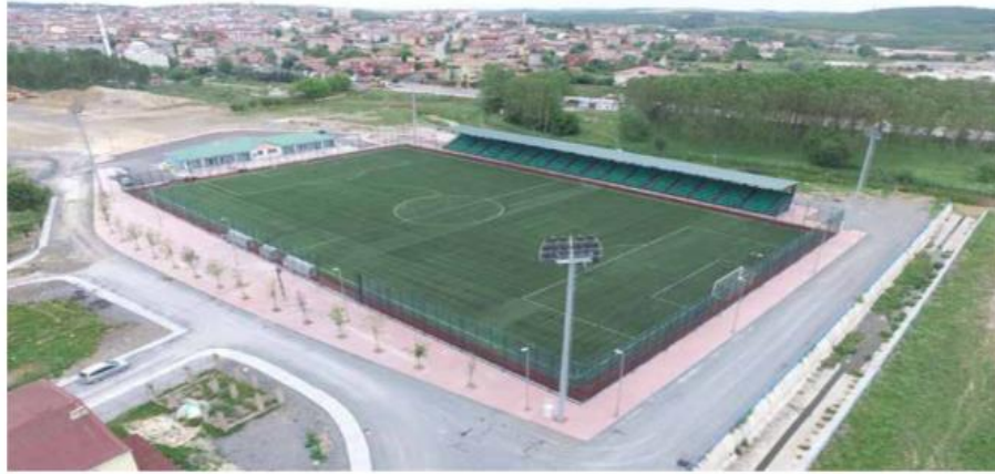
Bolluca Spor Tesisi
