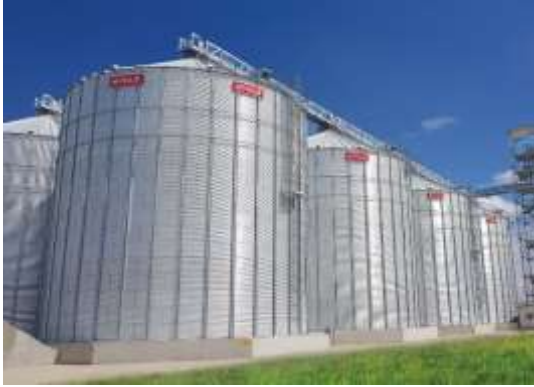
Şekil 1. Kabuk elemanlardan oluşan silolar (Anonymous a)
