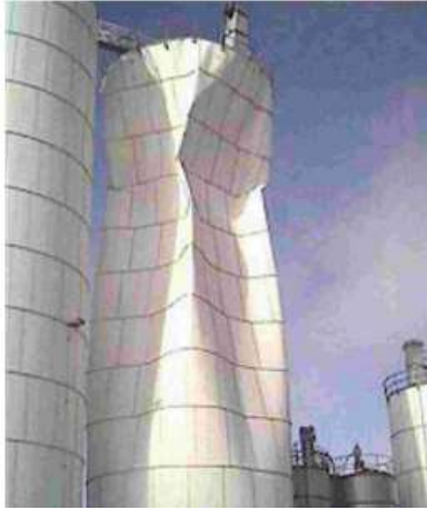
Şekil 7. Burkulmuş silo (Dogangun, Karaca et al. 2009)
