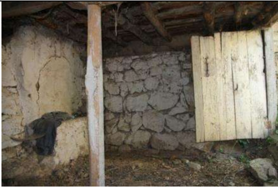
Resim 4.68. Z1 iş evi yığma duvarları
