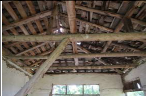
Resim 4.75. Ahşap çatı konstrüksiyonu
