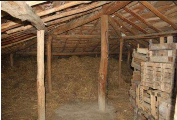
Resim 4.230. Ahırın çatı arası
