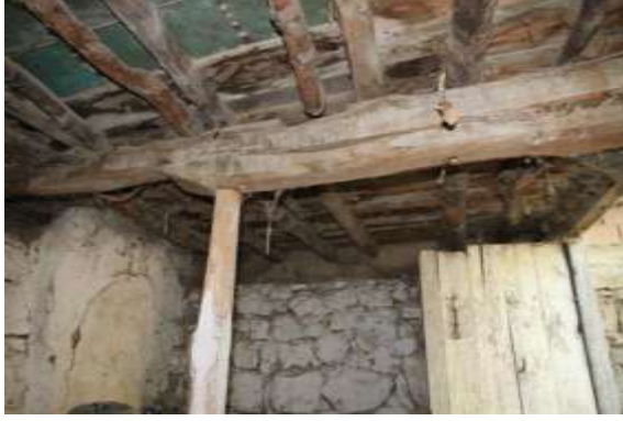
Resim 4.70. Z1 iş evi ahşap kirişleme
