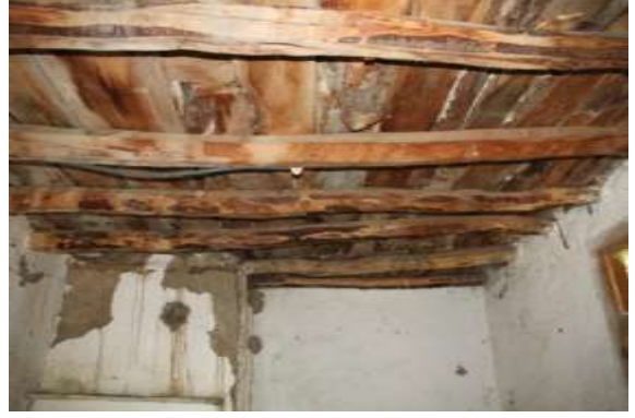
Resim 4.214. B1 oda tavan kirişlemesi
