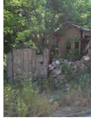
Resim 4.120. Bağın ahşap bahçe kapısı
