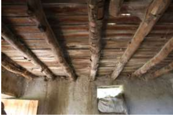
Resim 5.17. Zemin kat döşeme kirişleri
