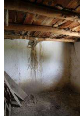
Resim 4.193. B1 odanın tavan kirişlemesi
