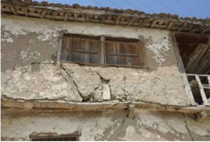
Resim 5.21. Akçimen Gümelesi; döşeme kirişleri dışarı çıkan bir konsol (Bkz. Katalog 2)
