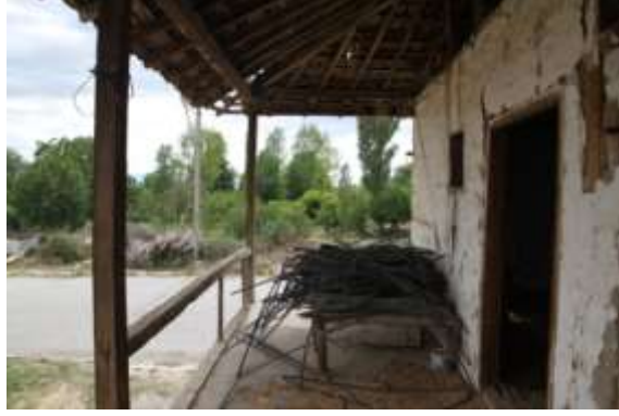
Resim 4.134. B2 balkon ve ahşap dikmeler
