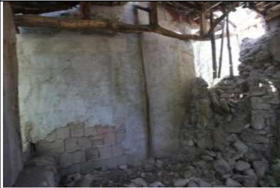
Resim 4.123. Yan parseldeki yapının tuğla duvarı
