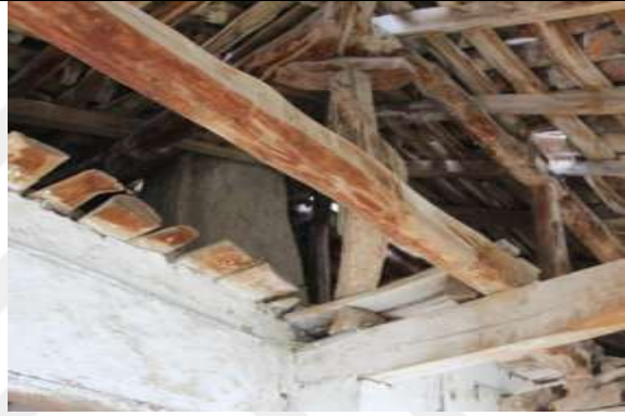
Resim 4.162. Ahşap çatı konstrüksiyonu
