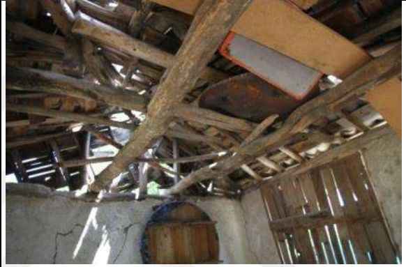
Resim 4.115. Ahşap çatı konstrüksiyonu
