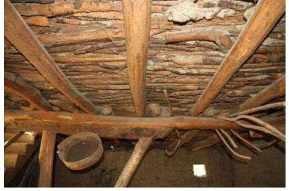
Resim 4.187. Z1 tavandaki ahşap kirişleme
