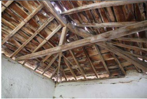
Resim 4.105. Ahşap çatı konstrüksiyonu
