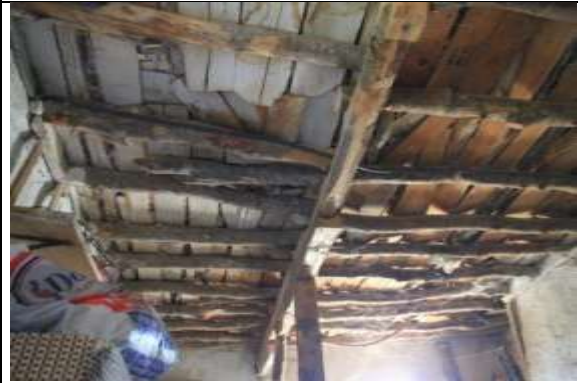
Resim 4.40. Z1 iş evi tavanı ahşap kirişleme
