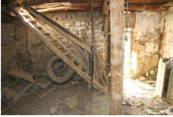
Resim 4.168. Ahşap merdiven ve dikmeler
