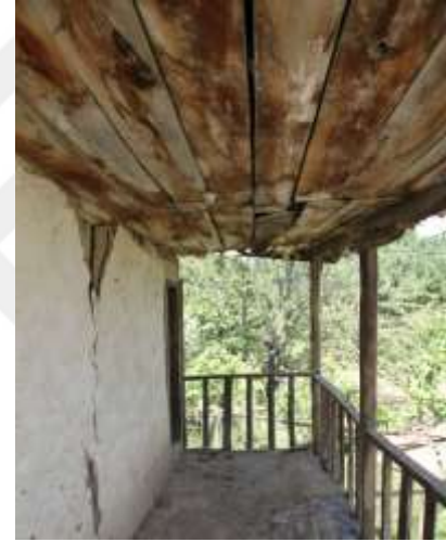
Resim 5.20. Kaplama tahtası ile kapatılan tavan
