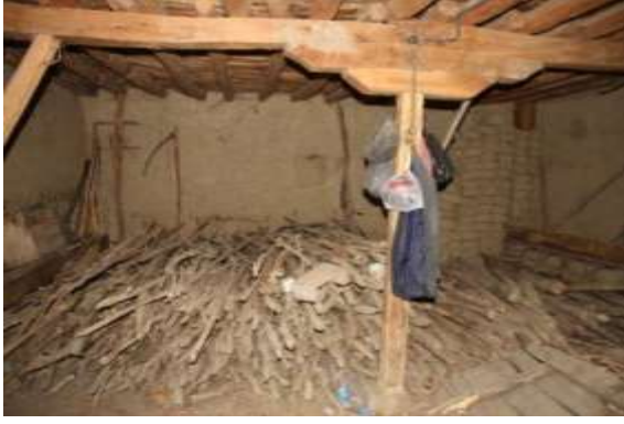
Resim 4.226. Z1 iş evi tavan kirişlemesi
