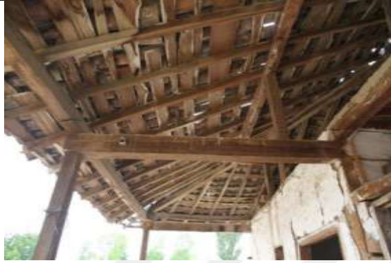
Resim 4.136. Ahşap çatı konstrüksiyonu
