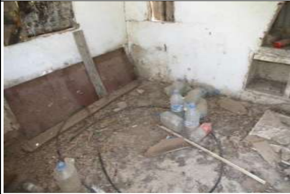
Resim 4.106. Z1 iş evi beton zemini
