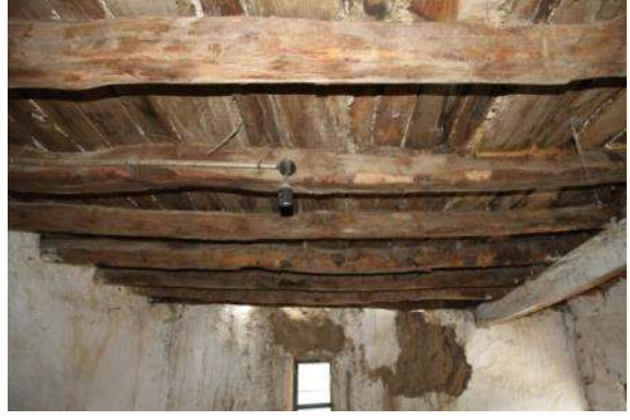
Resim 4.175. B1 odanın tavan kirişlemesi
