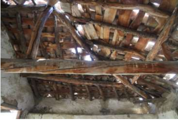
Resim 5.19. Üst kattaki odanın çatı konstrüksiyonu ile kapatıldığı Gümele örneği
