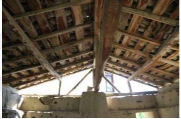
Resim 4.96. Ahşap çatı konstrüksiyonu
