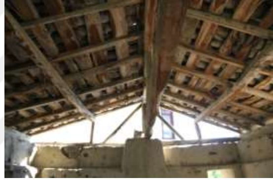
Resim 5.24. Ahşap çatı elemanları
