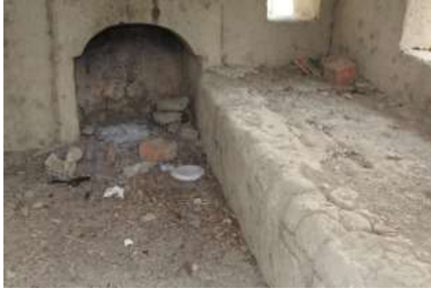
Resim 5.9. Kerpiçten yapılmış sedir (Bkz. Katalog 6)
