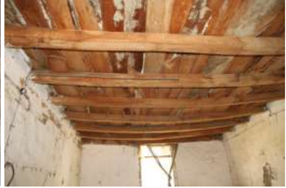
Resim 5.18. Üst kat oda ile çatı arasındaki döşeme kirişleri
