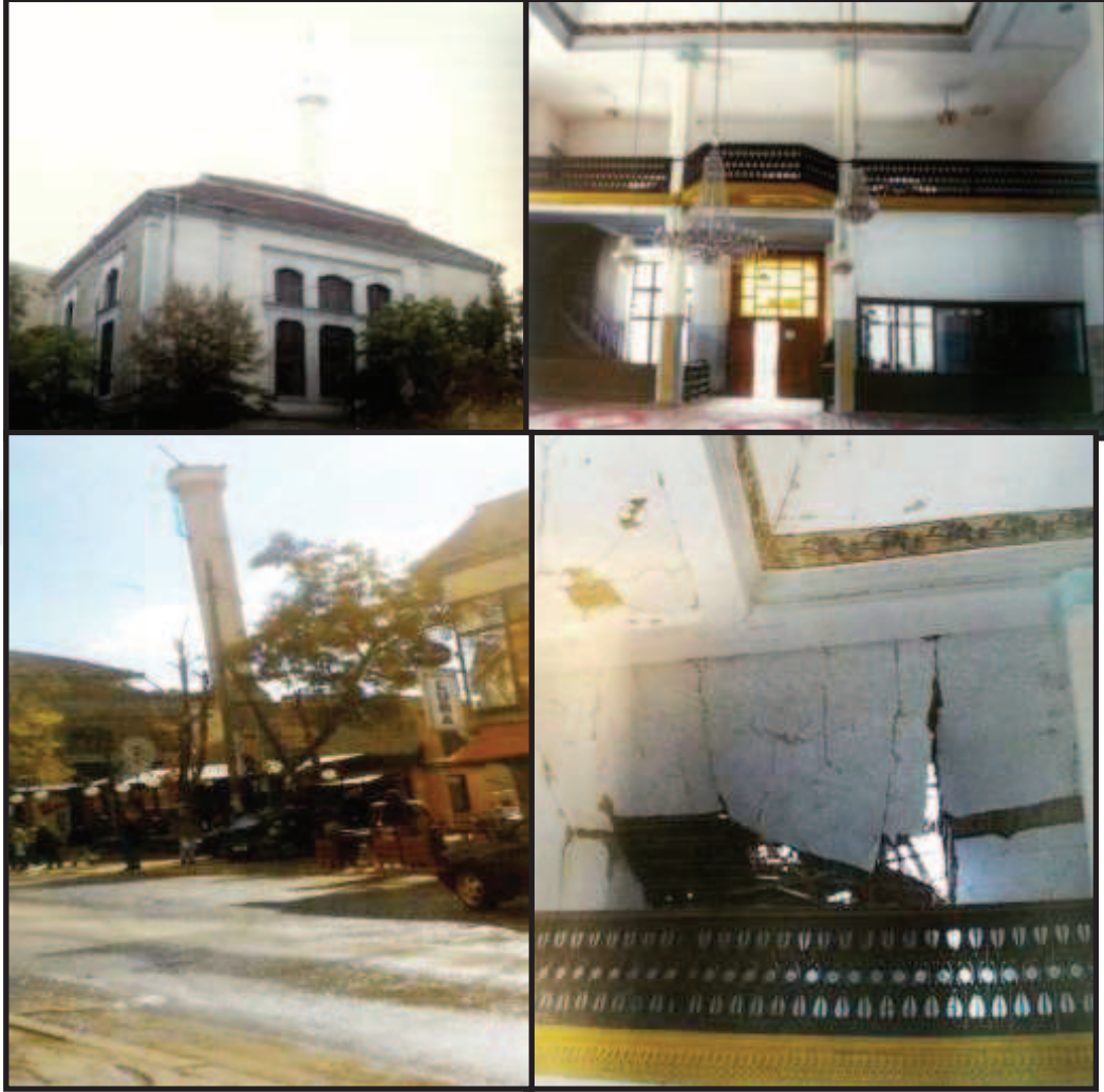
Resim 3.13: Şehzade Hanım ( Çarşı ) Cami, 2002 Depremi Öncesi ve Sonrası Hali 182
