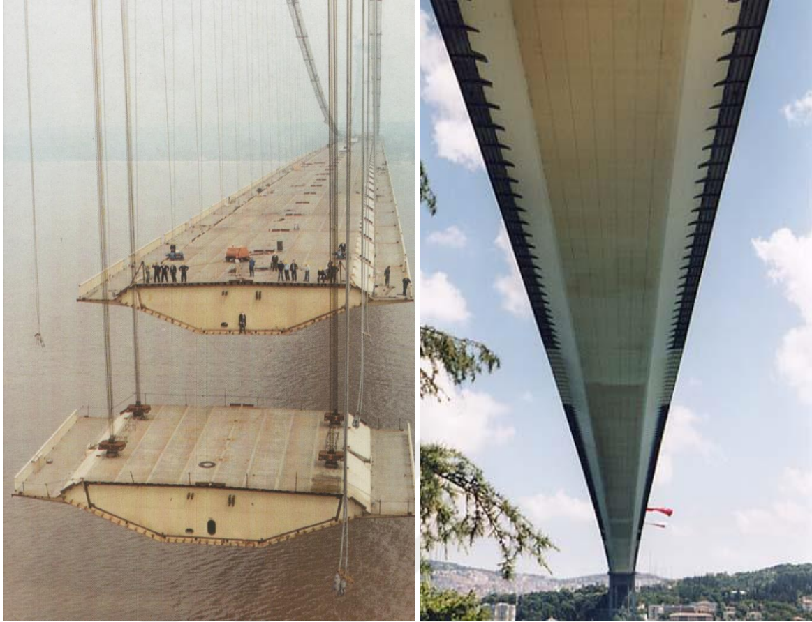
Resim 5.3. Tabliyenin oluşturulması
