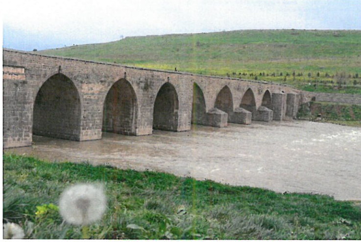
Şekil 3.31. On Gözlü Köprü
