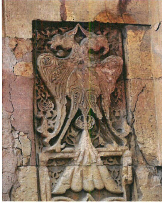
Şekil 3.17. Divriği Ulu Camii Gölge Kapı
