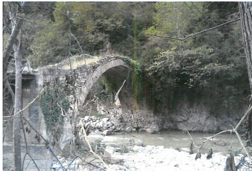
Şekil 3.29. Bir taş köprü örneği
