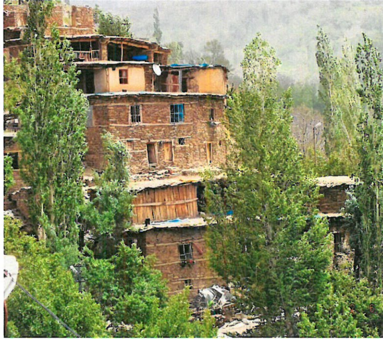
Şekil 3.33. Taştan yapılmış üst üste bindirme ev örneği
