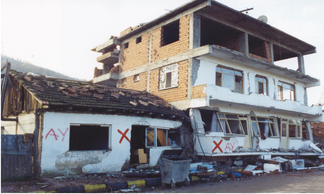
Resim 3.17. Giriş katında bant pencere sonucu kısa kolon oluşumu ve meydana gelen hasar (1999), (Kaynaşlı Kriz Yönetim Merkezi Arşivi).
