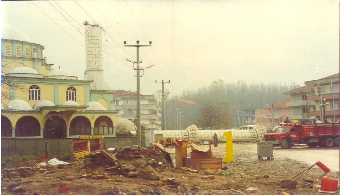
Resim 3.41. 12 Kasım 1999 Depremi. Camide meydana gelen hasar (1999), (Kaynaşlı Kriz Yönetim Merkezi Arşivi).
