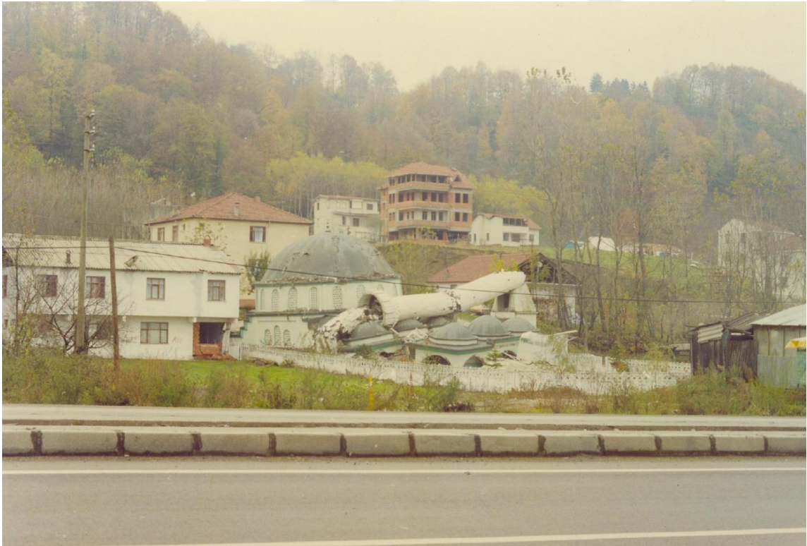
Resim 3.42. 12 Kasım 1999 Depremi. Camide meydana gelen hasar (1999), (Kaynaşlı Kriz Yönetim Merkezi Arşivi).
