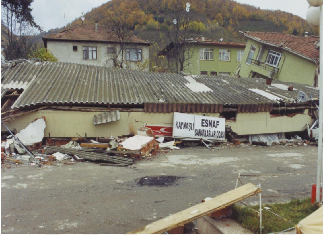
Resim 3.37. 12 Kasım 1999 Depremi. Yıkılan Kaynaşlı Esnaf Sanatkarlar Odası binası (1999), (Kaynaşlı Kriz Yönetim Merkezi Arşivi).
