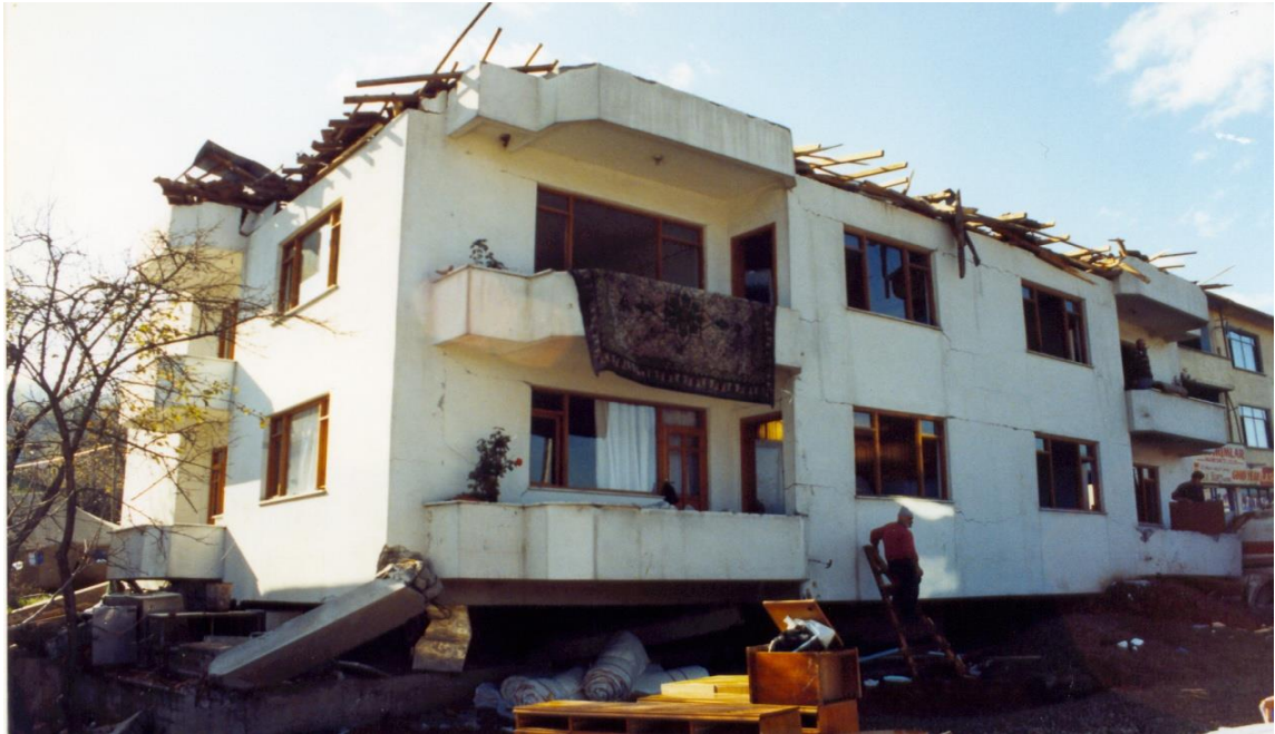
Resim 3.16. Giriş katında birleşim yerinden kırılan kolonlar ve 3 kattan 2 kata inen bina (1999), (Kaynaşlı Kriz Yönetim Merkezi Arşivi).
