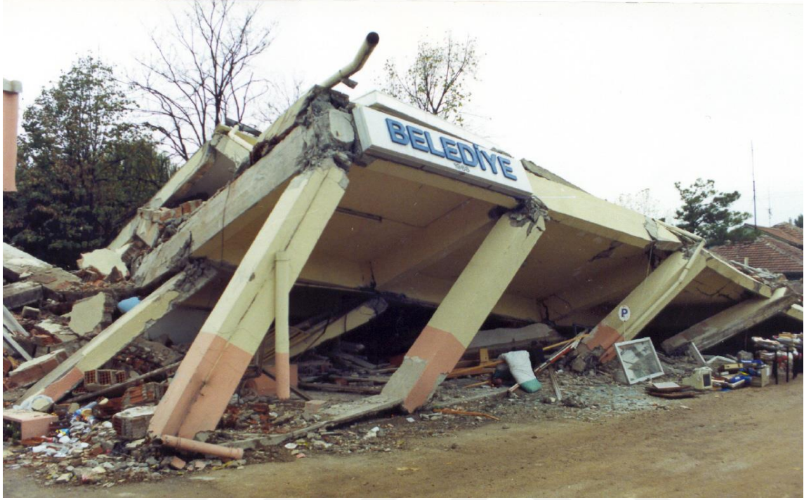
Resim 3.35. 12 Kasım 1999 Depremi. Yıkılan Kaynaşlı Belediye binası (1999), (Kaynaşlı Kriz Yönetim Merkezi Arşivi).
