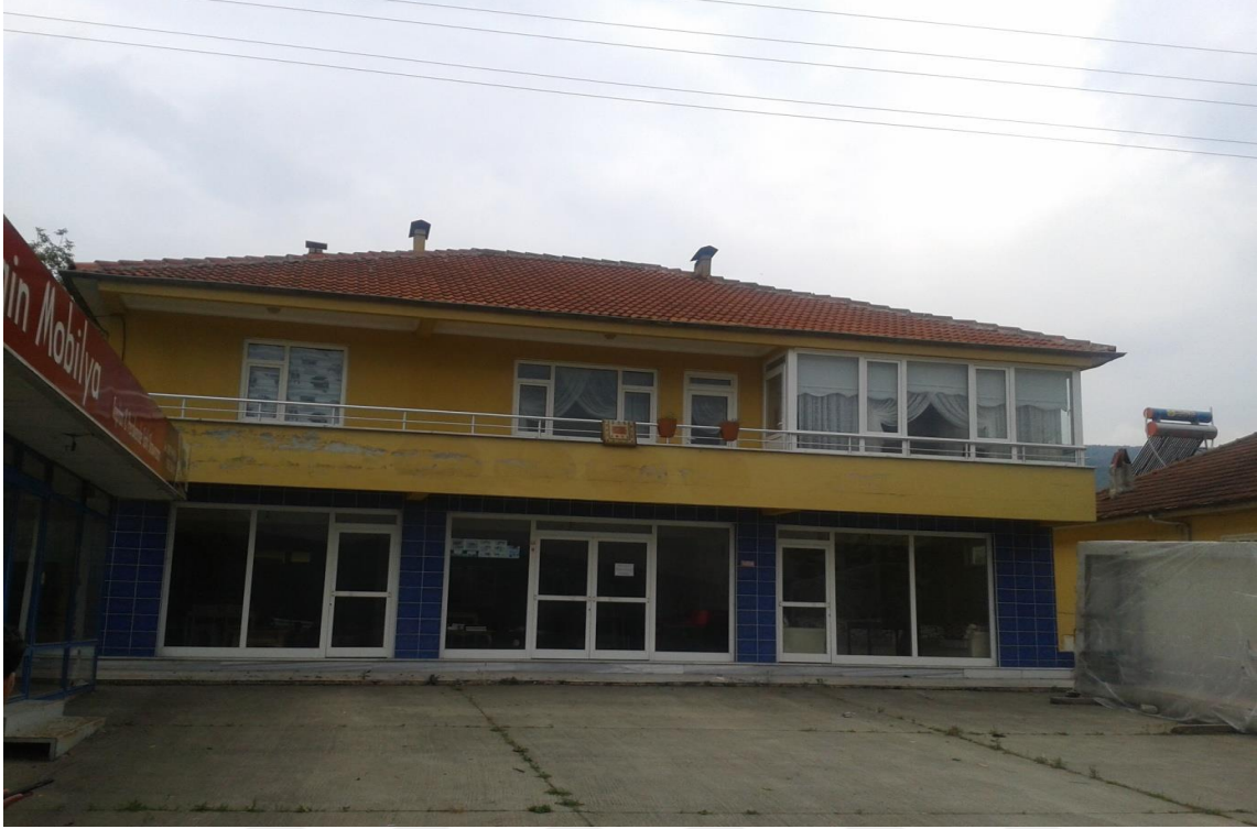
Resim 3.22. Yıkılan 5 katlı binanın aynı yerinde 2002’de yapılan 2 katlı betonarme bina (2014), (H.Bayraktar)
