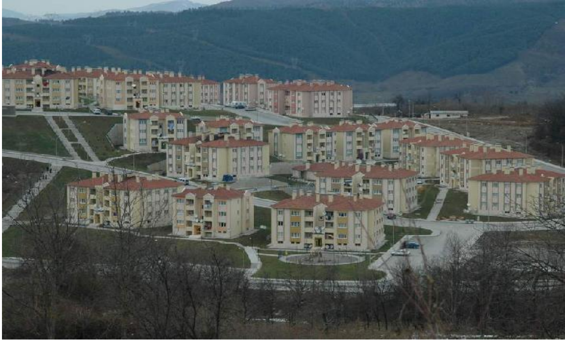
Resim 3.12. 12 Kasım 1999 Depremi sonrası yeni yerleşim yeri Kaynaşlı kalıcı konutlardan genel görünüm (2014), (Kaynaşlı Kriz Yönetim Merkezi Arşivi).
