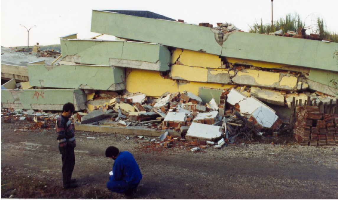
Resim 3.19. Bina yükünün artmasına neden olan parapetli balkonlar ve duvarlar ile kalın döşeme ve kirişler altında dayanamayıp kırılan tüm ara kat kolonları sonucu meydana gelen hasar (1999), (Kaynaşlı Kriz Yönetim Merkezi Arşivi).
