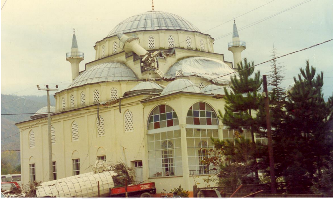
Resim 3.43. 12 Kasım 1999 Depremi. Camide meydana gelen hasar (1999), (Kaynaşlı Kriz Yönetim Merkezi Arşivi).
