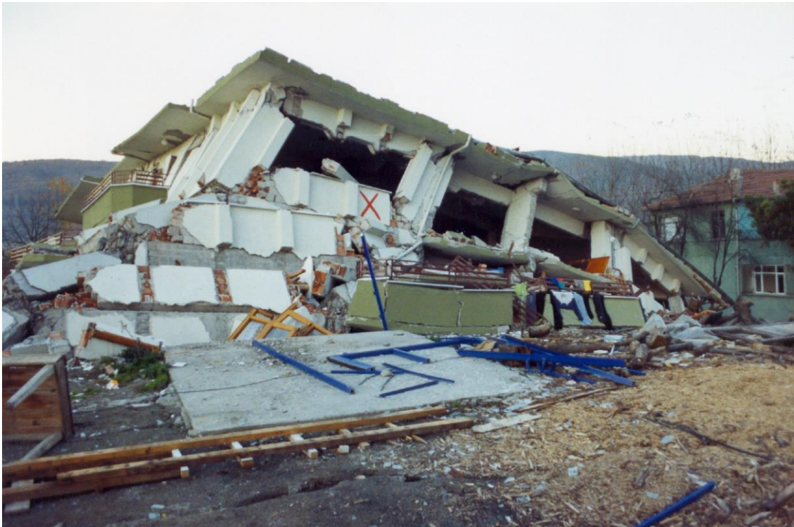
Resim 3.20. Ara kat kolonlarının kırılması sonucu 4 kattan tek kata inen bina (1999), (Kaynaşlı Kriz Yönetim Merkezi Arşivi).
