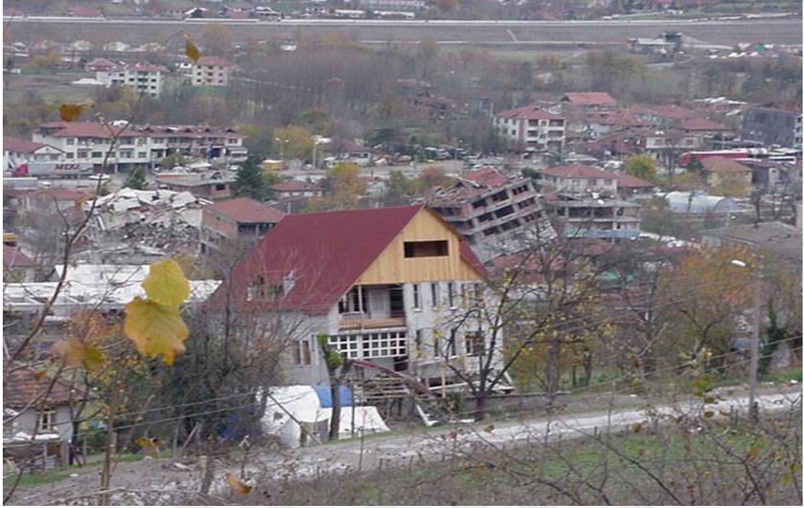
Resim 3.9. Kaynaşlı’da 12 Kasım 1999 Depreminde meydana gelen yıkım (1999), (Kaynaşlı Kriz Yönetim Merkezi Arşivi).
