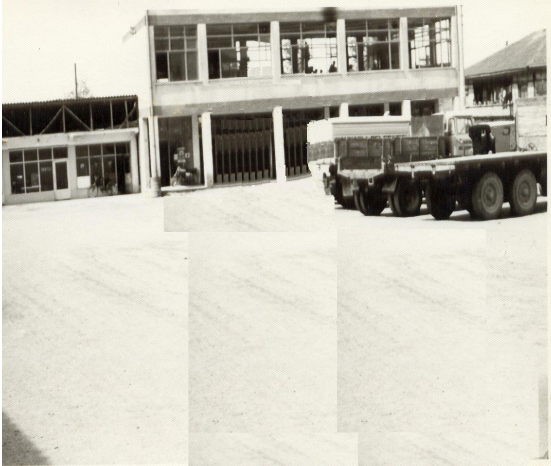
Resim 3.33. 12 Kasım 1999 Depremi öncesi Kaynaşlı Belediye binası inşaatı (1977), (Kaynaşlı Kriz Yönetim Merkezi Arşivi).
