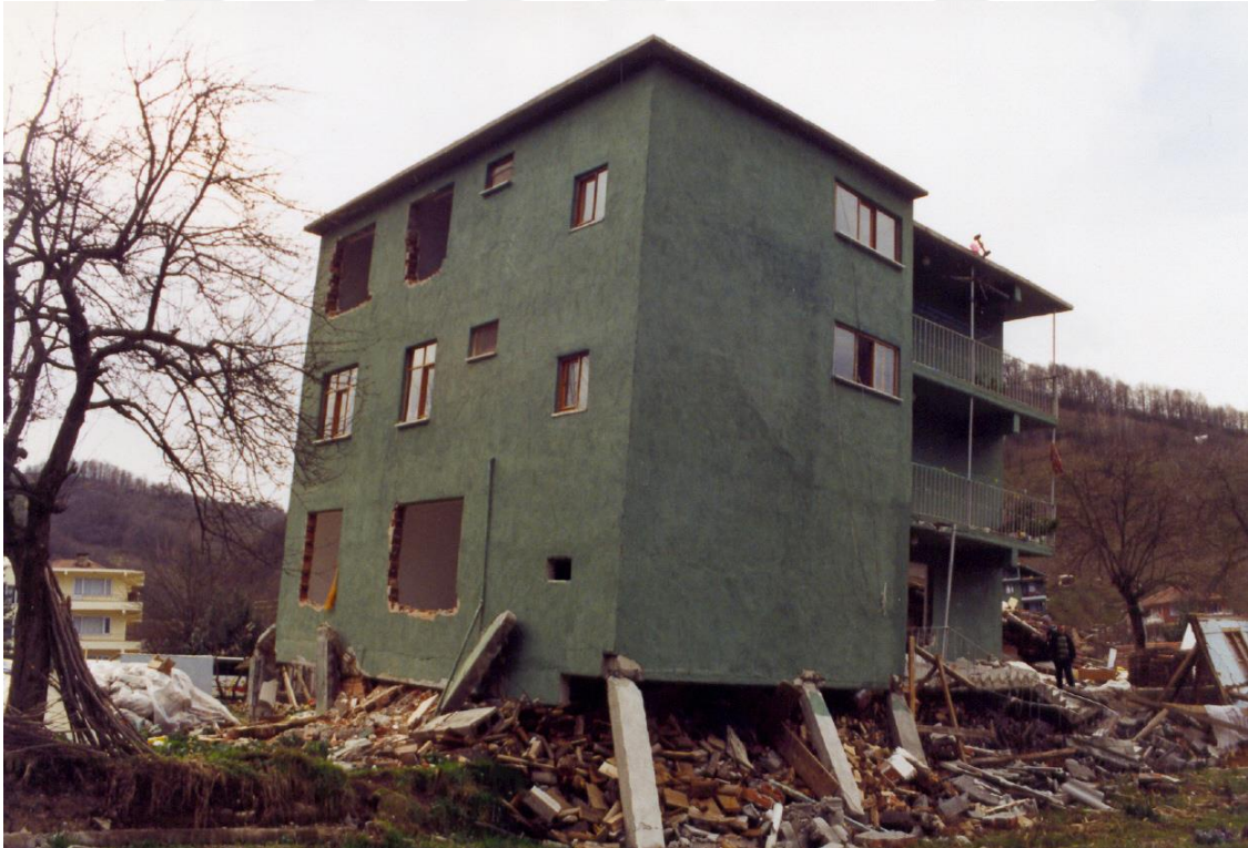
Resim 3.18. Deprem ve bina yükü altında dayanamayan yetersiz boyutta kolonlar birleşim yerlerinden kırılması sonucu meydana gelen hasar (1999), (Kaynaşlı Kriz Yönetim Merkezi Arşivi).
