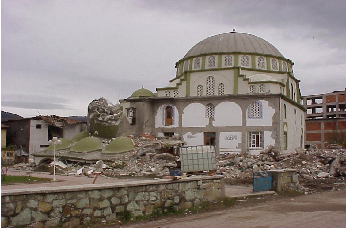
Resim 3.40. 12 Kasım 1999 Depremi. Camide meydana gelen hasar (1999), (Kaynaşlı Kriz Yönetim Merkezi Arşivi).
