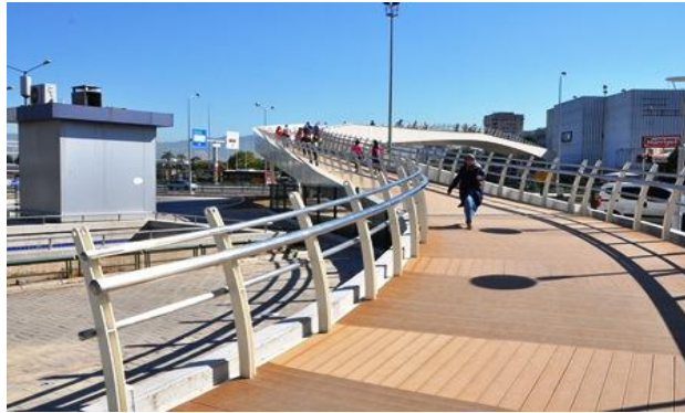
Şekil 3.14: Konak Üstgeçit Örneği, İzmir Büyükşehir Belediyesi
