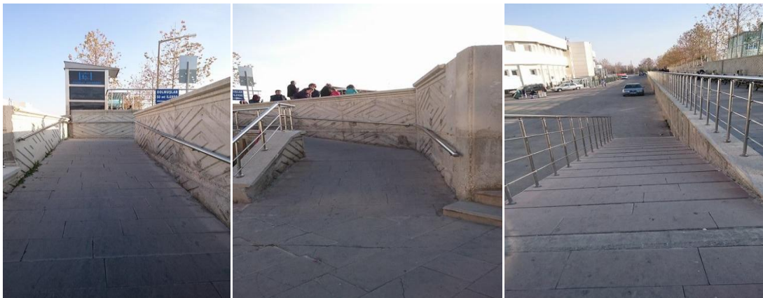
Fotoğraf 3.6.30: Araştırmanın Yapıldığı Bölgede Bina Giriş Rampası Görüntüsü, Tıp Fakültesi B Blok Girişi, Selçuklu Üniversitesi
