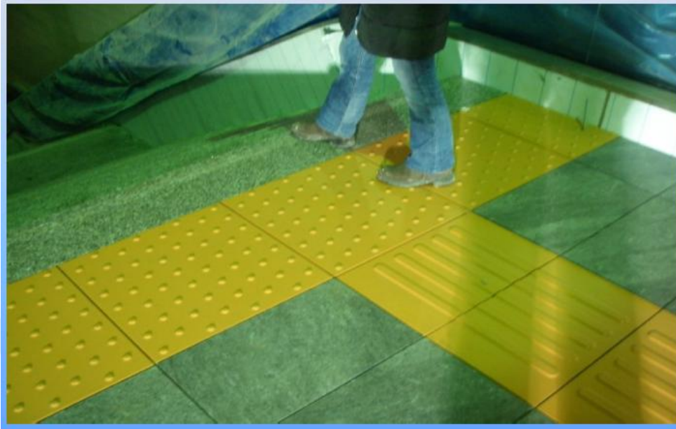
Şekil 3.34: Kadıköy- Kartal Metro Projesinde Zemin Uygulamaları II (OLUMLU ÖRNEK)
