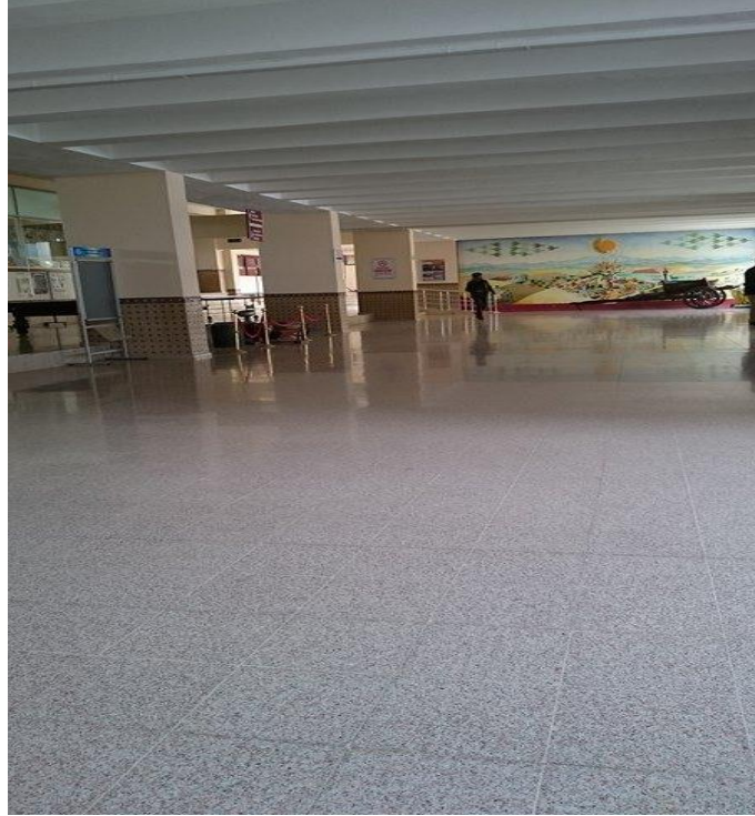
Fotoğraf 3.7.25: Araştırmanın Yapıldığı Bölgede Hissedilebilir Yüzey Olmayan Alan, Ziraat Fakültesi, Selçuk Üniversitesi (OLUMSUZ ÖRNEK)
