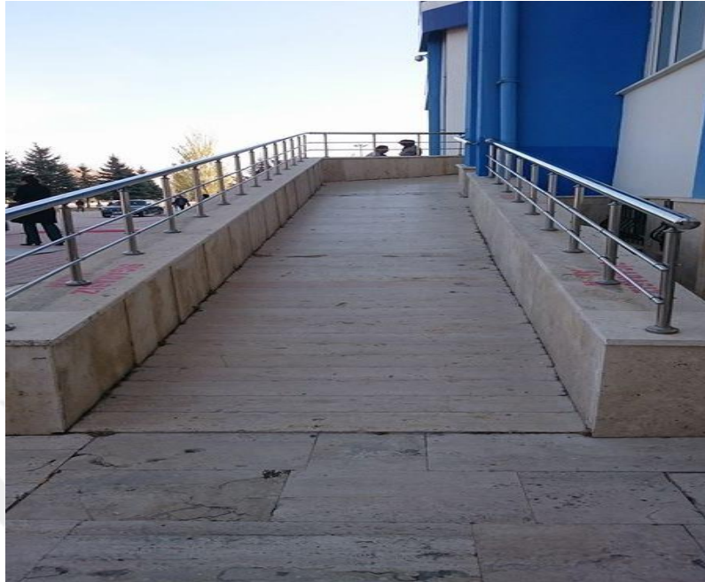
Fotoğraf 3.6.32: Araştırmanın Yapıldığı Bölgede Bina Giriş Rampası Görüntüsü, Tıp Fakültesi D Blok Girişi, Selçuklu Üniversitesi
