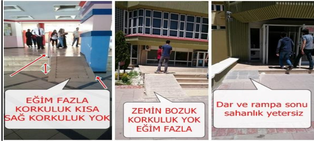
Fotoğraf 3.6.27: Araştırmanın Yapıldığı Bölgede Bina Giriş Ve İçi Rampası Görüntüsü, Yemekhane, Selçuklu Üniversitesi
