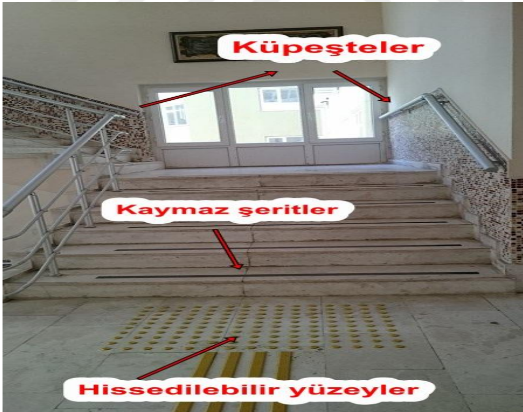
Fotoğraf 3.4.20: Araştırmanın Yapıldığı Bölgede Merdiven Görüntüsü, Fen Fakültesi, Selçuk Üniversitesi
