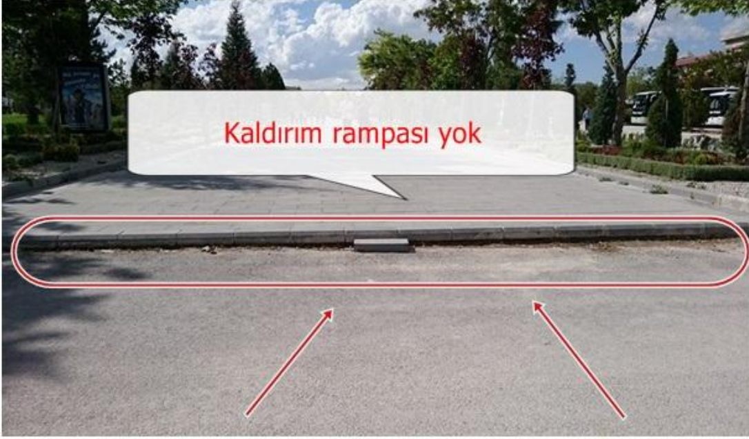
Fotoğraf 3.2.21: Araştırmanın Yapıldığı Bölgede Kaldırım Rampası olmayan Alan, Selçuk Üniversitesi (OLUMSUZ ÖRNEK)
