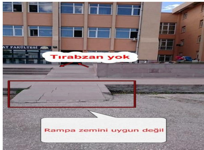
Fotoğraf 3.6.23: Araştırmanın Yapıldığı Bölgede Bina Giriş Rampası Görüntüsü, Edebiyat Fakültesi, Selçuk Üniversitesi
