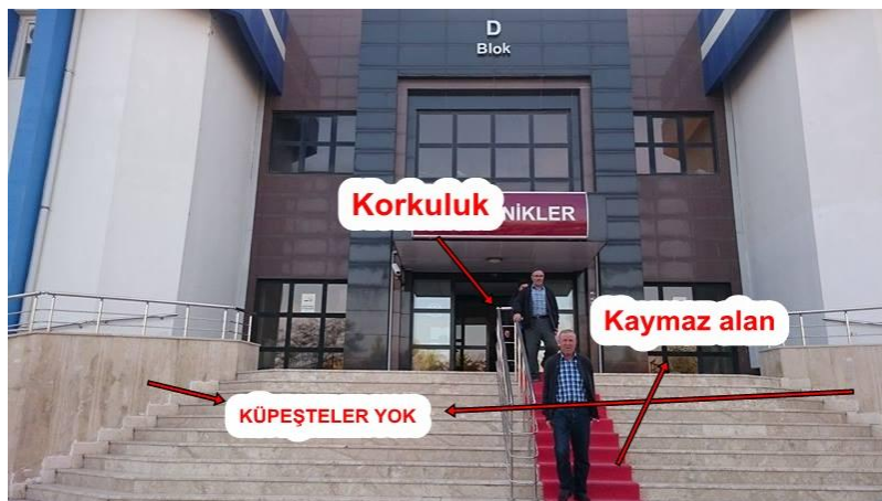
Fotoğraf 3.4.14: Araştırmanın Yapıldığı Bölgede Merdiven Görüntüsü, Tıp Fakültesi D Blok Girişi, Selçuk Üniversitesi
