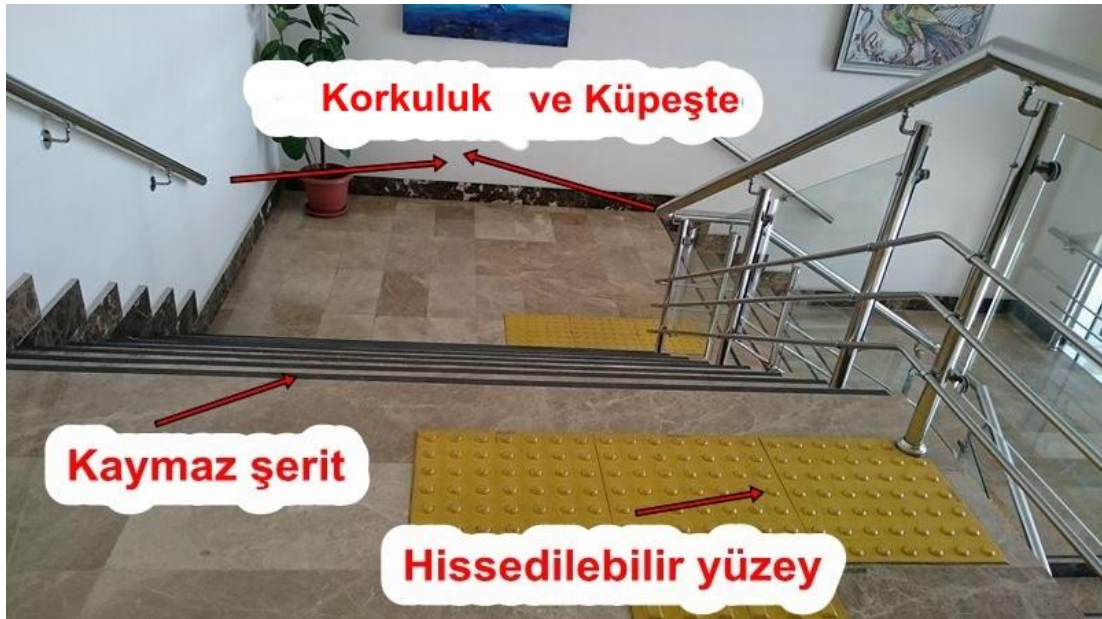
Fotoğraf 3.4.5: Araştırmanın Yapıldığı Bölgede Merdiven Görüntüsü, Karatay Üniversitesi (OLUMLU ÖRNEK)
