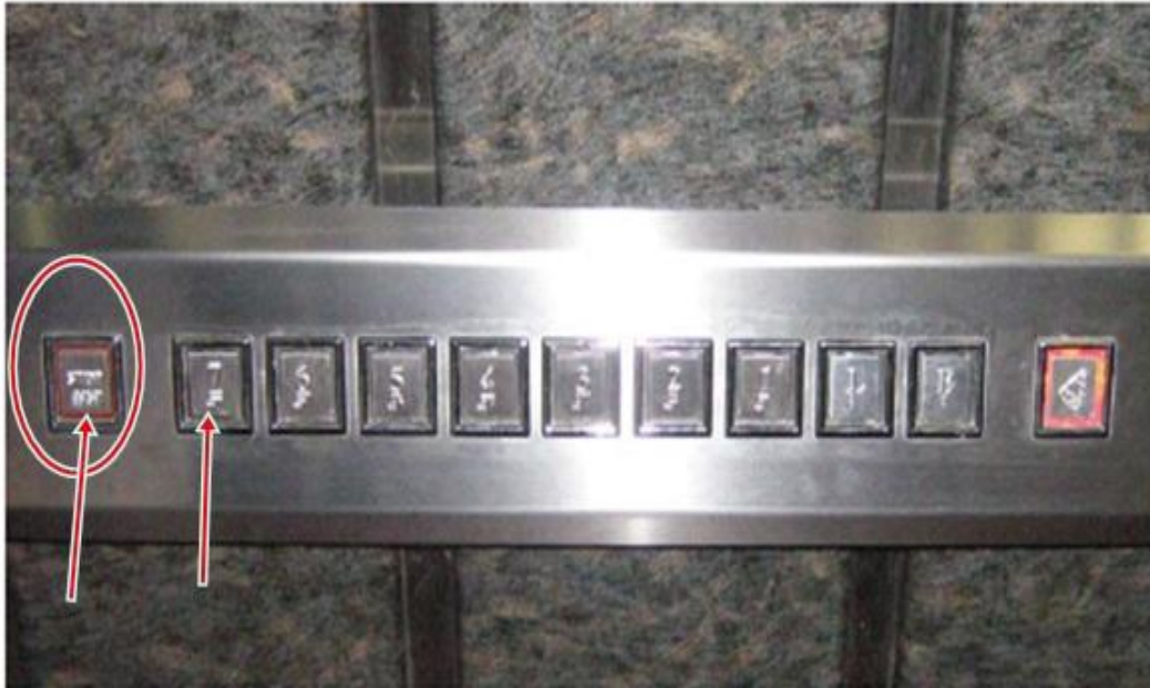
Şekil 3.20: Act Panorama Park Otel Asansör Giriş Kapısı, Görme Engelliler İçin Kabartmalı Kontrol Düğmeleri
