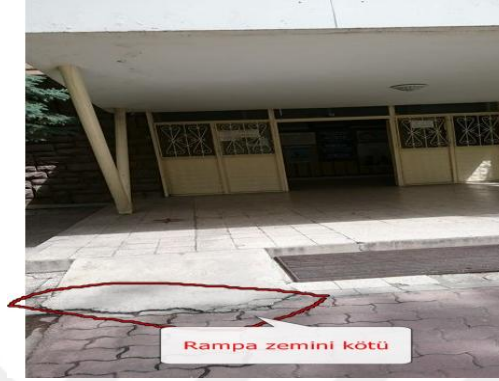
Fotoğraf 3.6.12: Araştırmanın Yapıldığı Bölgede Bina Giriş Rampası Görüntüsü, Meram Kaymakamlığı
