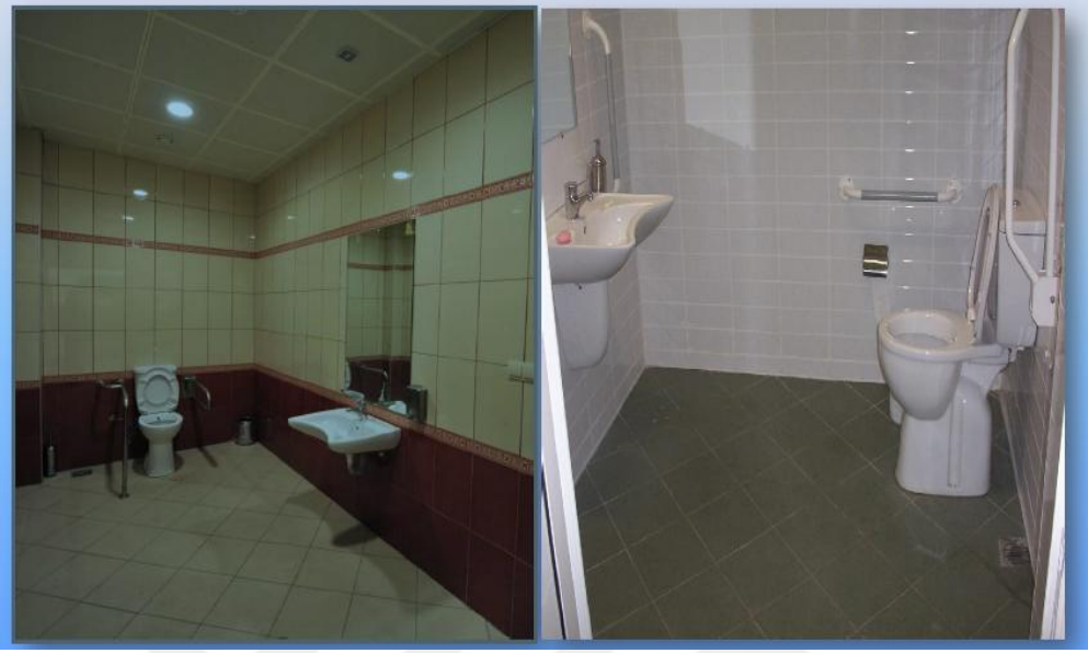
Şekil 3.28: Şişhane İstasyonu (OLUMLU ÖRNEK)
