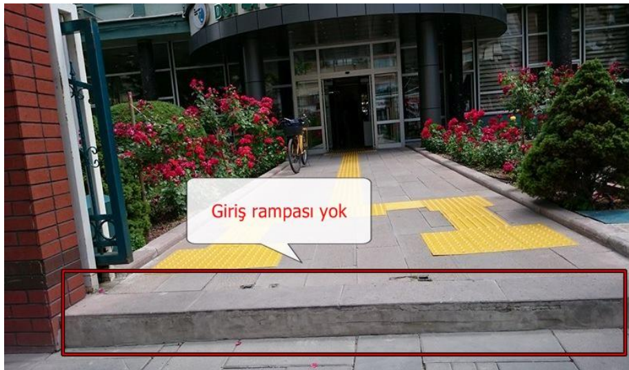
Fotoğraf 3.6.20: Araştırmanın Yapıldığı Bölgede Bina Giriş Rampası Olmayan Alan Görüntüsü, DSİ Bölge Müdürlüğü
