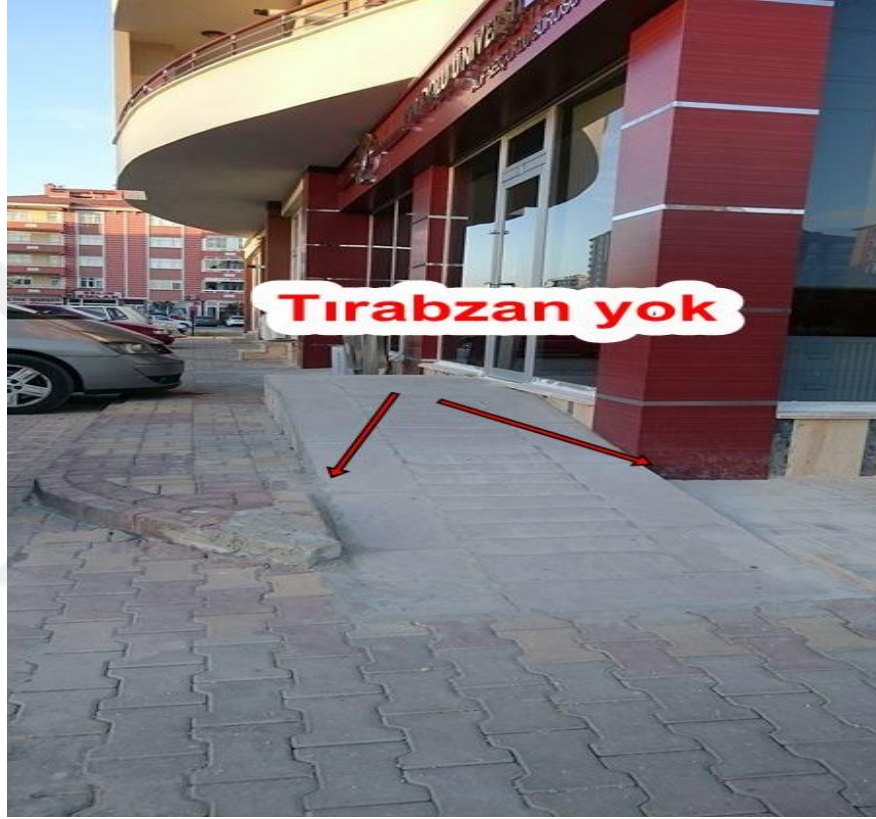
Fotoğraf 3.6.18: Araştırmanın Yapıldığı Bölgede Bina Giriş Rampası Görüntüsü, AÖF Selçuklu Bürosu
