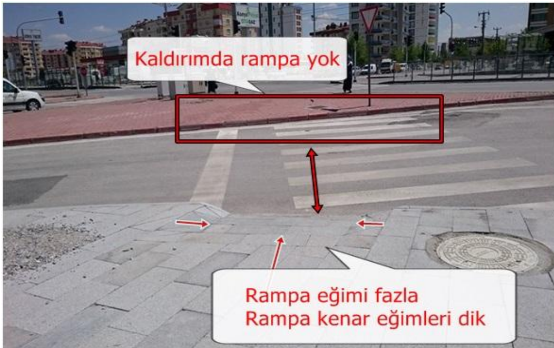
Fotoğraf 3.2.24: Araştırmanın Yapıldığı Bölgede Kaldırım Rampası Görüntüsü, Spor ve Kongre Merkezi Tramvay Durağı Karşısı
