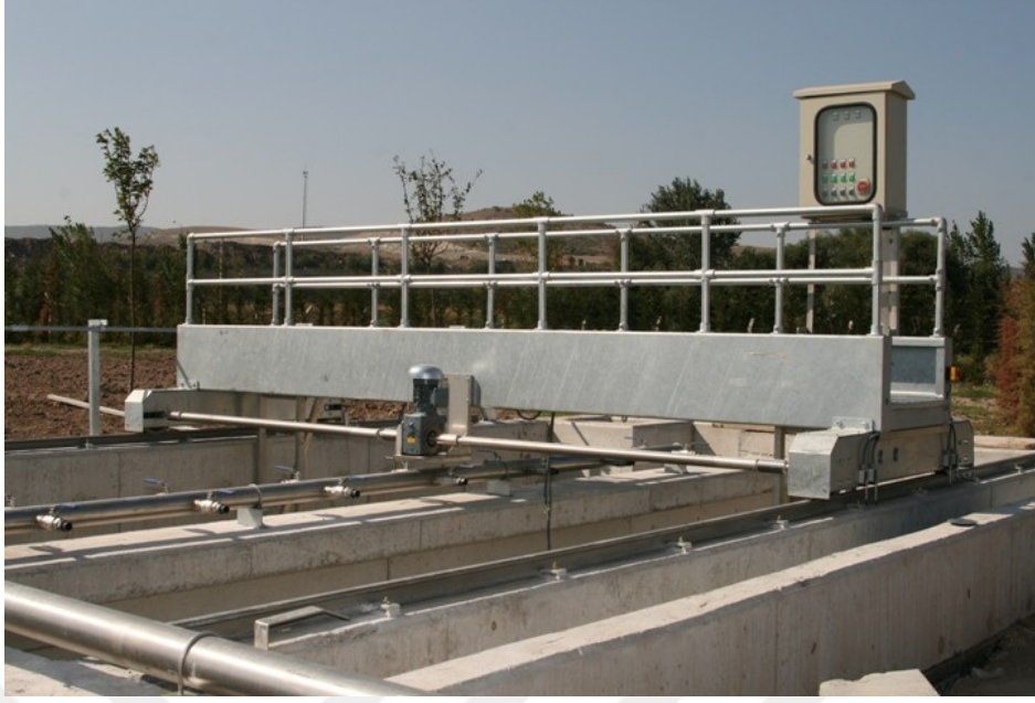
Şekil 1.4. Tipik kum ve yağ tutucu
