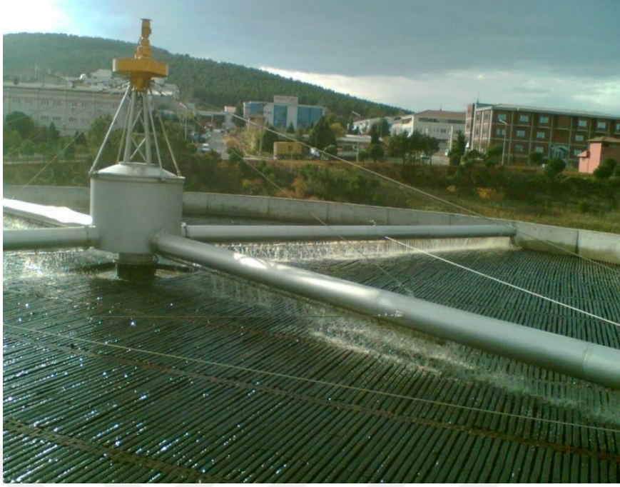
Şekil 1.8. Tipik bir damlatmalı filtre sistemi
