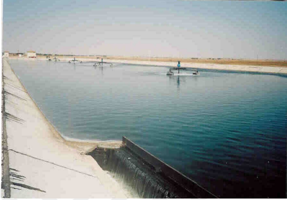
Şekil 4.23. Akçakale arıtma tesisi
