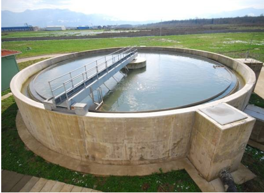
Şekil 1.5. Tipik ön çökeltim havuzu
