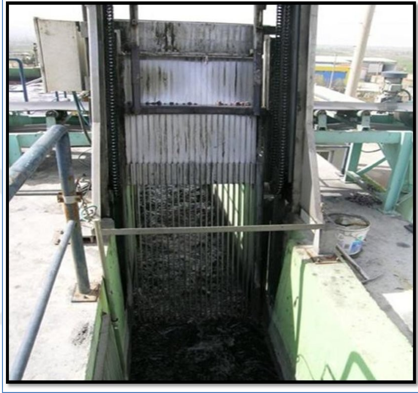
Şekil 1.3. Tipik ızgara yapısı
