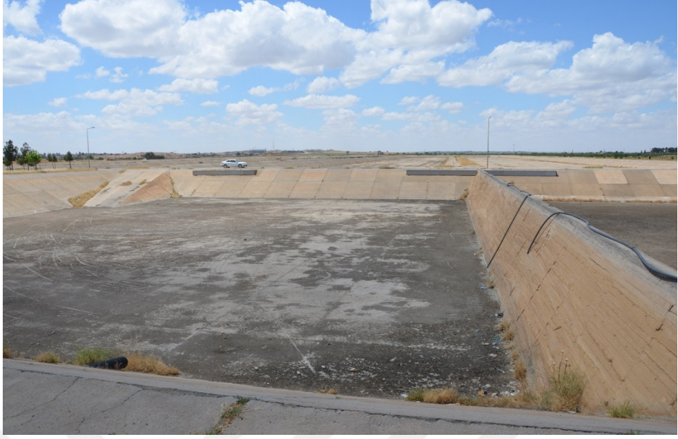
Şekil 4.15. Ceylanpınar A.A.T. anaerobik stabilizasyon havuzu
