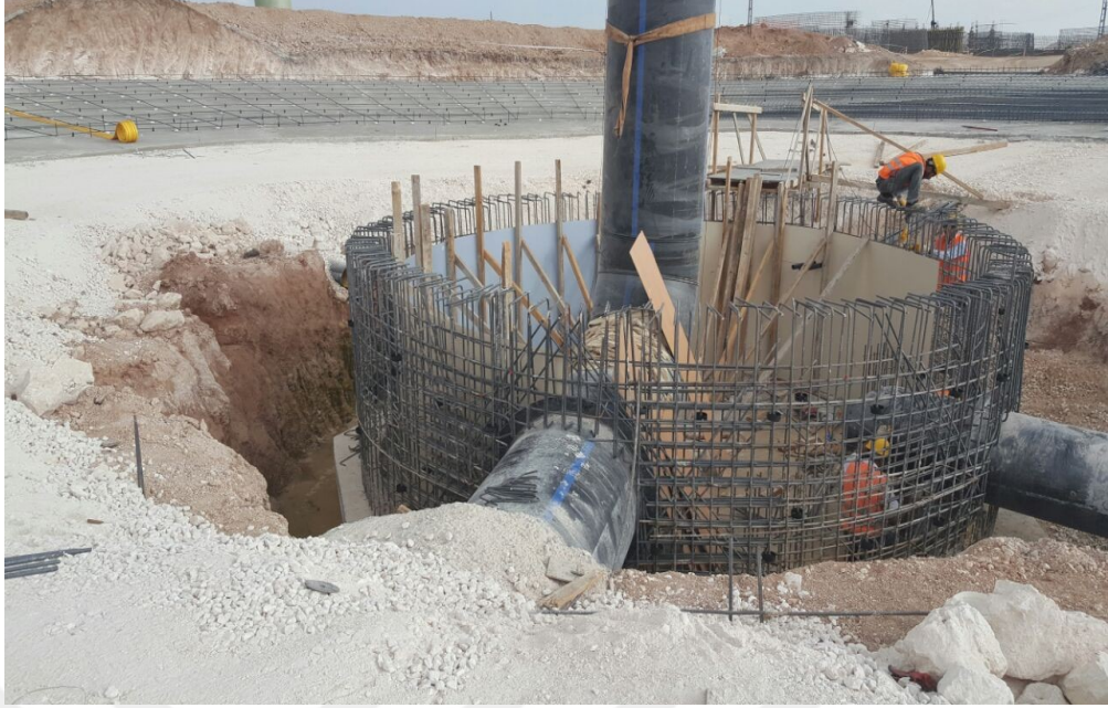
Şekil 4.3. Şanlıurfa merkez AAT inşaatı (son çökeltim tankı)
