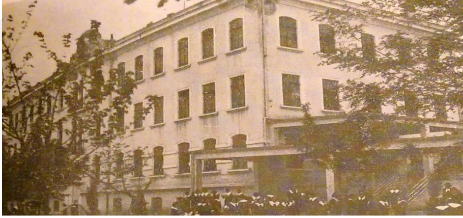
Şekil 6.24. Trakya Köy Öğretmen Okulu, [74]
