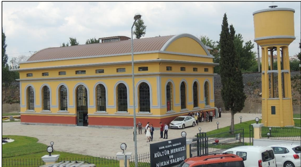
Şekil 6.5. Edirne Tarihi Elektrik Fabrikası (Gökşen, 2017)
