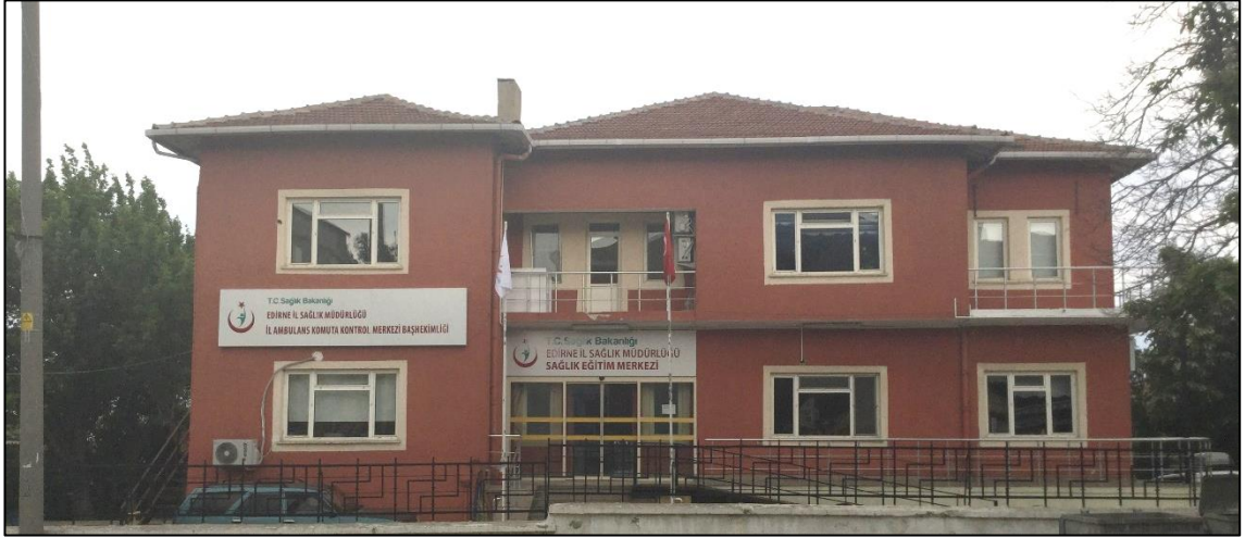
Şekil 6.1. Edirne'de Yeni Yapılan Umumi Müfettişlik Binası (Gökşen, 2017)
