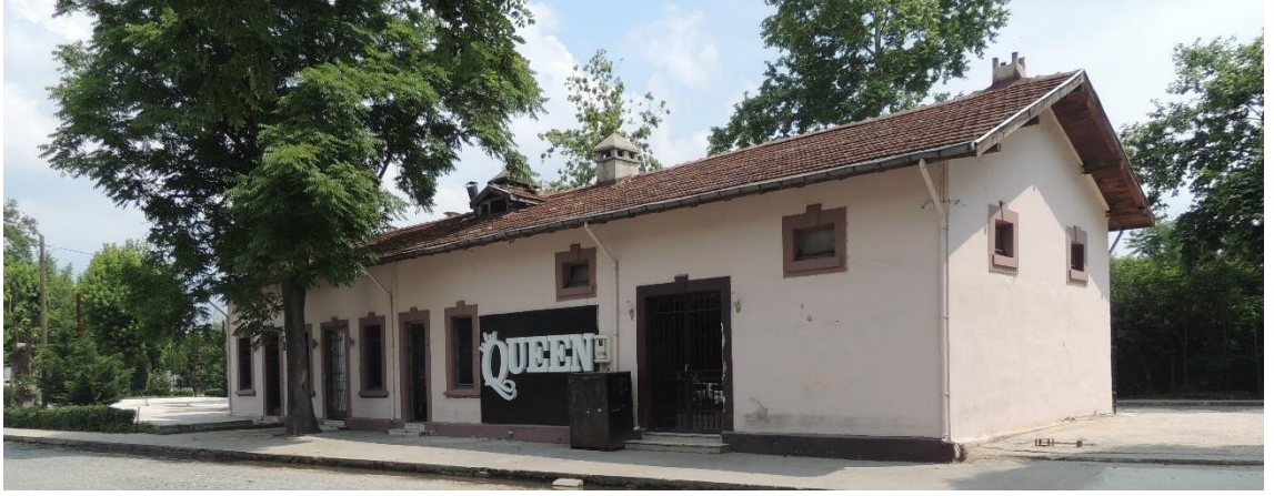
Şekil 3.15. Edirne Küçük Şehir İstasyon Binası (Gökşen, 2017)
