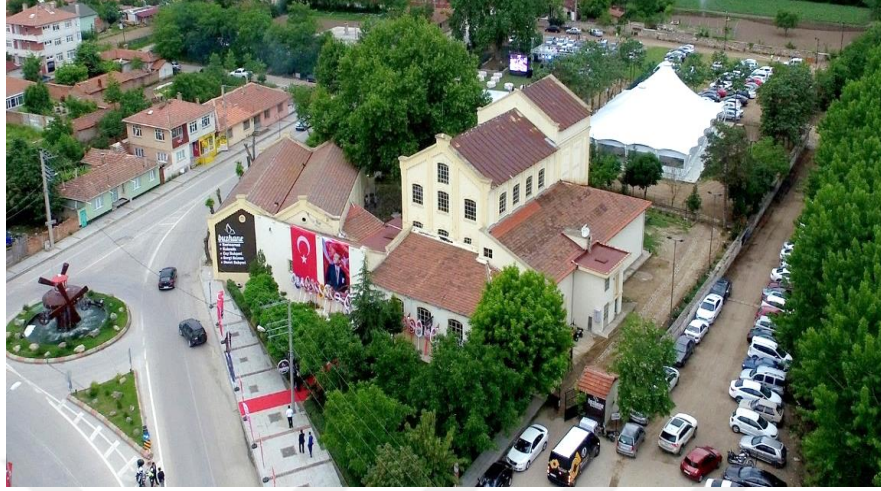
Şekil 3.28. Edirne Buzhane Binası [71]
