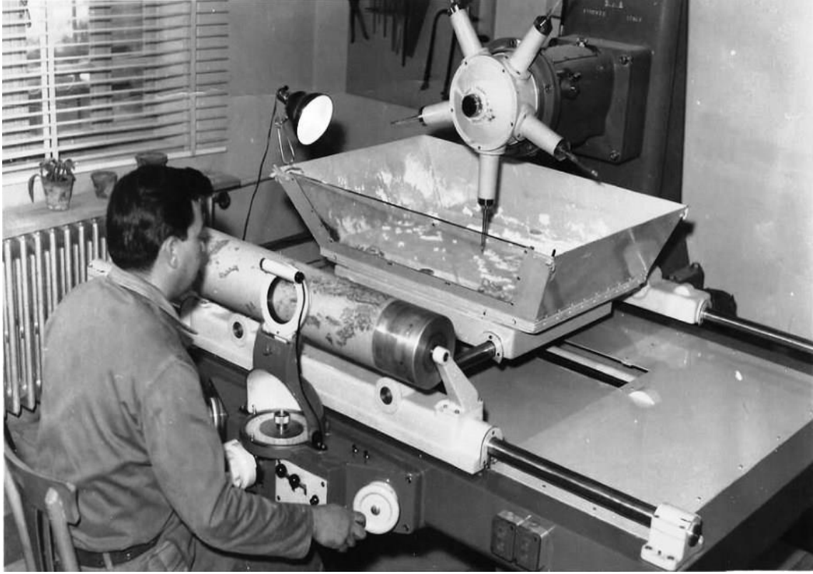
Resim 4.3 1971 Yılı Kabartma Harita Üretimi, Freze Aletinde Çalışma ( İnt. Kyn. 11).
