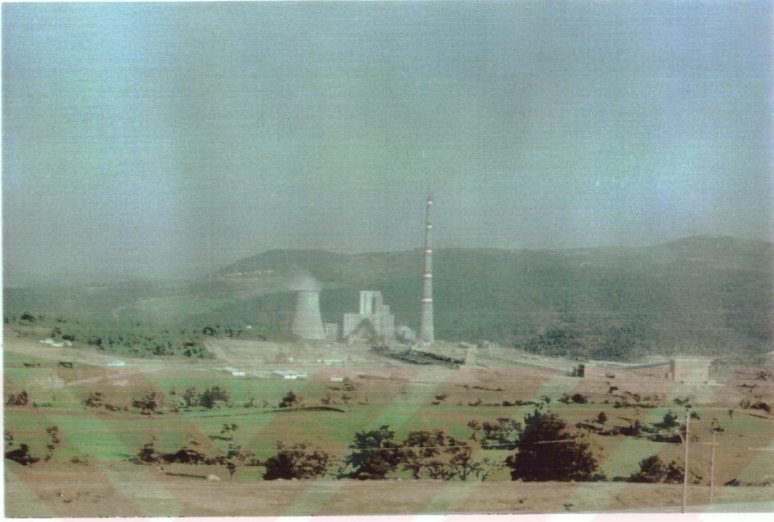
Şekil 1.1. Santralin genel görünüşü
