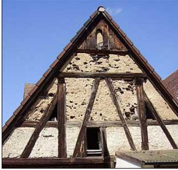
Şekil 3.10 Omurgalı kerpiç tekniği [76]
