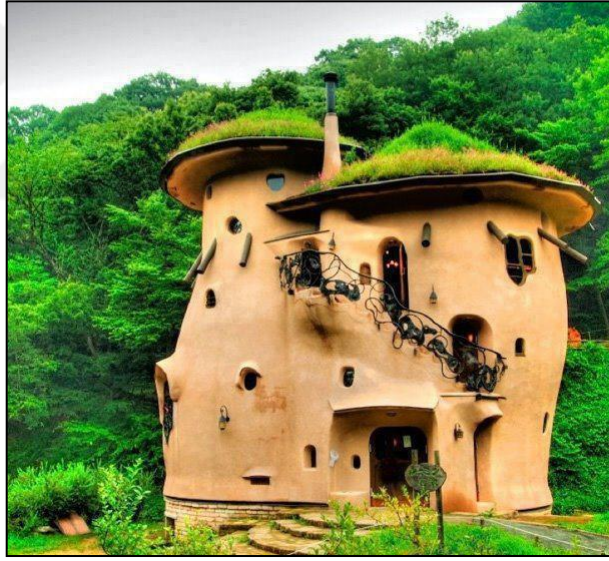
Şekil 3.7 Dökme toprak tekniği ile inşa edilmiş ev [74]
