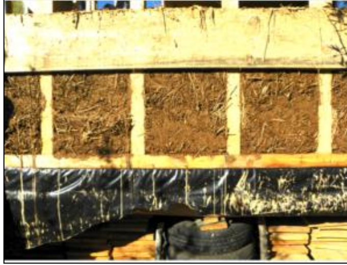
Şekil 3.16 Hafif toprak tekniğinde kalıp [80]
