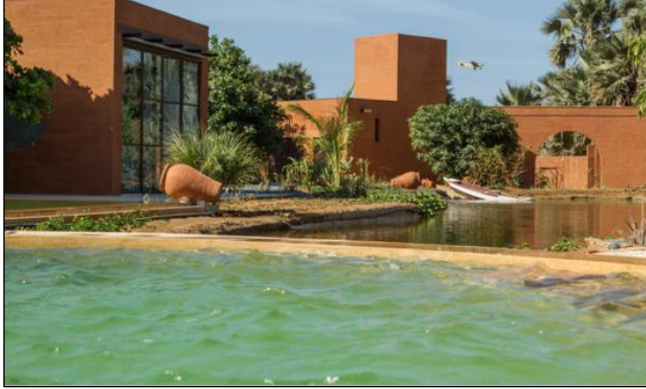
Şekil 3.14 Sıkıştırılmış toprak tuğla ve yerinde dökme toprak teknikleri ile inşa edilmiş Khamisa evi, Senegal [79]
