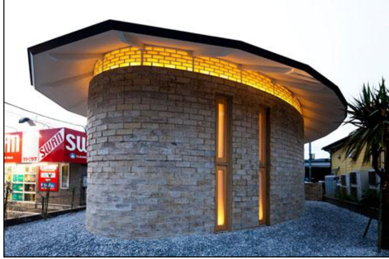
Şekil 3.20 Toprak blok projesi, Atelier Tekuto, Tokyo [85]
