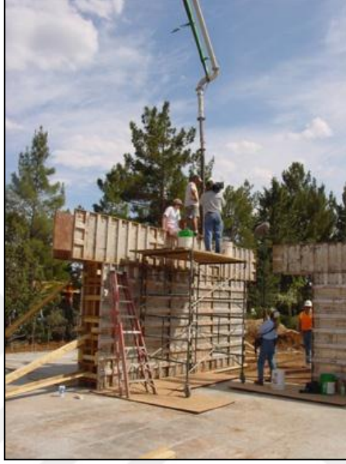
Şekil 3.12 Yerinde dökme toprak tekniği uygulama [78]
