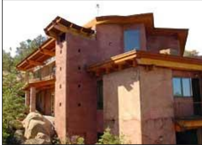
Şekil 3.13 Yerinde dökme toprak tekniği [78]
