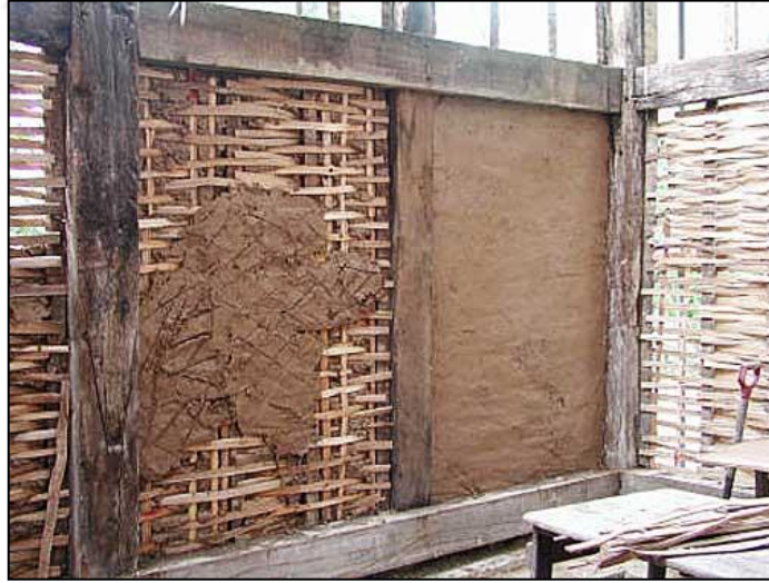
Şekil 3.9 Omurgalı kerpiç tekniği uygulama [76]
