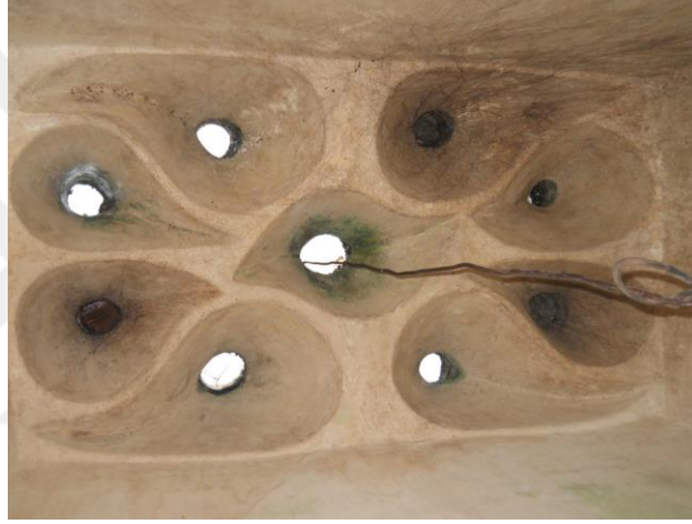
Resim 172: Beylerbeyi Hamamı Ilıklık Halvet Hücre Örtüsü
