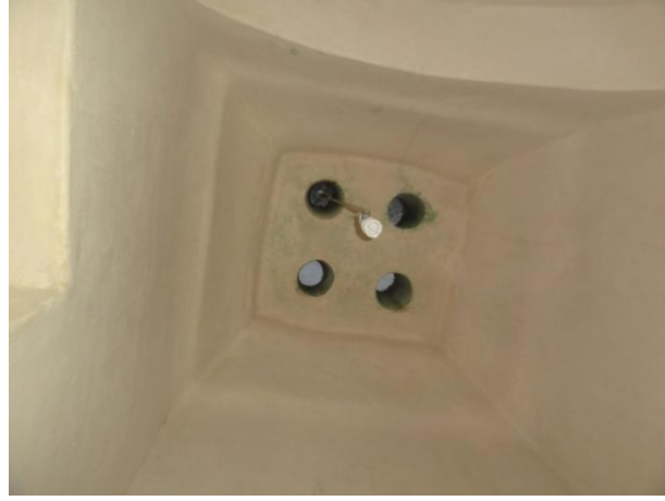
Resim 31: Kadınlar Kısım- Helâ Hücresi Örtüsü
