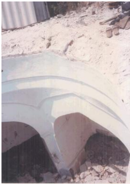
Resim 42: İskele Hamamı, Restorasyon Sürecinde Durum
