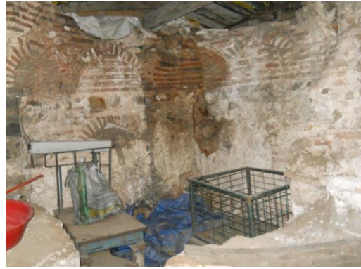
Resim 148: Ayazma Hamamı Sıcaklık Bölümü, Halvet Hücresi
