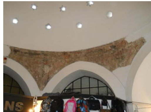
Resim 62: Sıcaklık Kubbesi Geçiş Öğeleri
