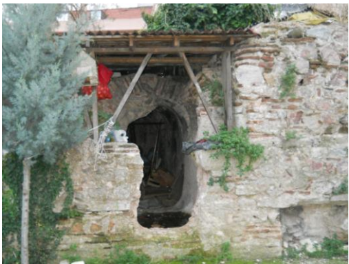
Resim 147: Ayazma Hamamı, Doğü Cephe Yıkılan Külhan Kısmı
