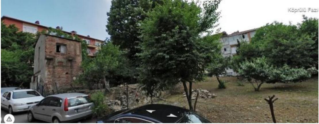
Resim 8: Köprülü Konak Hamamı Restorasyon Öncesi Su Deposu
