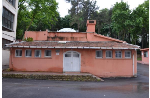
Resim 206: Kuleli Hamamı-Kuzey Cephe
