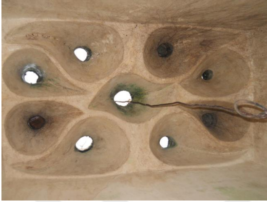
Resim 258: Beylerbeyi Hamamı- Ilıklık Helâ ve Halvet Üniteleri Tonoz Yüzeyi
