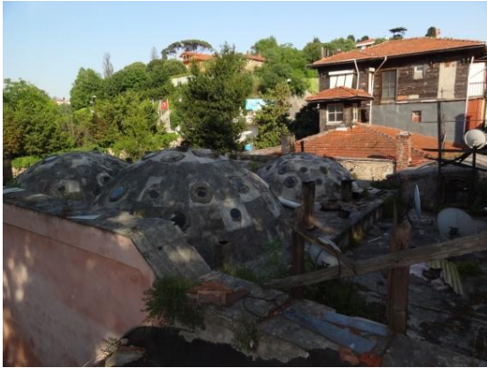
Resim 166: Beylerbeyi Hamamı, Kuzeybatı'dan Örtü Öğeleri
