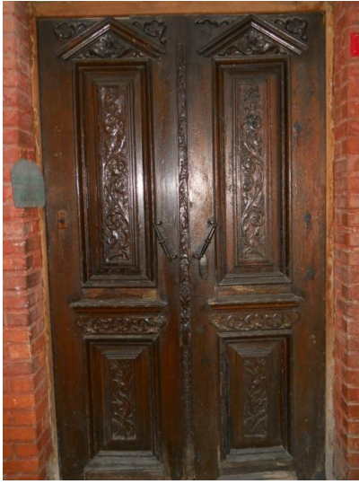
Resim 256: Beylerbeyi Hamamı Ahşap Giriş Kapısı
