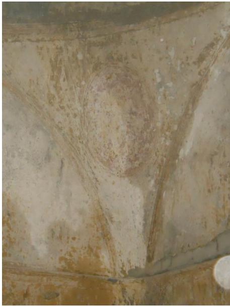
Resim 225: İcadiye Dağ Hamamı, Sıcaklık Kubbesi Pendentif Detayı
