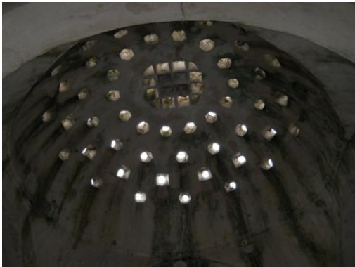
Resim 185: Selimiye Hamamı, Sıcaklık Kubbesi
