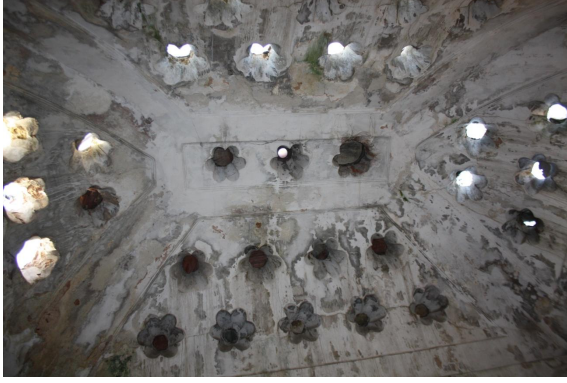
Resim 240: Altunizade Hamamı, Ilıklık Aynalı Tonoz Örtüsü (İdris Botan)
