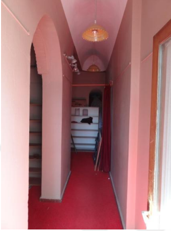
Resim 198: Ziver Bey Köşk Hamamı Köşk Parselinde Kalan Kısım Giriş
