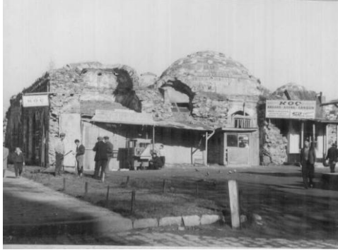
Resim 44: Büyük Hamam, Güney Cephe (İst. 6 No.lu KVKBK Arşivi)
