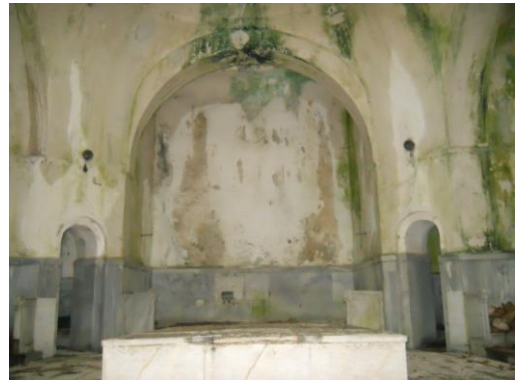
Resim 186: Sıcaklık Genel Görünüm
