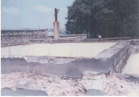
Resim 40: İskele Hamamı, Kaldırılan Örtü Sistemi Sonrasındaki Durum (İst. 6 No.lu KVKBK Arşivi)
