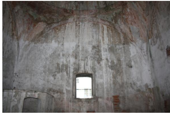
Resim 243: Altunizade Hamamı, Sıcaklık Kubbe Geçiş Ögeleri (İdris Botan)
