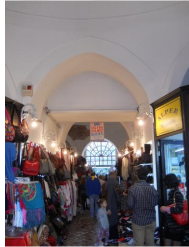
Resim 58: Eyvan Girintisi Yıkılarak Birbirine Bağlanan Sıcaklıklar
