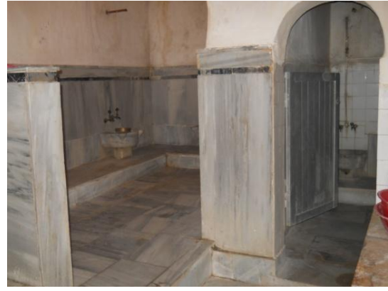
Resim 161: Beylerbeyi Hamamı, Ilıklık Sağdaki Bölüm
