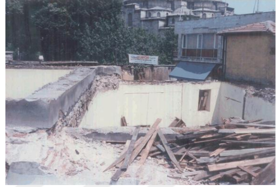
Resim 41: İskele Hamamı, Kaldırılan Örtü Sistemi Sonrası Durum (İst. 6 No.lu KVKBK Arşivi)
