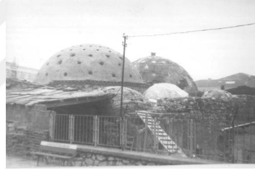
Resim 67: Valide-i Atik Hamamı, Örtü Öğeleri (İst. 6 No.lu KVKBK Arşivi)
