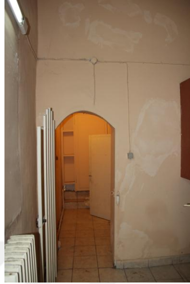
Resim 214: Kuleli Hamamı Külhan Girişi
