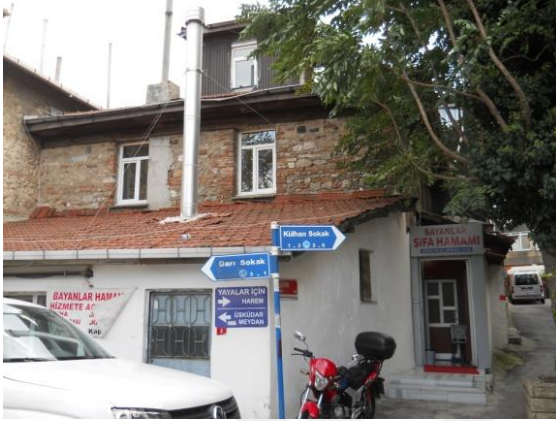
Resim 14: Rum Mehmed Paşa Hamamı Kadınlar Kısmı Girişi
