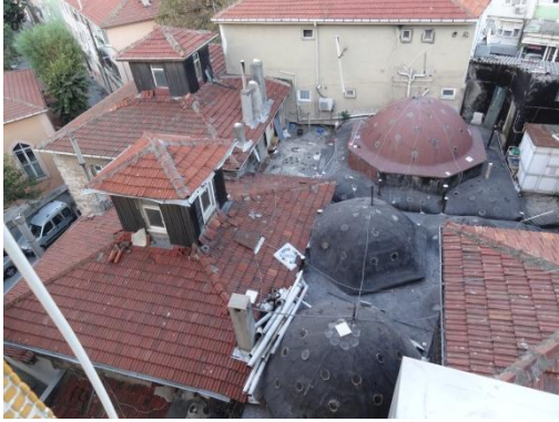
Resim 9: Rum Mehmed Paşa Hamamı Genel Görünüm
