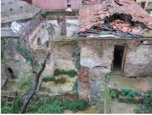
Resim 250: Kuzguncuk Küçük Hamamı Batı Cephesi
