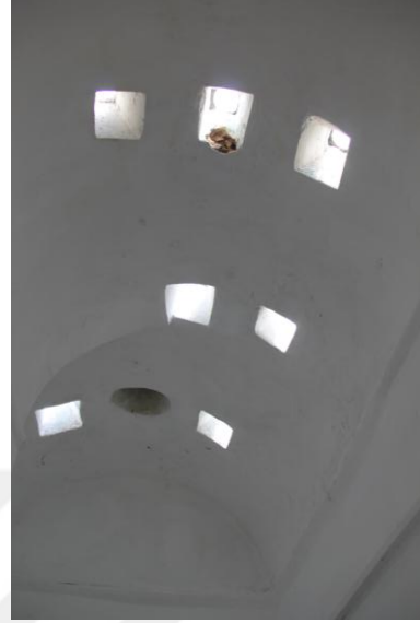
Resim 208: Kuleli Hamamı Ilıklık Tonozu
