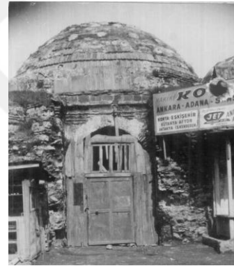
Resim 56: Kuzey Cephesi (İst. 6 No.lu KVKBK Arşivi)
