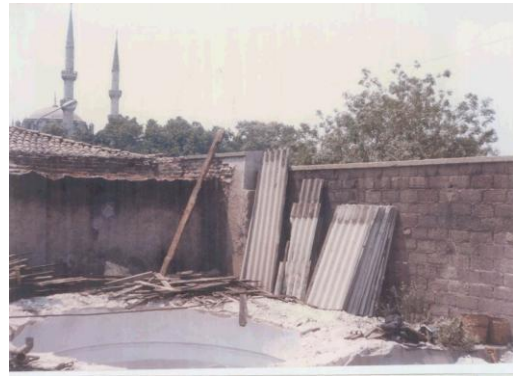
Resim 43: İskele Hamamı Restorasyon Sürecinde Durum
