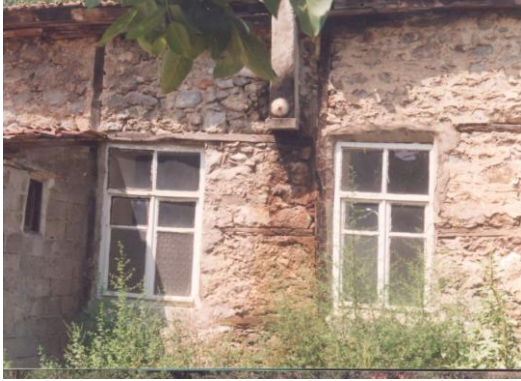
Resim 108: Güney Cephe, Soyunmalık (İst. 6 No.lu KVKBK Arşivi)
