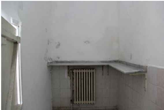
Resim 209: Kuleli Hamamı Ilıklık Kısım
