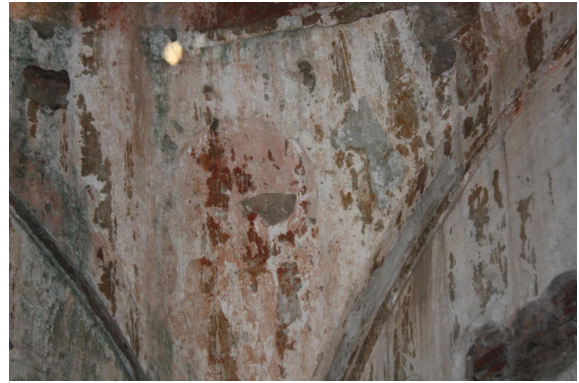
Resim 247: Altunizade Hamamı, Sıcaklık Kubbesi Pandantif (İdris Botan)
