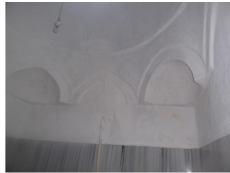
Resim 100: Kadınlar Kısmı Sıcaklık Kubbe Geçiş Ögesi
