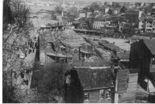
Resim 45: Büyük Hamam, Güney Cephe (İst. 6 No.lu KVKBK Arşivi)
