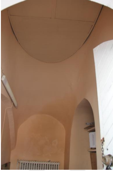
Resim 213: Kuleli Hamamı Müştemilat Kısım
