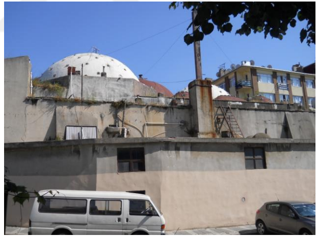
Resim 123: Kuzey Cephe, Külhan, Su Deposu ve Odunluk Kısımları
