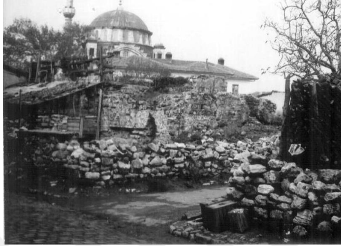
Resim 151: Ayazma Hamamı Genel Görünüş (İst. 6 No.lu KVKBK Arşivi)
