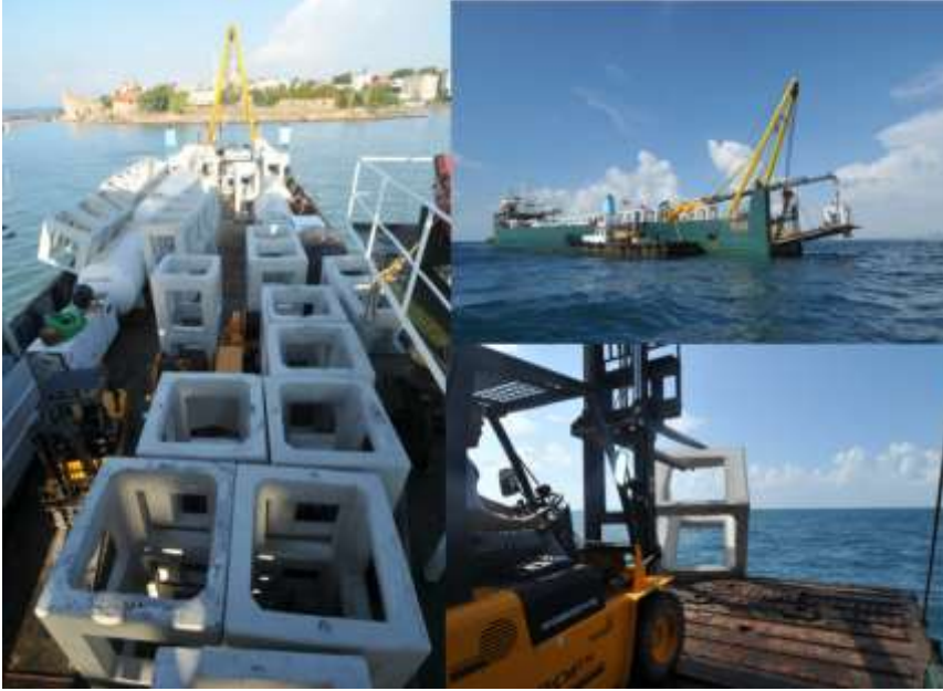
Şekil 18 :Beton blokların denize atılması
