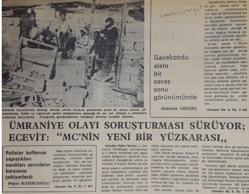
Figure 2.5 Mayday Neighbourhood after the demolition. Source: Abdullah Gelgeç, “Gecekondu Alanı Bir Savaş Sonu Görünümünde,” Cumhuriyet , September 4, 1977.
