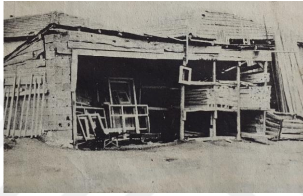
Figure 2.6 A geceköndü construction store. Source: Prof. Dr. Tansı Şenyapılı 's personal archive.
