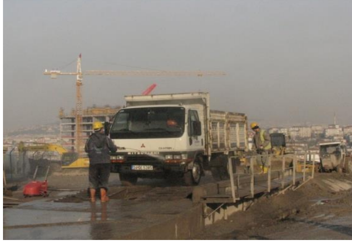
Şekil 6.4. Şantiye alanında hafriyat ve malzeme taşıyan kamyonların yıkanması (Baysan, 2014).
