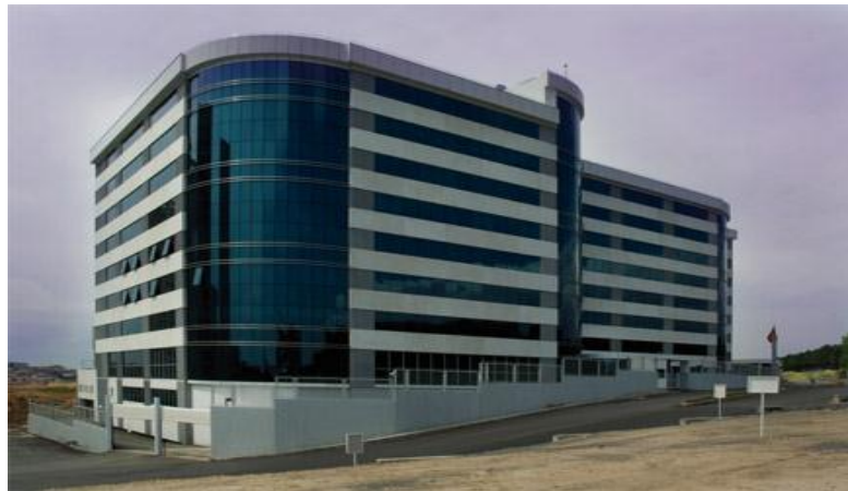
Şekil 1.10. Unilever Türkiye merkez ofis binası (ÇEDBİK, 2011)
