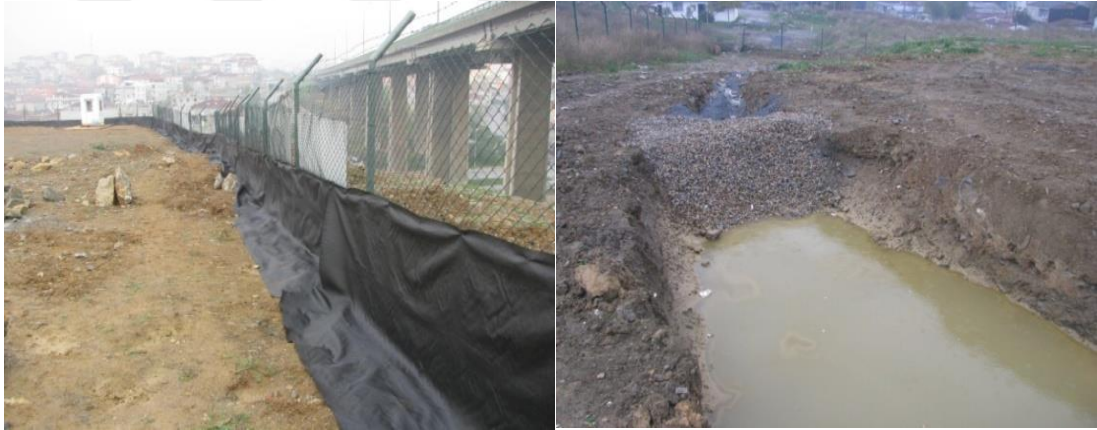
Şekil 6.3. Proje sahası çevresinin tekstil malzeme ile perdelenmesi ve su kanallarında toprak çökeltme sistemleri yapılması (Baysan, 2014).
