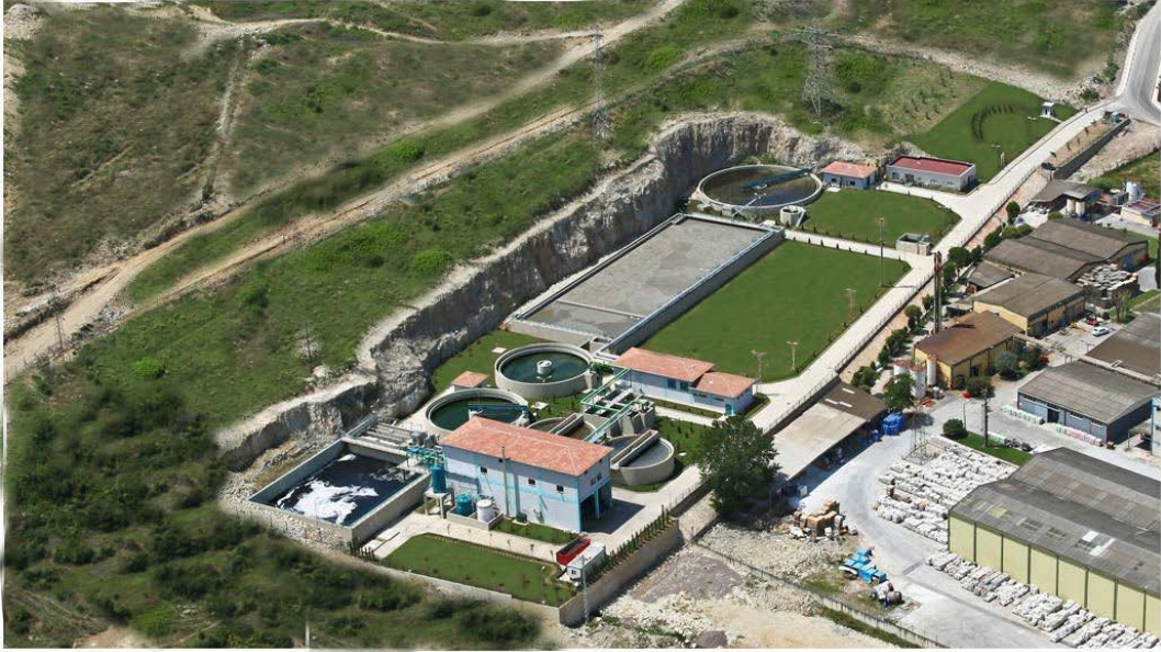
Şekil 4.7: Dilovası Atıksu Arıtma Tesisinin görünümü.
