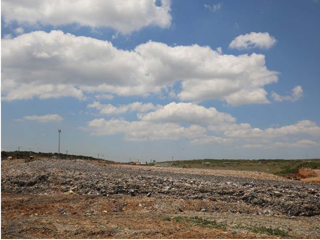
Şekil 4.12: Dilovası İzaydaş Düzenli Evsel Katı Atık Tesisinin Görünümü.
