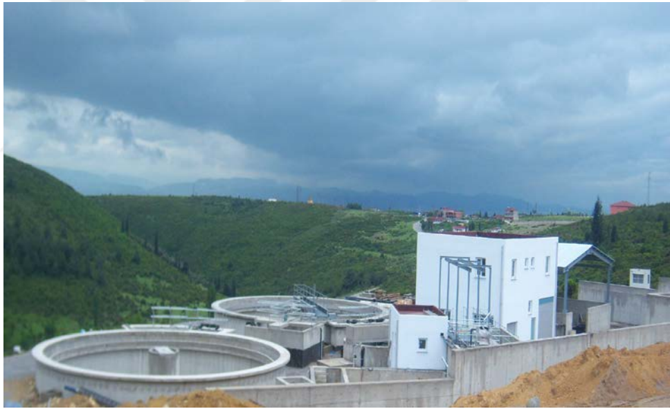
Şekil 4.10: Kömürcüler Organize Sanayi Bölgesi Atıksu Arıtma Tesisi.
