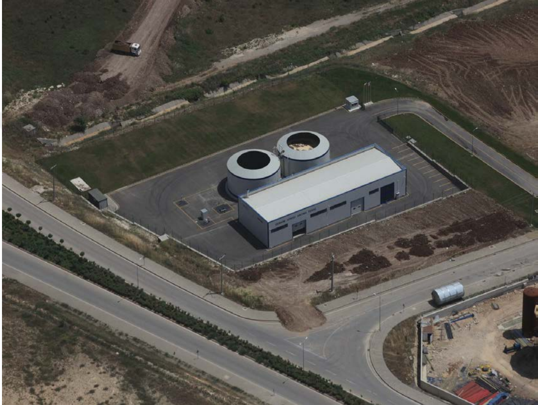
Şekil 4.11: V (Kimya) İhtisas Organize Sanayi Bölgesi Arıtma tesisi.
