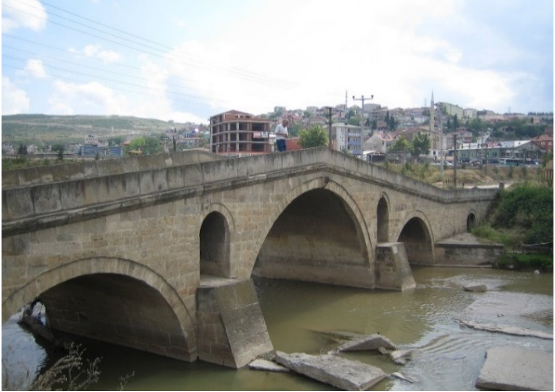
Şekil 2.1: Mimar Sinan tarafından yapılan Dilderesi üzerinde yer alan tarihi köprü.
