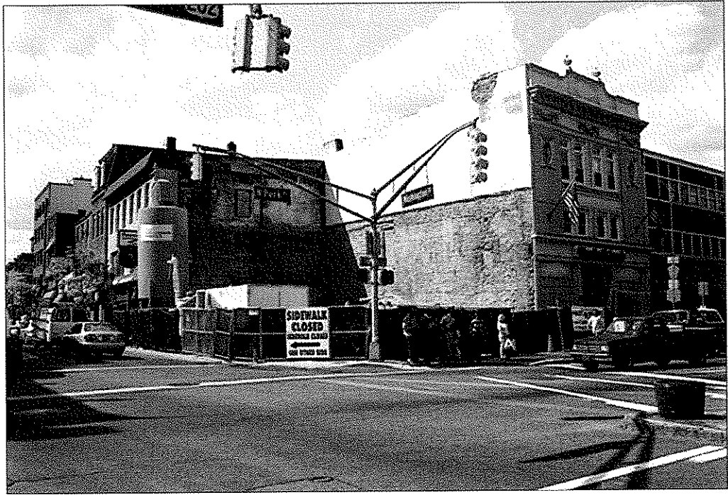
Şekil 4.2. Mevcut binanın yıkımından sonra uygulama alanın görünümü (Armijo, 2002)
