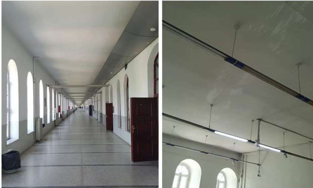
Şekil 6. 10 Ters kirişli birinci kat döşemelerinin düz tavan görünüşü
