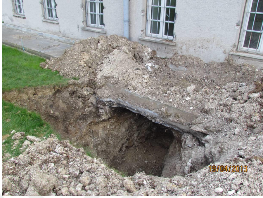
Şekil 6. 23 Araştırma çukurunun 1. ve 2.Kademe genel görünüşü [128]
