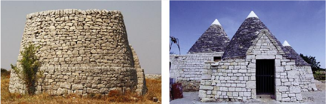
Şekil 3. 4 Harçsız taş duvar örnekleri [38]
