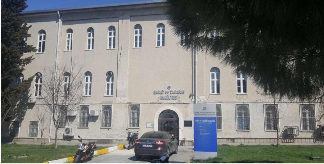
Şekil 6. 7 Bodrum katın dışarıdan ve içeriden görünüşü (devamı)
