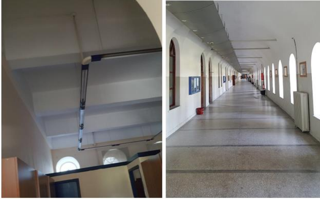
Şekil 6. 9 Zemin kat kirişleri ve tonoz örtülü koridor
