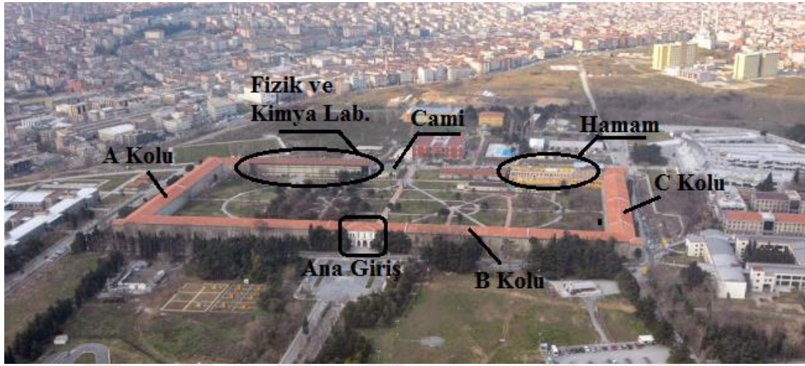
Şekil 6. 16 Davutpaşa Kışlası'nın günümüzdeki görünüşü [126]
