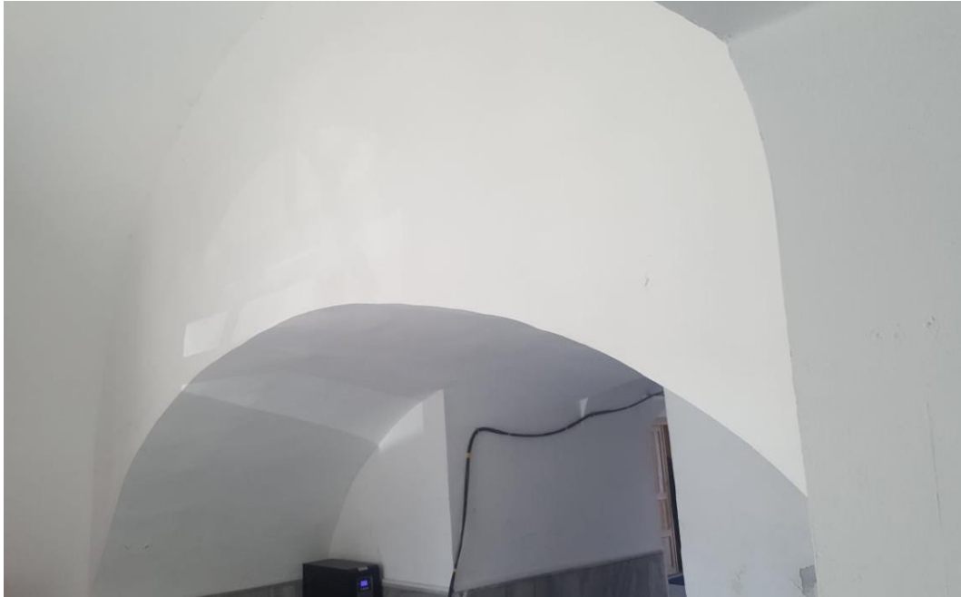
Şekil 6. 7 Bodrum katın dışarıdan ve içerden görünüşü
