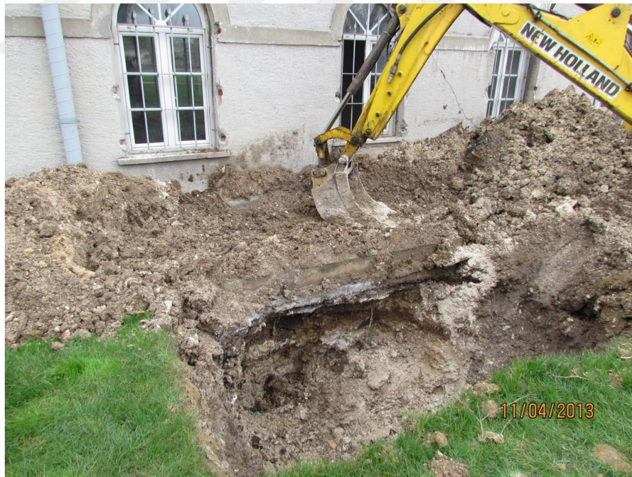
řekil 6. 18 Kışlanın kuzey kesiminde aılmakta olan 1. Kademe arařtırma ukuru [128]
