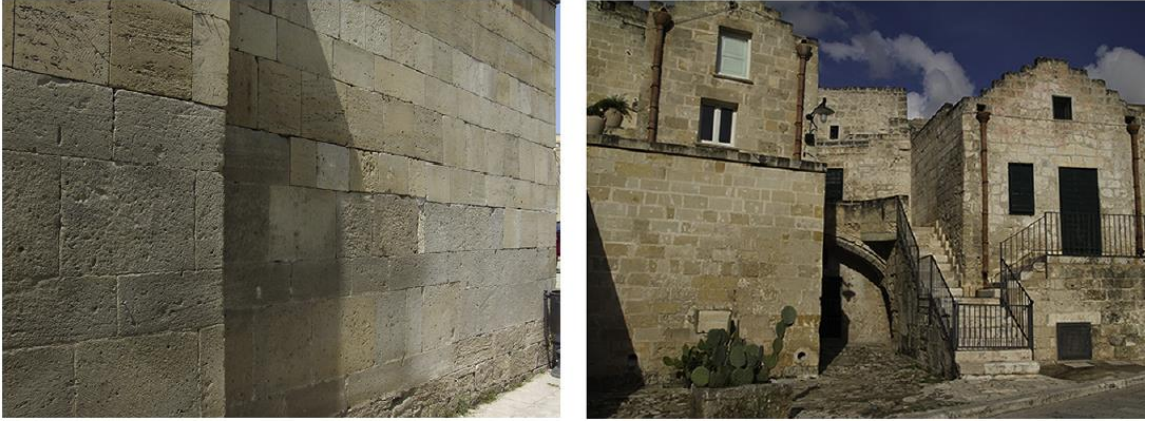
Şekil 3. 7 Kesme taş duvarlar [38]
