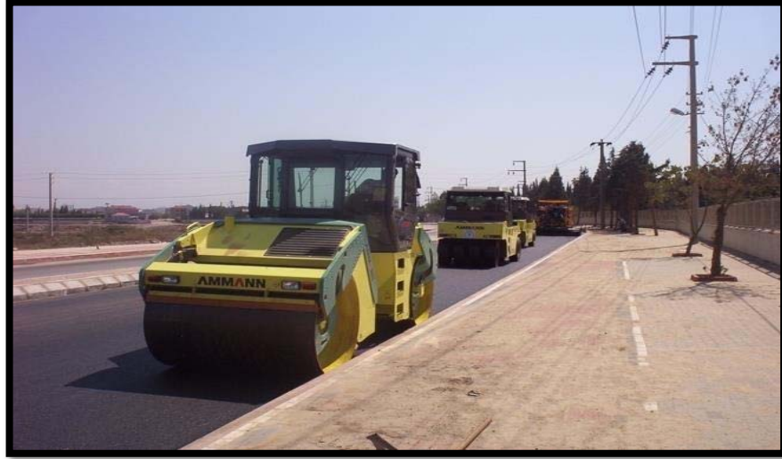
Şekil 1.7. Aşınma tabakası uygulaması (KGM, Mart 2012)
