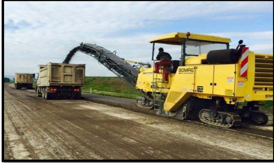
Şekil 1.14. Asfalt kazıma makinesi (Anonim 2)
