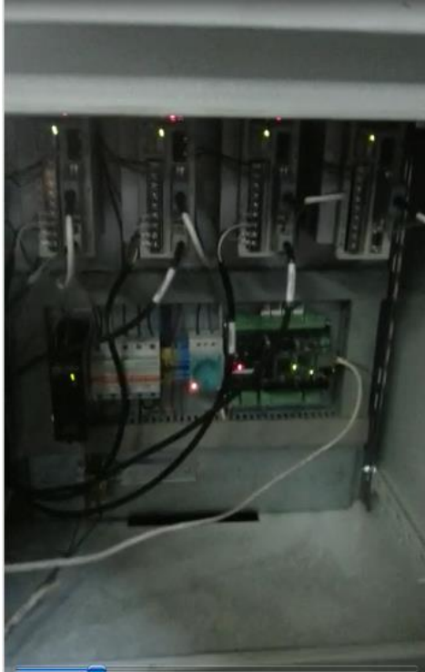
Resim 1.3. Kılavuz çekme makinası kontrol panosu
