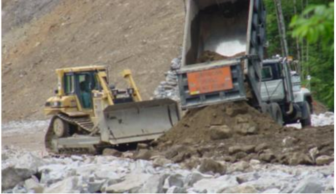
Şekil 3.9. Kaya Dolgu Üzerindeki Buldozer
