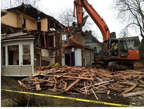
Şekil 2.5. Yıkım İçin Kullanılan İtici Kollar
