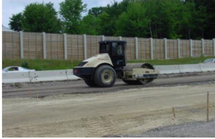
Şekil 3.3. Titreşimli Silindir İle Sıkıştırma
