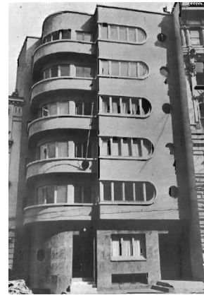
Kira Evi, Ayazpaşa Mimar: Adil Denkteş, Arkitekt 1936 Sayı:05-06
