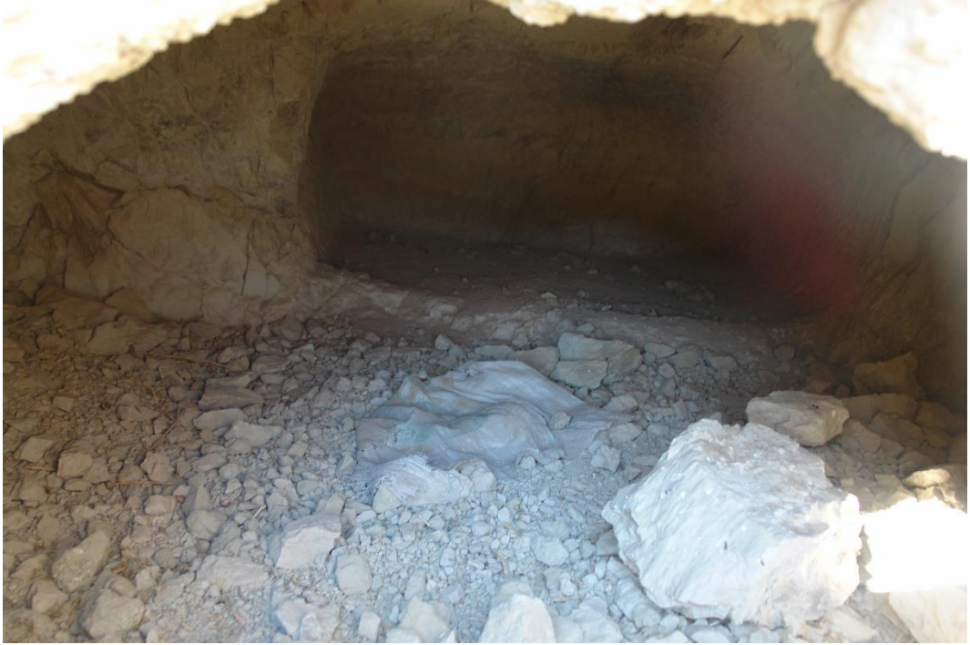
Res. 148: Kuzey nekropolisi kaya mezarı oda içi ve arcosolium, ön cephesi yıkılmış durumda. M258 (2007-2009 Tripolis kazı arşivi)
