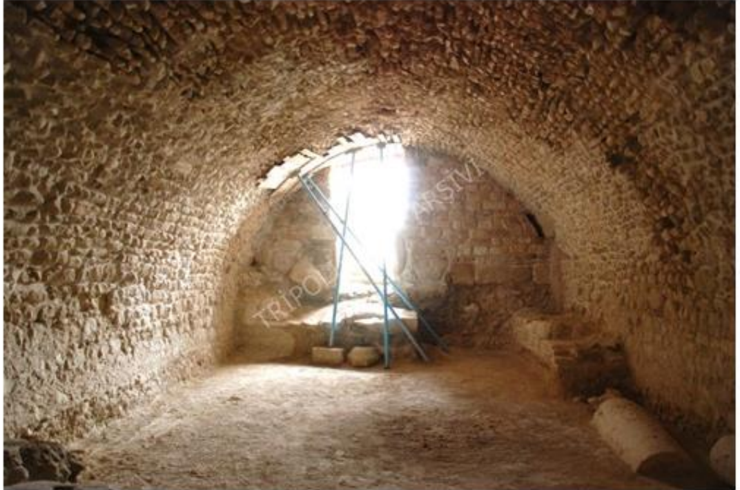
Res.114: Tripolis Kenti içindeki kazısı yapılan tonozlu yapı ( http://www.pau.edu.tr/tripolis/tr/sayfa/tonozlu-yapi-2 )
